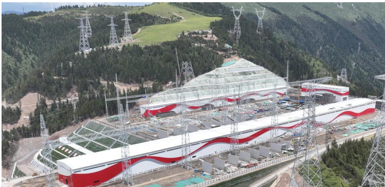
图 3.1-1 阿坝 1000kV 变电站站址现状
