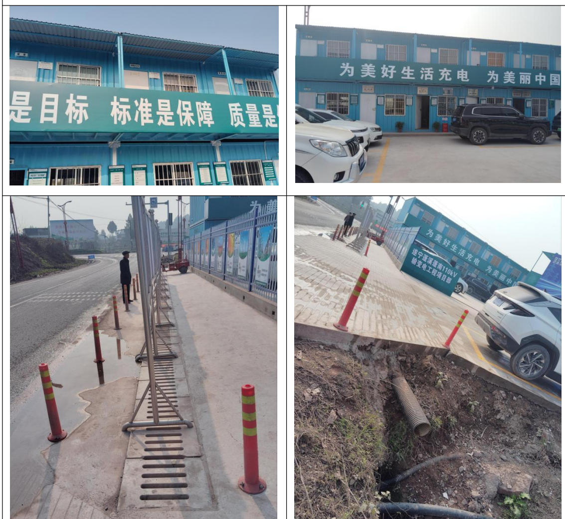
施工项目部现状
