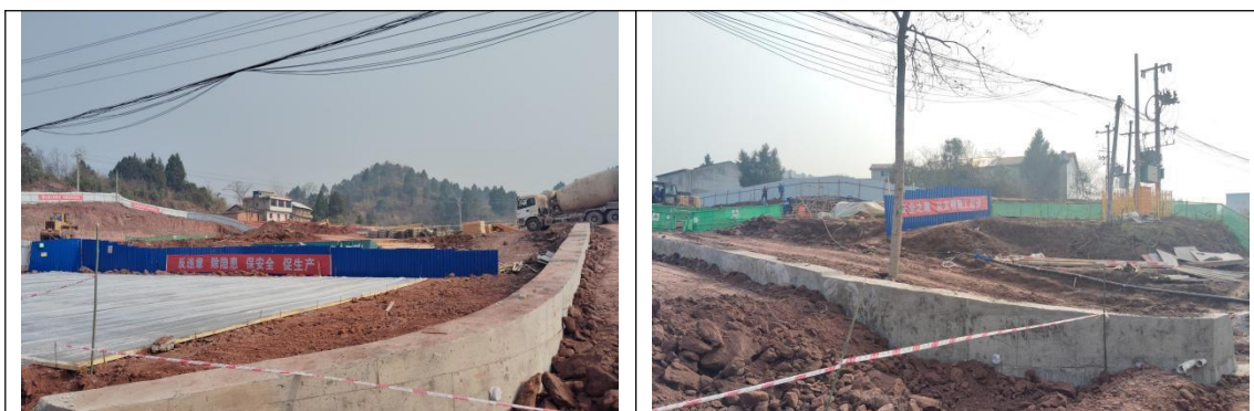
蓬南 110 千伏变电站新建工程现状
