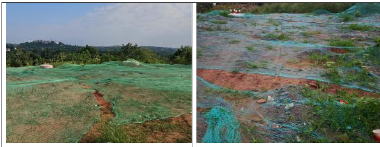
图5.3-4密目网苫盖措施
