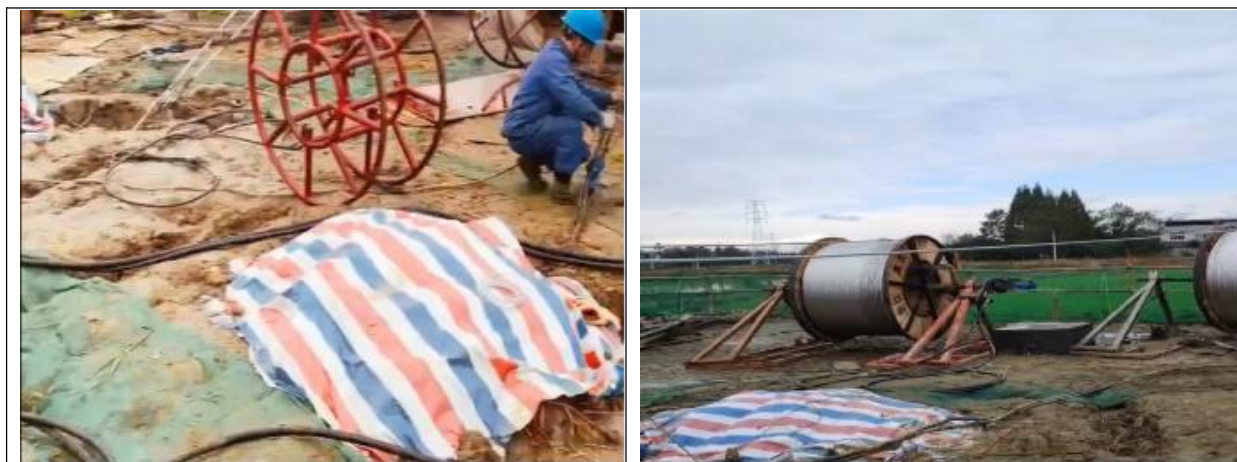
图5.3-12 彩条布铺垫措施
