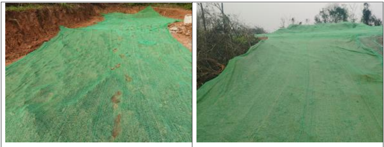
图5.3-8密目网苫盖措施
