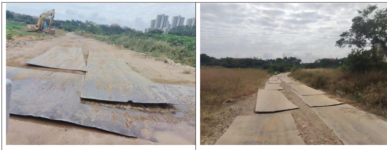
图5.3-9钢板铺垫措施
