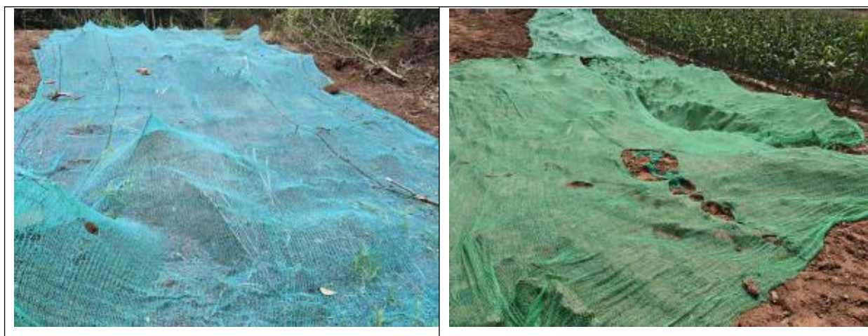
图5.3-14密目网苫盖措施
