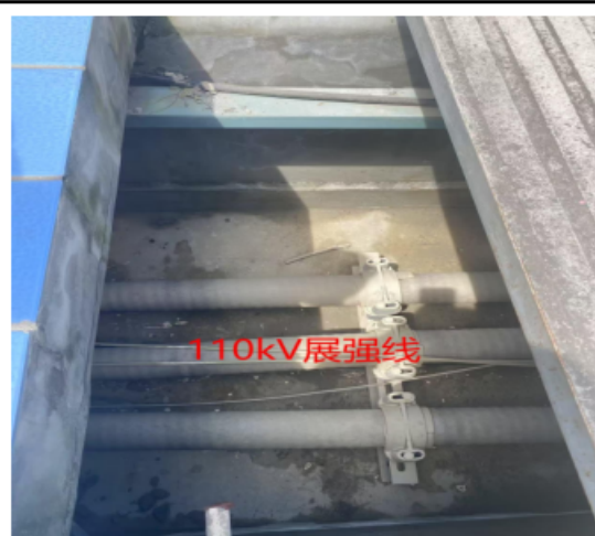
110kV 康强站出线浅沟断面 (A-B)
