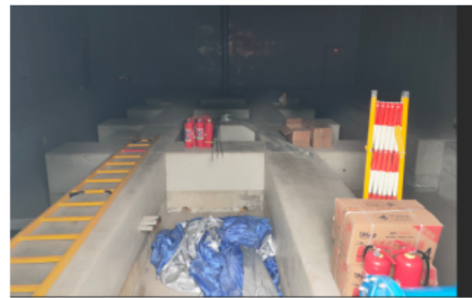
预留 3#主变室基础
