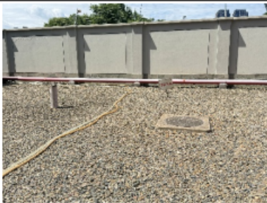
既有事故油池
