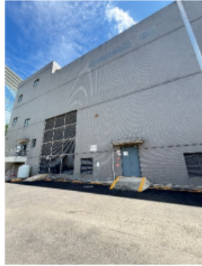
1 号主变隔声门、吸音墙及消音百叶窗
