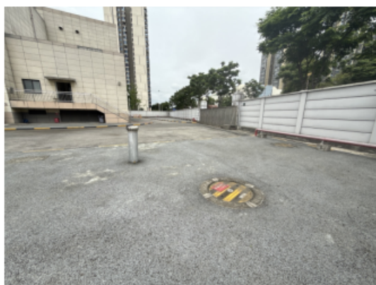
既有事故油池
