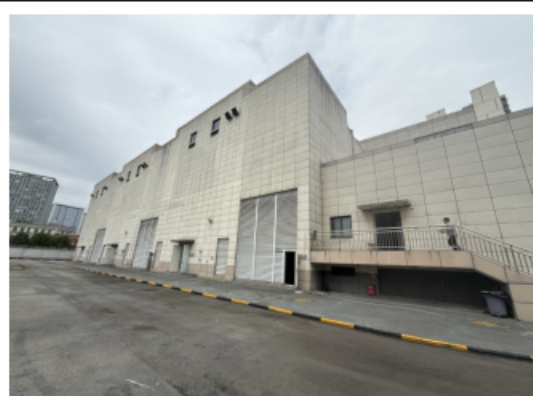
生产综合楼、消音百叶窗及垃圾桶
