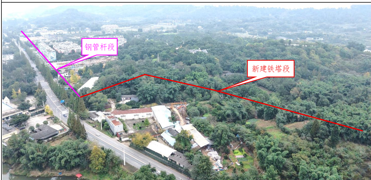
新建钢管杆及铁塔段沿线地形地貌
