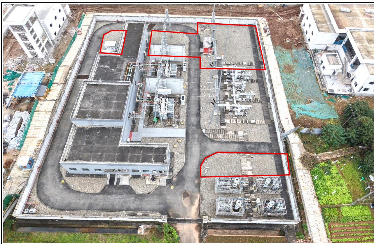
新津 110kV 变电站现状及扩建范围
