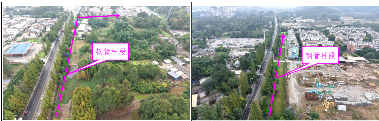
新建钢管杆段沿线地形地貌
