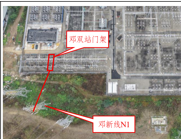
利旧合并段更换导线：220kV 邓双站门架-1#邓新线
