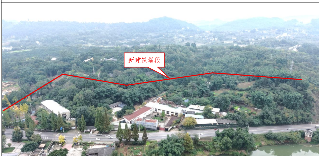
新建铁塔段沿线地形地貌
