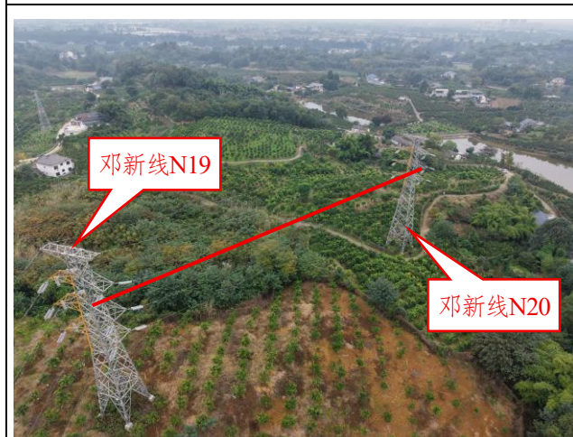
利旧合并段更换导线：19#-20#段邓新线
