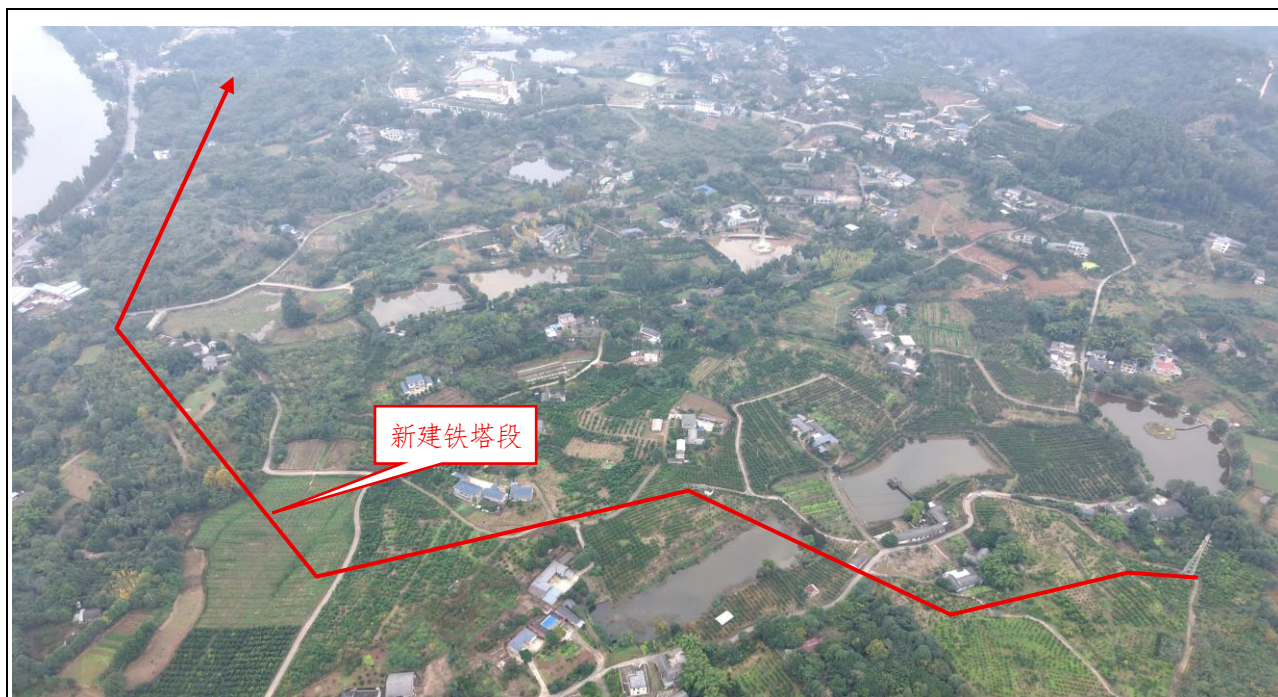
新建线路起点段地形地貌
