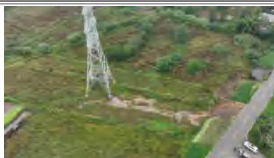
长朗线 N119 塔基及施工道路-2025.9
