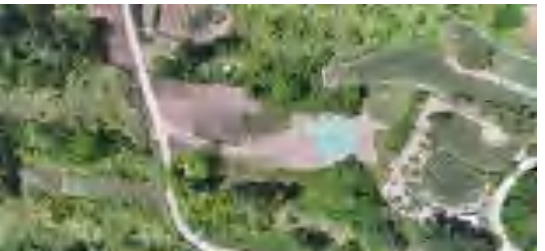
\pi 接线 N42 施工便道-2025.6
