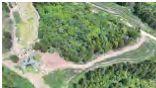
长朗线 N80 施工便道-2025.7
