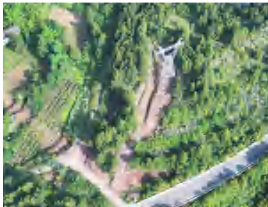
长朗线 N41 施工便道-2025.7
