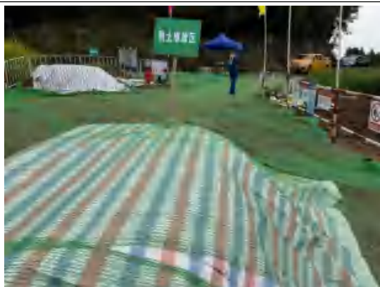
塔基表土剥离及保护-长朗线 N97-2025.5
