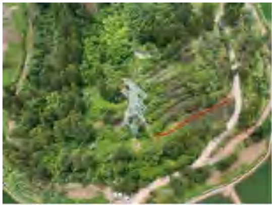
施工道路绿化（ \pi 接线 N42）
