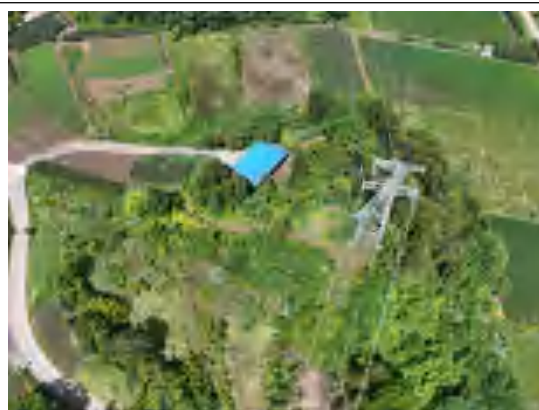
π 接线 N35 施工道路恢复后-2026.6
