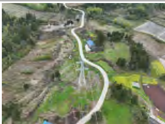
π 接 N33 塔基及施工道路-2026.3
