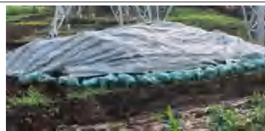
施工道路土袋拦挡- \pi 接线 N34-2025.5
