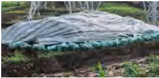
施工道路土袋拦挡-π接线 N34
