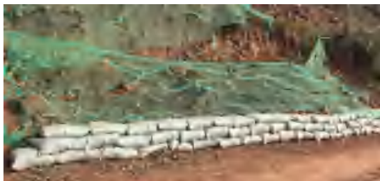
施工道路土袋拦挡-长朗线 N41
