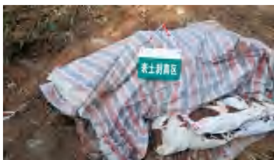
塔基苫盖及拦挡- \pi 接线 N11
