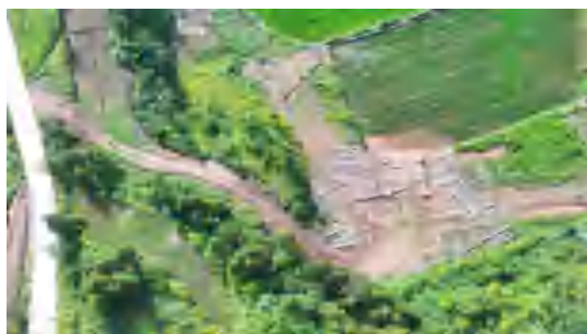
长朗线 N42 施工便道-2025.7
