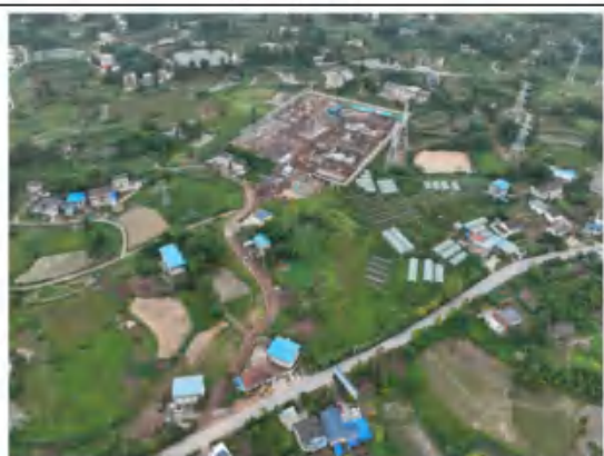
进站道路及施工临时设施区
