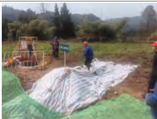
塔基表土剥离及保护-长朗线 N78-2025.4
