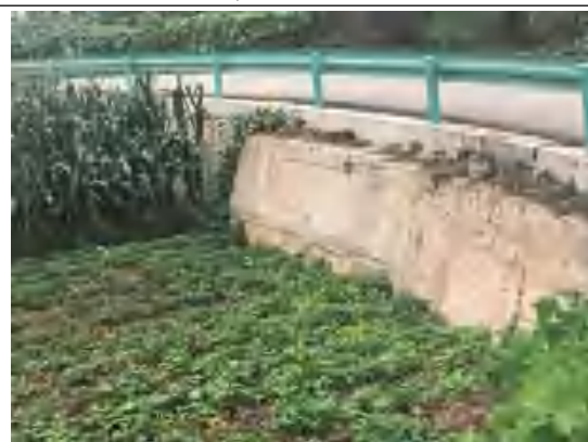
进站道路挡土墙 2026.6
