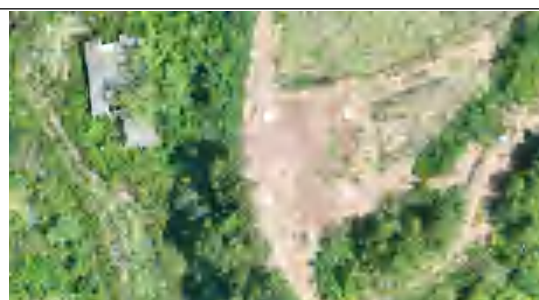
长朗线 N15 塔基及人抬道路-2025.6
