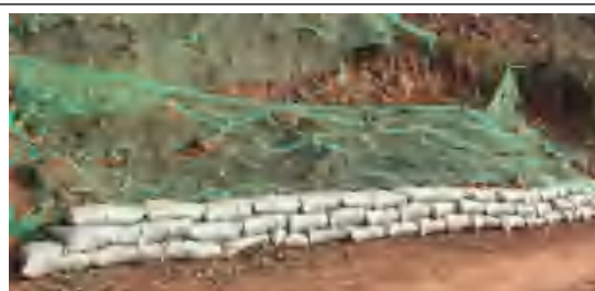
施工道路土袋拦挡-长朗线 N41-2025.6
