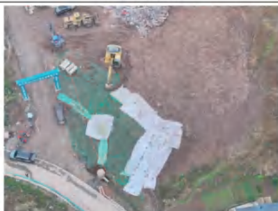
施工临时设施区
