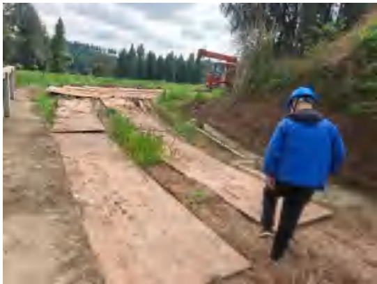
施工道路铺设钢板-π接线 N45
