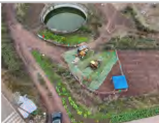
π 接线 N38 牵张场使用中-2025.12
