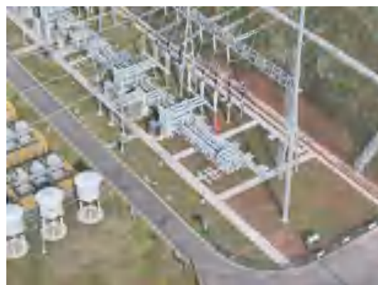
长坪山变电站间隔扩建绿化
