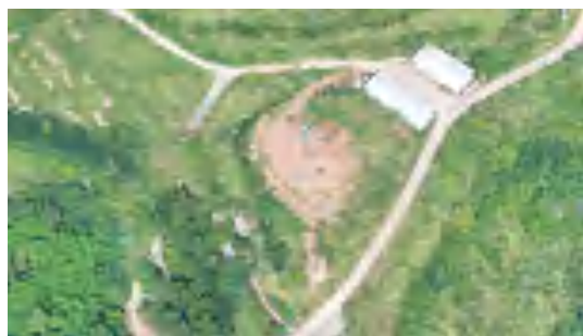
长朗线 N55 施工便道-2025.7
