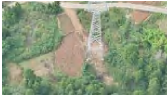
\pi 接线 N21 施工便道-2025.11
