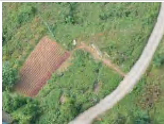
π 接 N33 塔基及施工道路-2025.12
