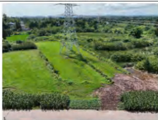
长朗线 N119 施工道路
