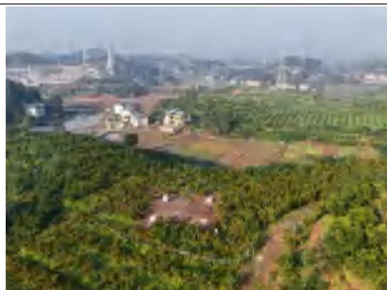
长坪山间隔扩建余土在长朗线 N3 塔处平摊-2025.8
