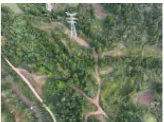
长朗线 N101 施工便道-2025.11
