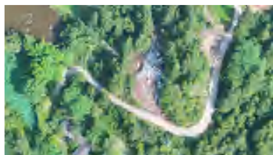
长朗线 N61 施工便道使用中-2025.7
