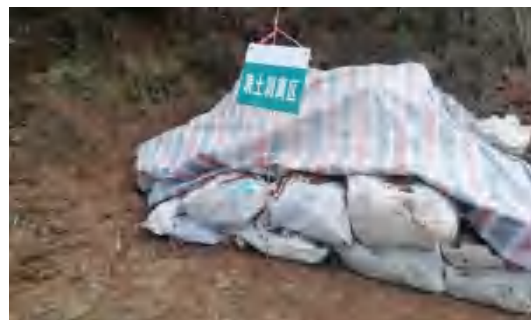
塔基苫盖及拦挡- \pi 接线 N24
