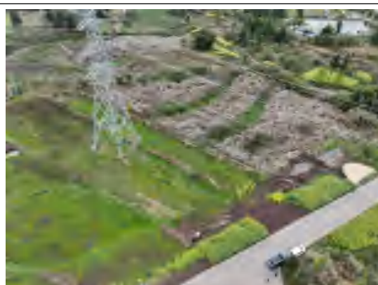
长朗线 N119 塔基及施工道路-2026.3
