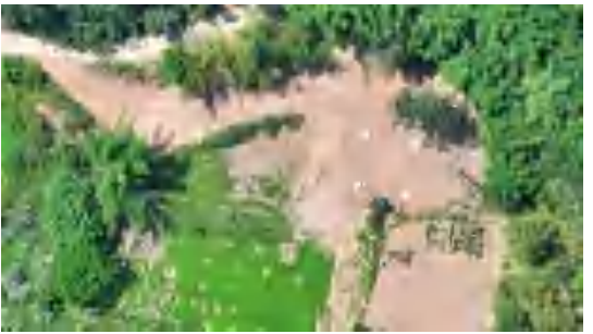
\pi 接线 N31 施工便道-2025.6
