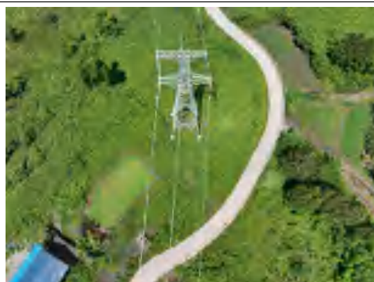
π 接 N33 塔基及施工道路-2026.6
