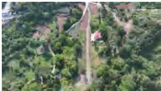
\pi 接线 N27 施工便道-2025.6
