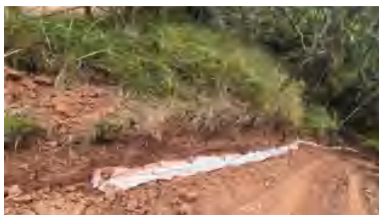
施工道路临时排水沟-长朗线 N39
