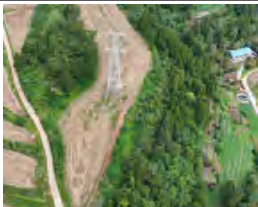
长朗线 N81 塔基及施工道路-2025.9
