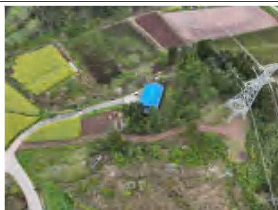
π 接线 N35 施工道路使用中-2026.3
