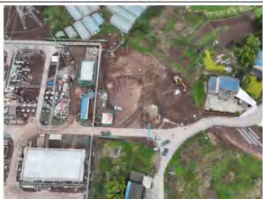
施工临时设施区
