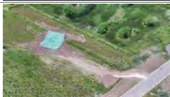
长朗线 N119 塔基及施工道路-2025.6
