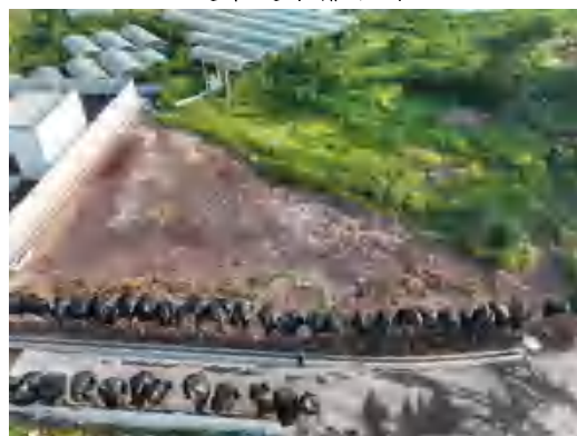
施工临时设施区覆土及土地整治
