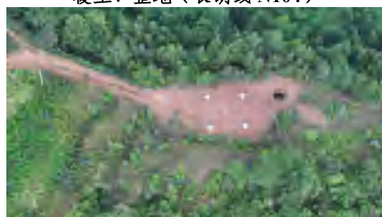
覆土、整地（ \pi 接线 N12）
