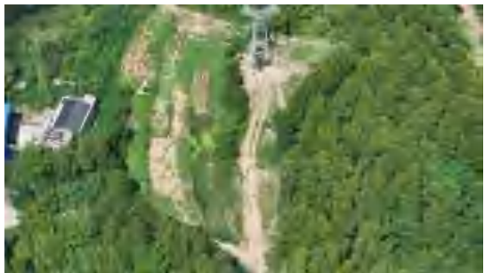
\pi 接线 N23 施工便道-2025.8
