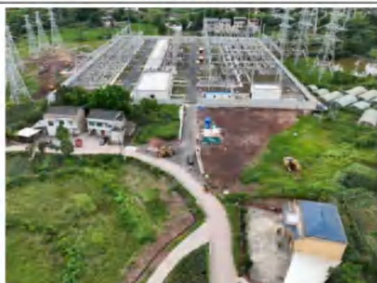
施工临时设施区
