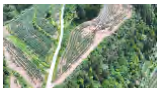
长朗线 N81 施工便道-2025.7
