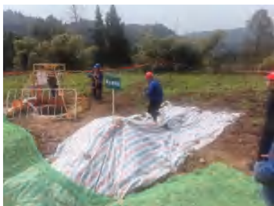
塔基临时苫盖-长朗线 N74
