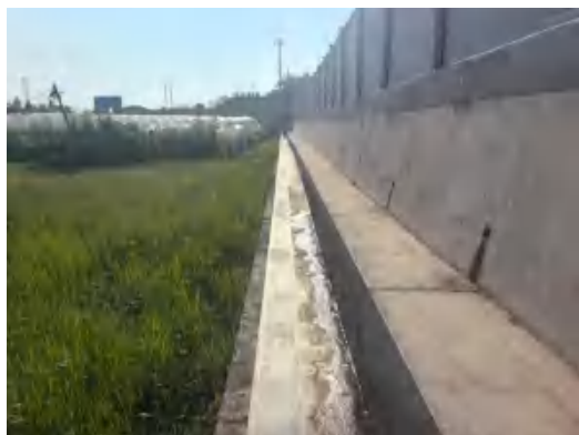
朗池站外排水沟
