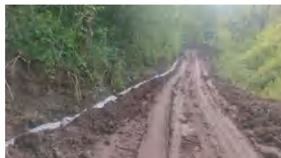
施工道路临时排水沟- \pi 接线 N35
