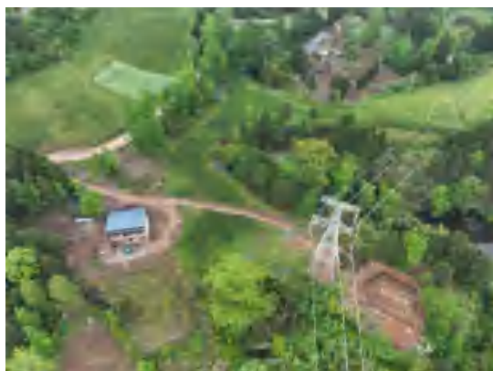
长朗线 N13 施工便道-2026.4
