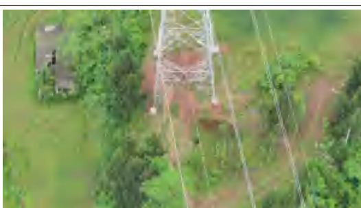
长朗线 N15 塔基及人抬道路-2026.3
