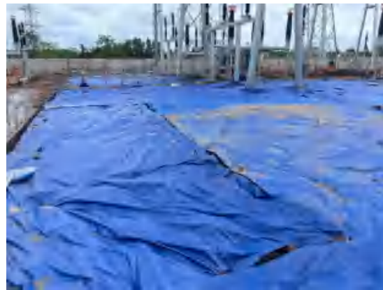
变电站临时苫盖
