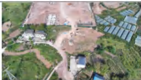
进站道路及站外施工临时设施
