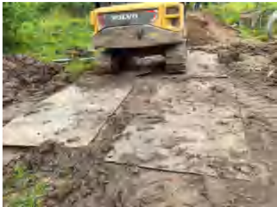
施工道路铺设钢板-长朗线 N49
