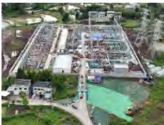
朗池 220kV 变电站施工临时设施 (2026.4)
