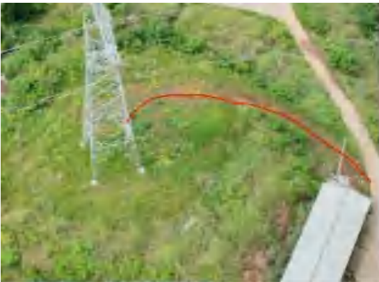
施工道路绿化（长朗线 N55）
