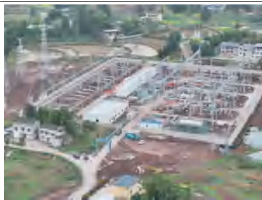
新建变电站区及施工临时设施区-2026 年 3 月
