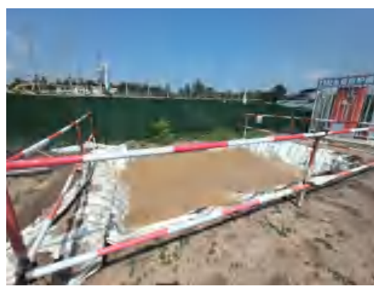
变电站临时沉沙池
