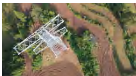
长朗线 N15 塔基及人抬道路-2025.12
