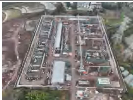
新建变电站区及施工临时设施区-2025 年 12 月
