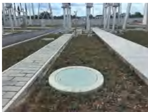
雨水井及透水铺装
