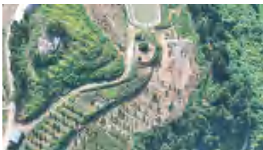
长朗线 N68 施工便道-2025.7
