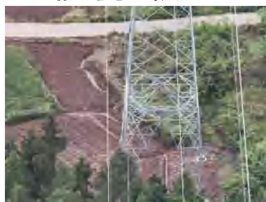
施工道路土地整治（ \pi 接线 N21）
