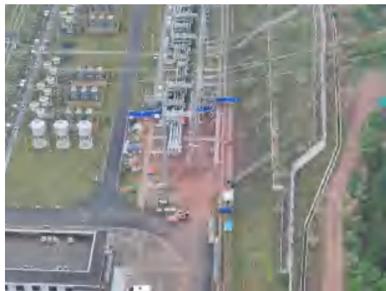
长坪山 500kV 变电站间隔扩建工程 (2026.4)
