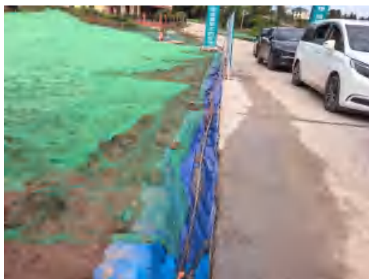
站外施工临时设施临时排水沟
