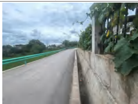
进站道路排水沟 2026.6
