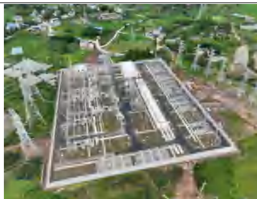
新建变电站区及施工临时设施区-2026 年 6 月
