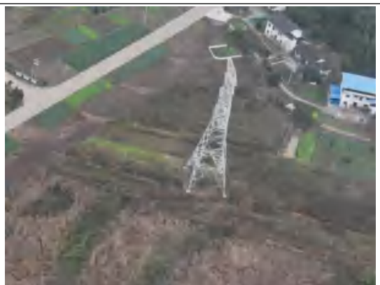
长朗线 N119 塔基及施工道路-2025.12
