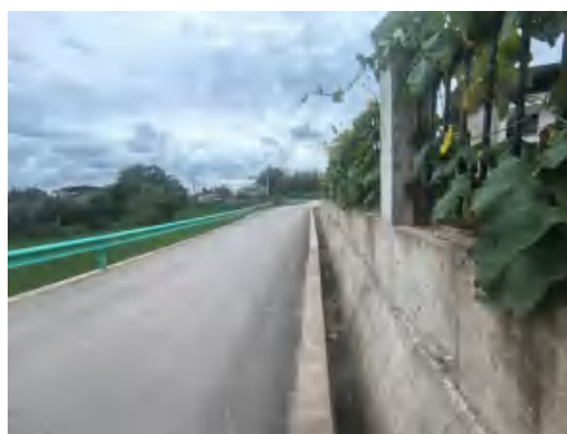
进站道路排水沟
