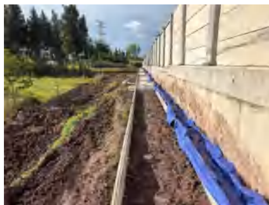
站外临时排水沟
