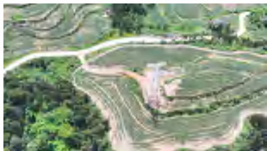
长朗线 N78 施工便道-2025.7
