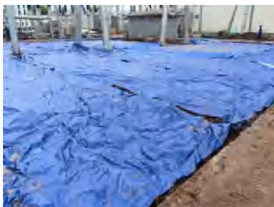
变电站临时苫盖
