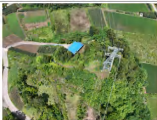
■ 接线 N35 施工道路
