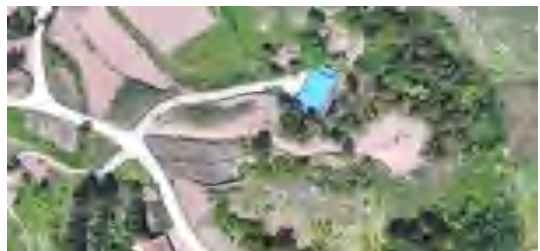
\pi 接线 N35 施工便道-2025.6
