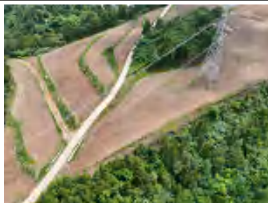
长朗线 N81 塔基及施工道路-2026.6
