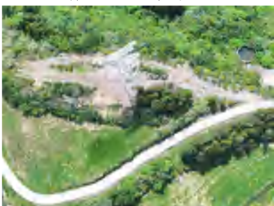
长朗线 N83 施工便道-2025.7
