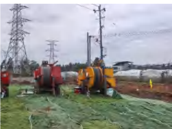
、站外施工临建设施用作牵张场-2026.3
