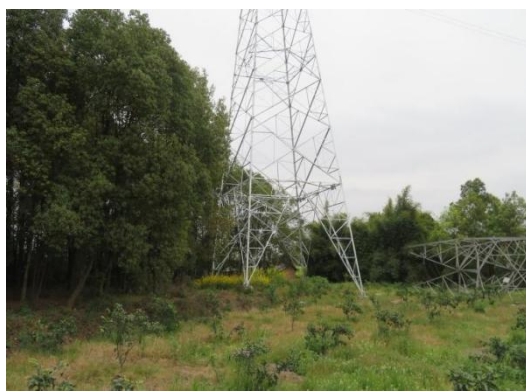
N722#新建铁塔
