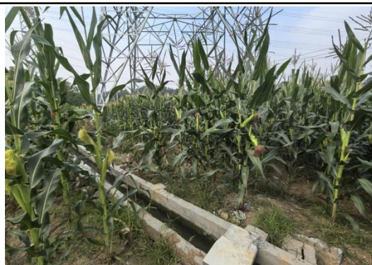
N749#新建铁塔
