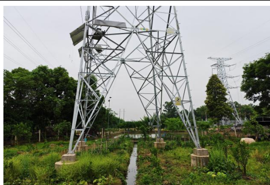
N752R#新建铁塔
