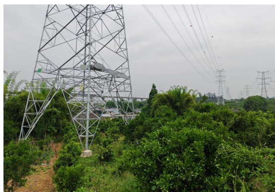
N713#新建铁塔
