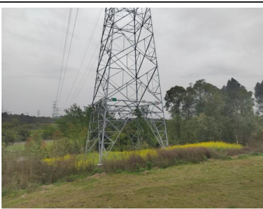
N741#新建铁塔
