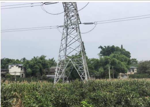
N802#新建铁塔
