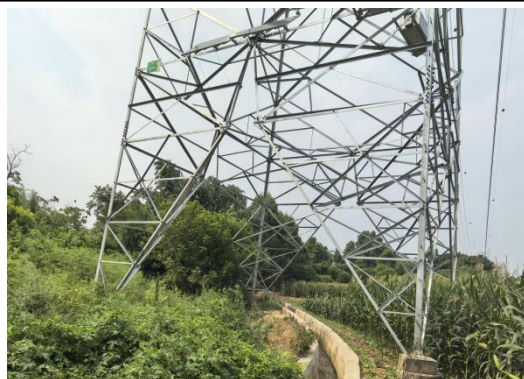
N726#新建铁塔
