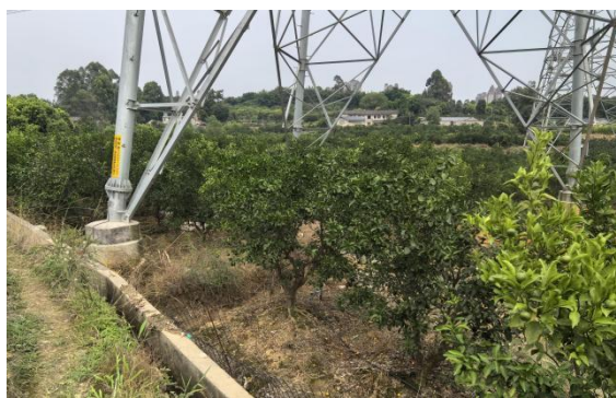
N709#新建铁塔
