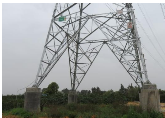
N718#新建铁塔
