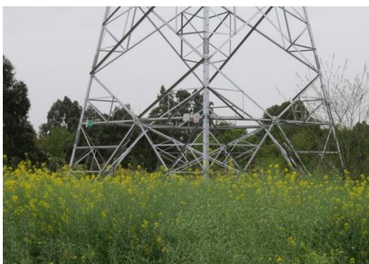
N730#新建铁塔
