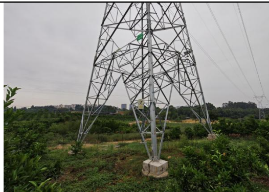
N751L#新建铁塔
