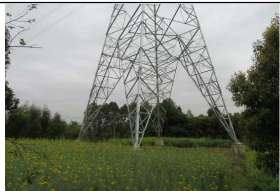
N734#新建铁塔
