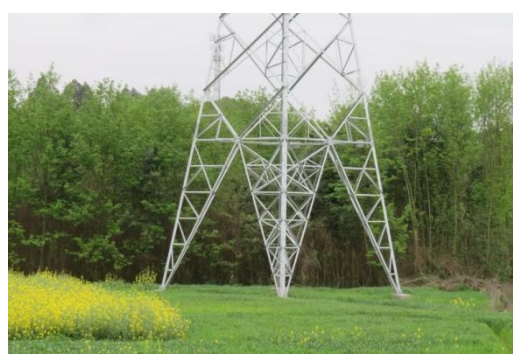
N903#新建铁塔
