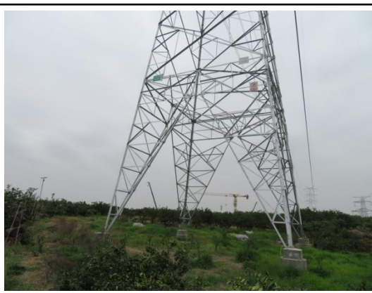
N716#新建铁塔
