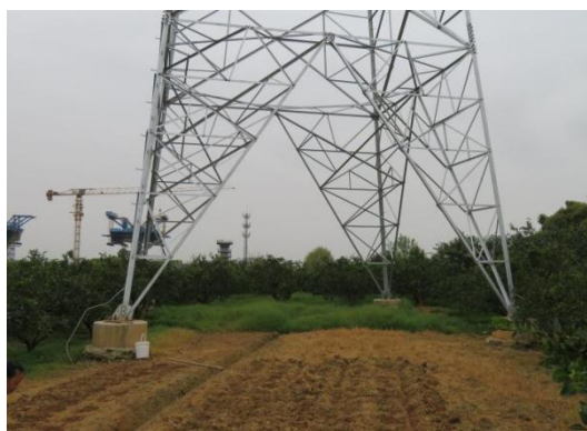
N714#新建铁塔
