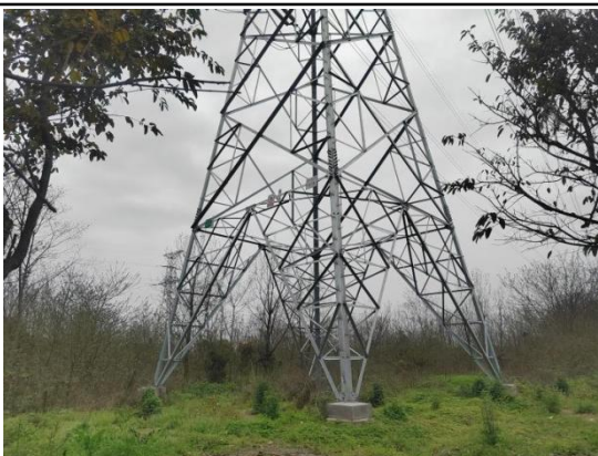
N740#新建铁塔
