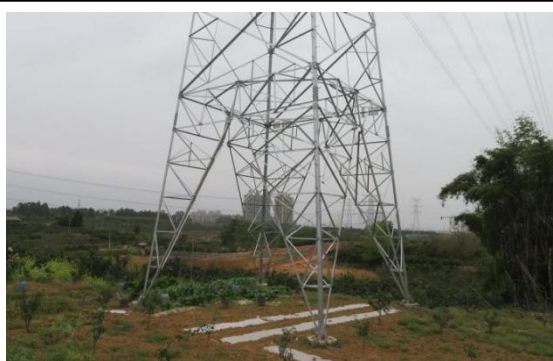
N719#新建铁塔
