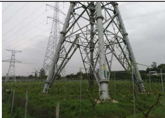
N710#新建铁塔
