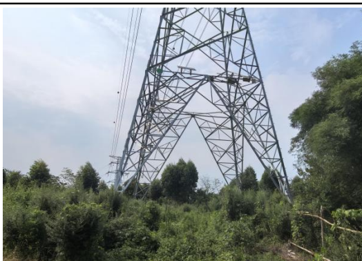
N735#新建铁塔
