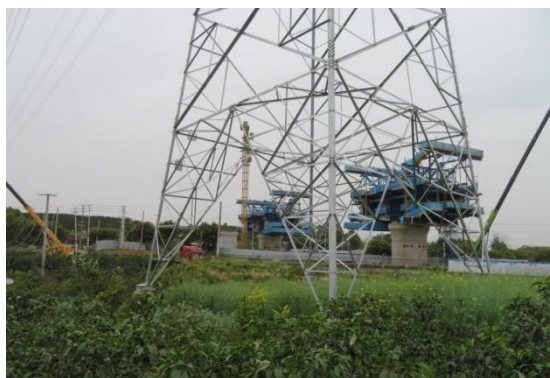
N717#新建铁塔
