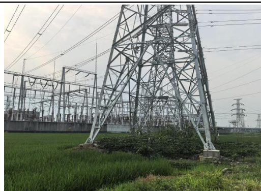
N756L#新建铁塔
