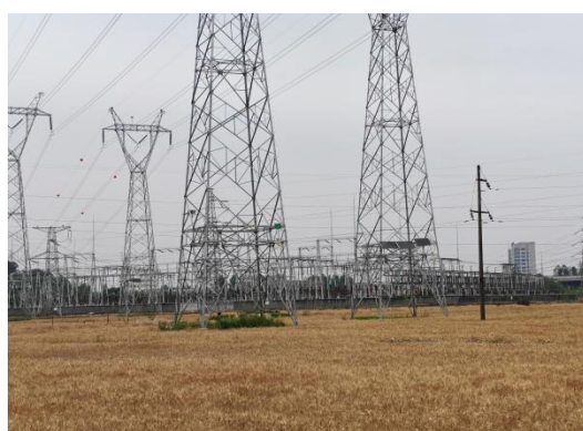
N754L#新建铁塔
