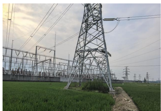
N756R#新建铁塔
