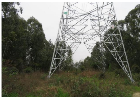
N723#新建铁塔
