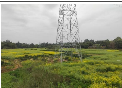
N739#新建铁塔
