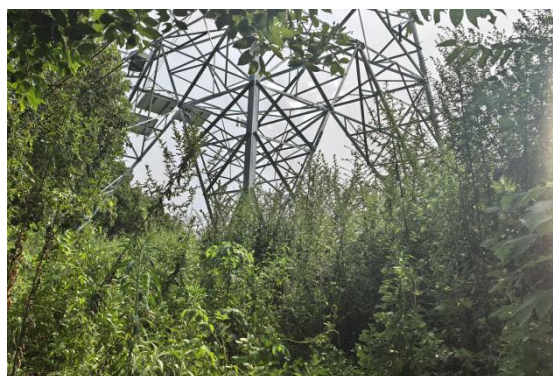
N729#新建铁塔
