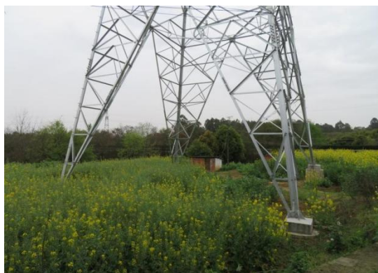
N736#新建铁塔
