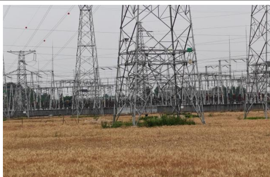
N754R#新建铁塔
