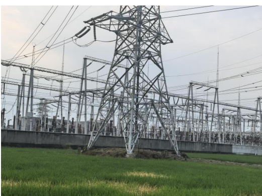
N901#新建铁塔
