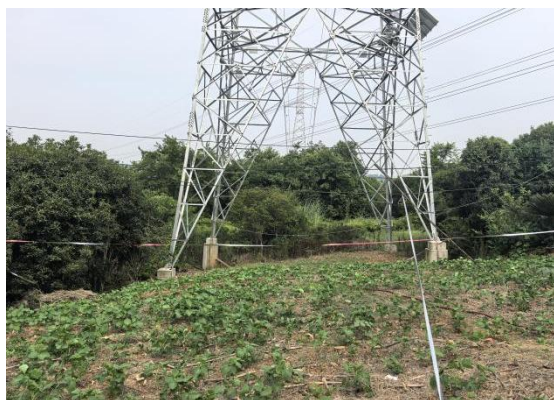
N744#新建铁塔
