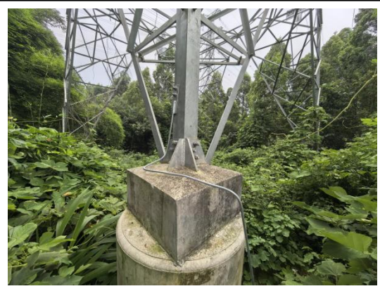
N604#新建铁塔
