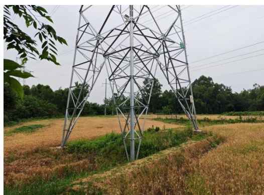
N752L#新建铁塔
