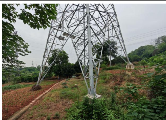
N746#新建铁塔
