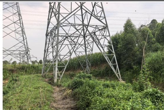
N605#新建铁塔
