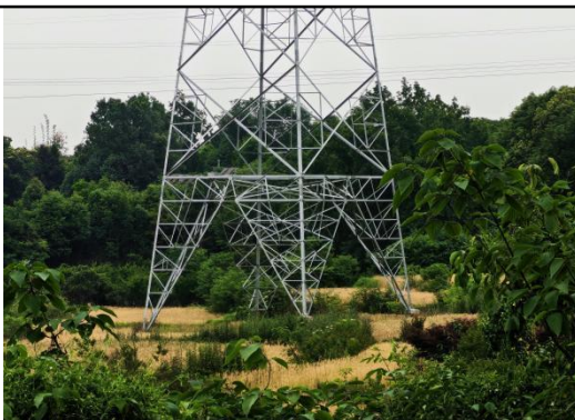
N743#新建铁塔
