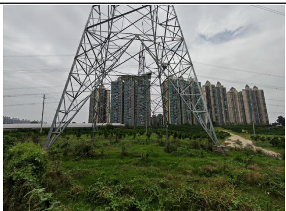
N715#新建铁塔
