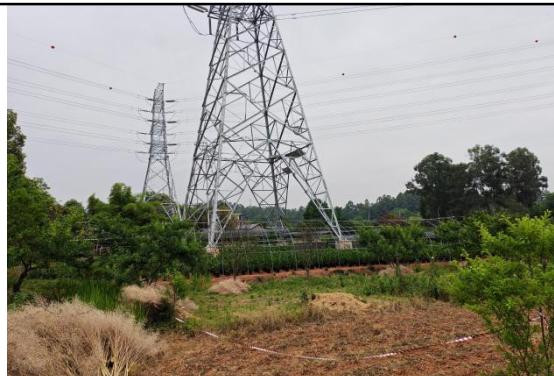
N750#新建铁塔
