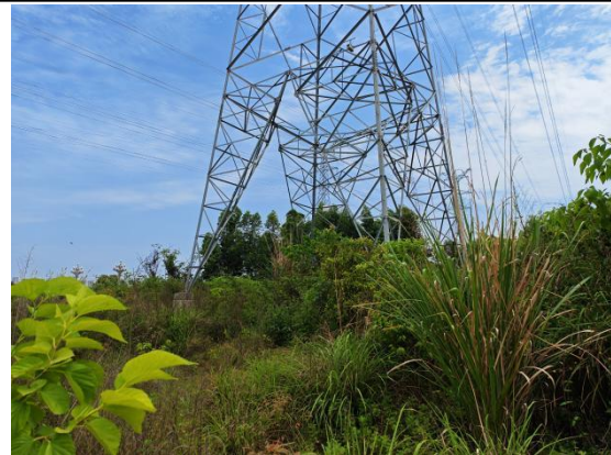
N603#新建铁塔
