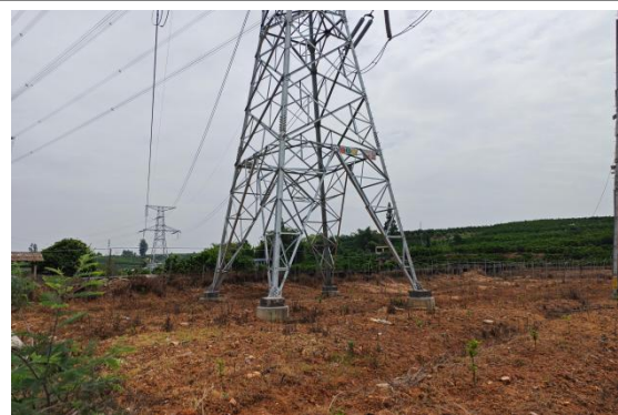
N801#新建铁塔
