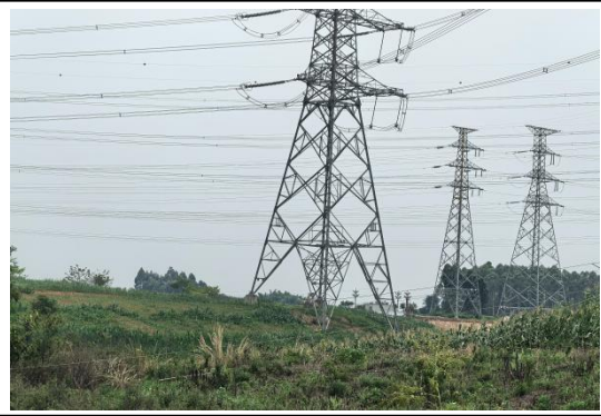
N602G#新建铁塔
