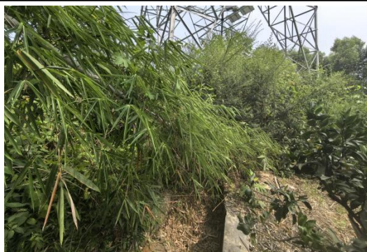
N720#新建铁塔
