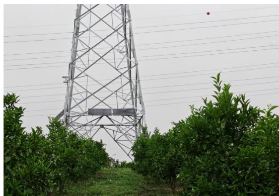
N751R#新建铁塔
