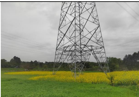
N742#新建铁塔
