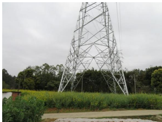
N737#新建铁塔
