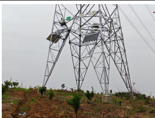
N747#新建铁塔
