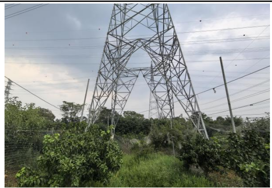
N606#新建铁塔
