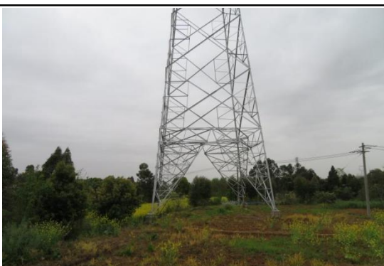
N738#新建铁塔
