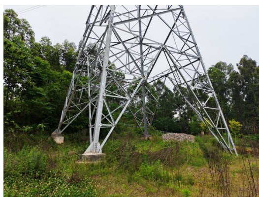
N745#新建铁塔
