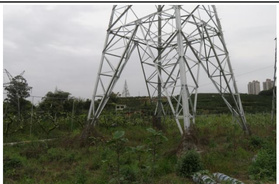
N711#新建铁塔
