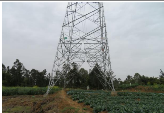
N725#新建铁塔
