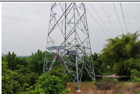
N748#新建铁塔
