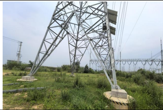
N601G#新建铁塔
