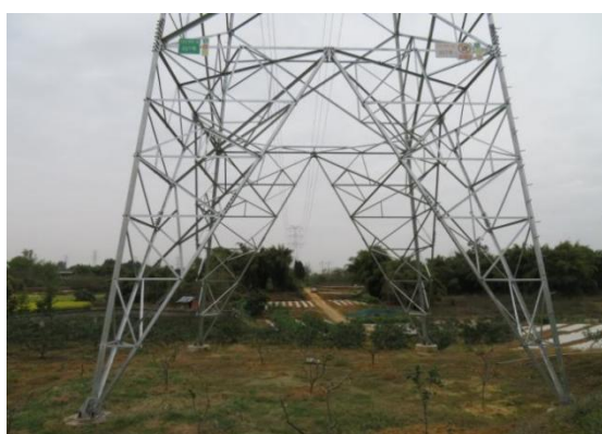
N727#新建铁塔
