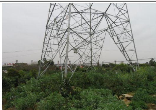
N712#新建铁塔
