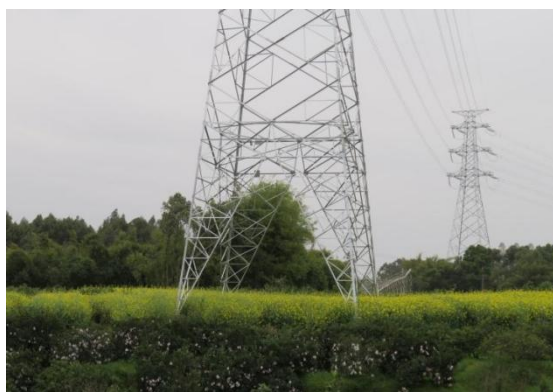
N721#新建铁塔
