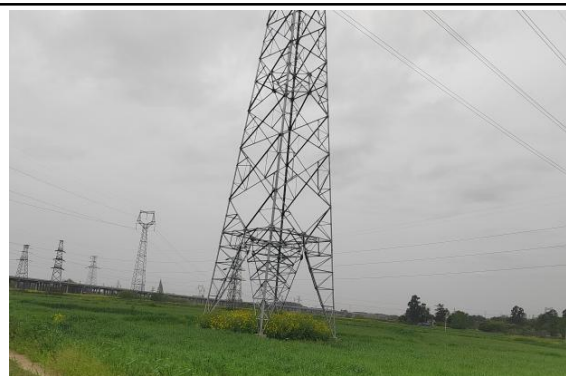
N755R#新建铁塔
