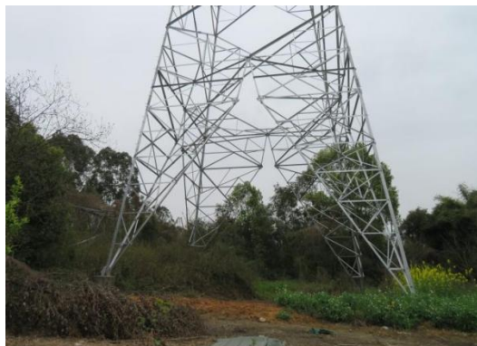
N724#新建铁塔
