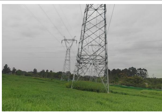
N755L#新建铁塔
