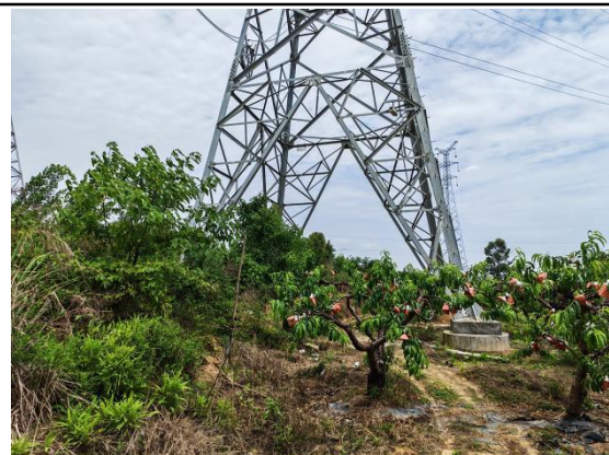
N607G#新建铁塔
