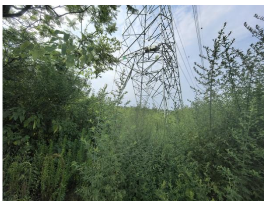
N728#新建铁塔
