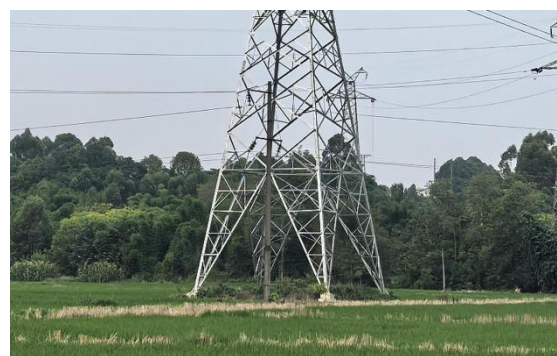
N902#新建铁塔
