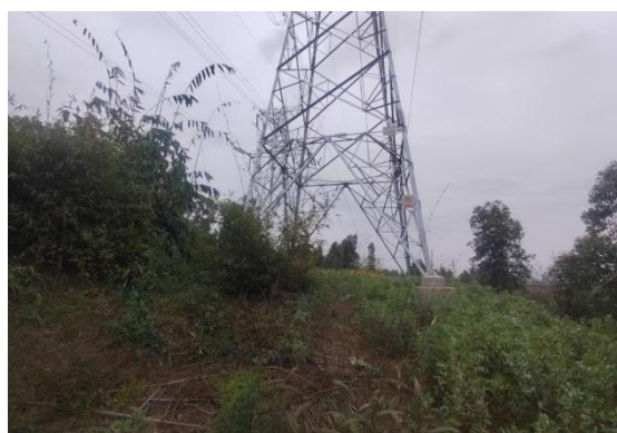
N753R#新建铁塔
