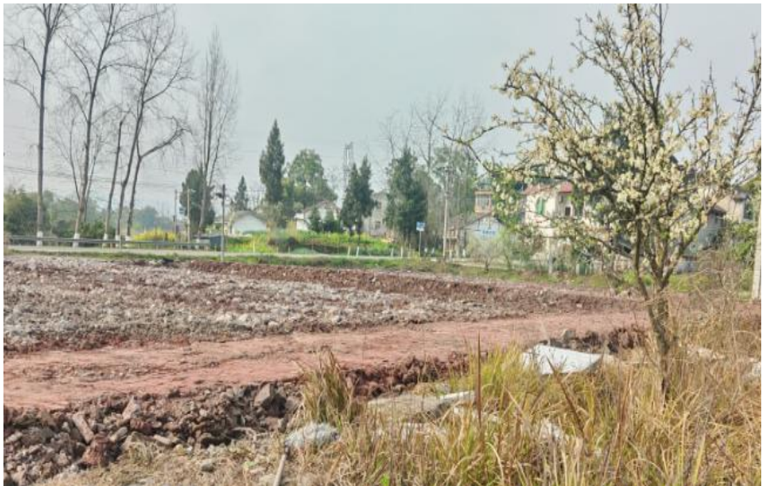
拟建高坪御史 110kV 变电站处照片
