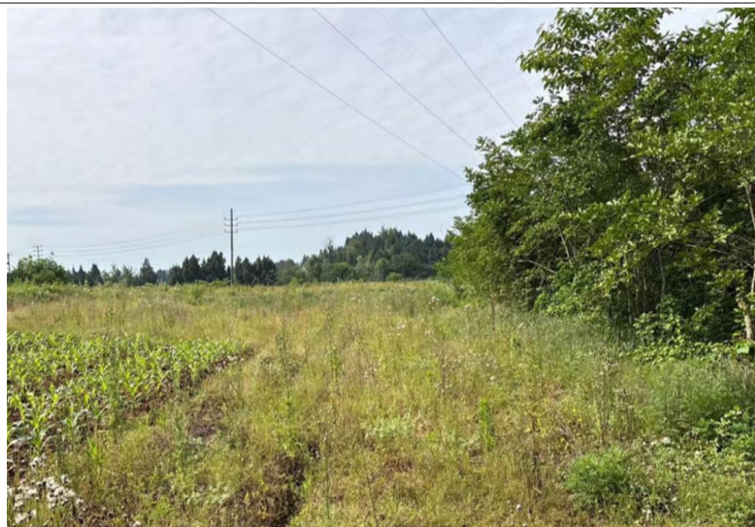
蓬安~御史 110KV 线路工程沿线照片
