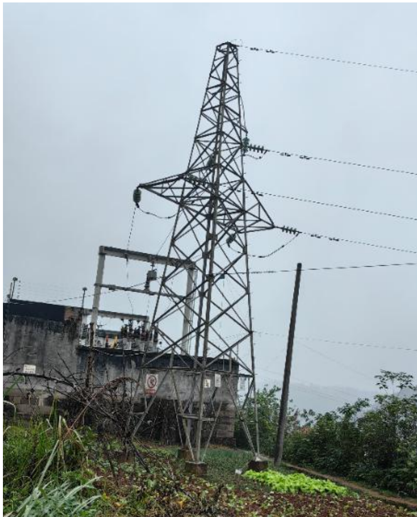
赤城-鸣凤 35kV 线路改造工程起点-35#塔
