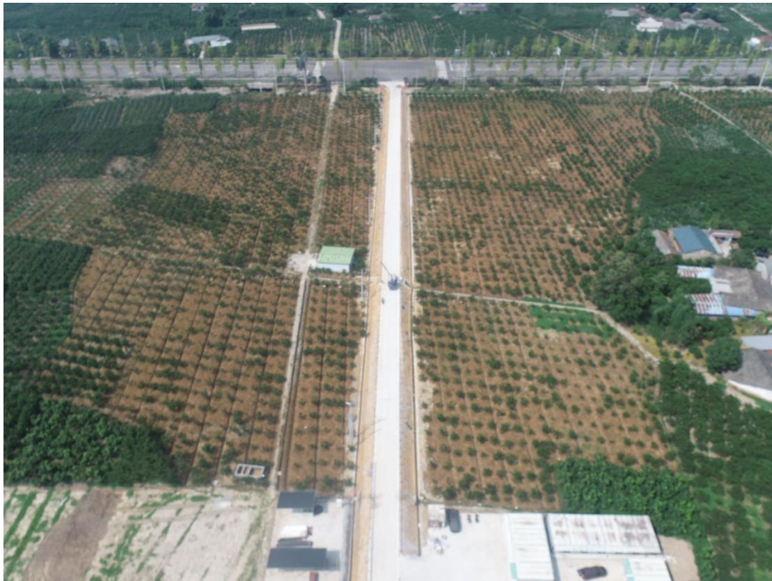
变电站利用进场道路
