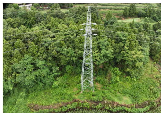
N29#新建铁塔
