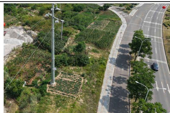
N21#新建铁塔
