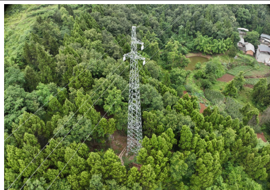
N25#新建铁塔
