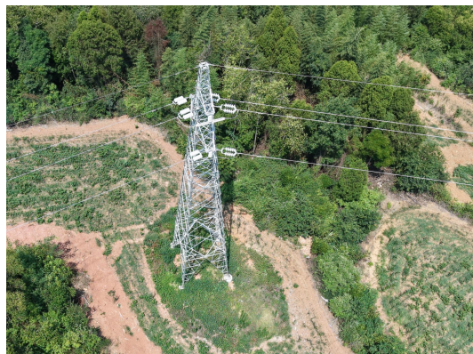
N41#新建铁塔
