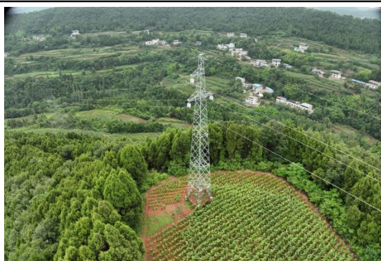
N30#新建铁塔
