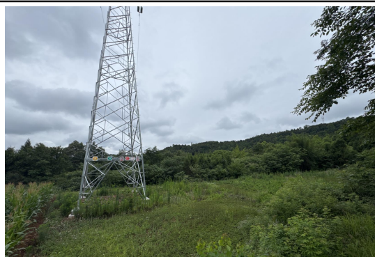
N10#新建铁塔
