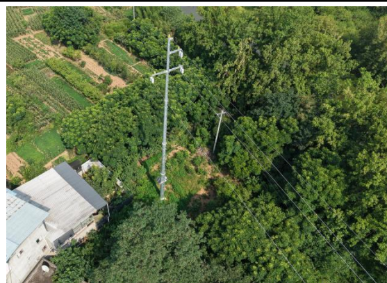
N16#新建铁塔
