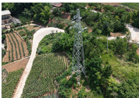
N45#新建铁塔
