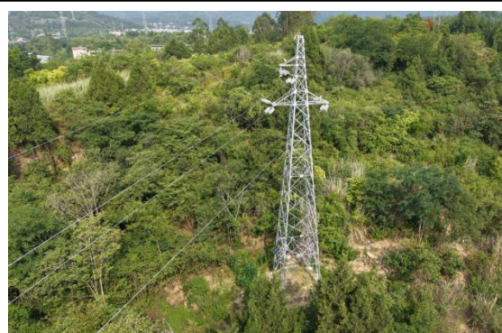
N11#新建铁塔
