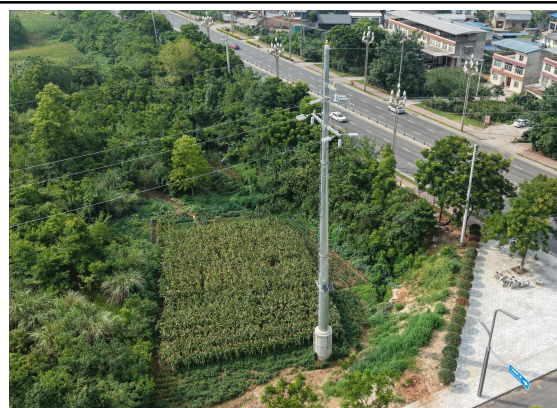
N5#新建铁塔
