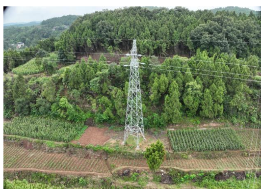
N59#新建铁塔
