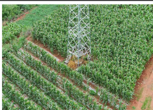
N31#新建铁塔
