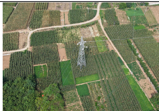
N26#新建铁塔
