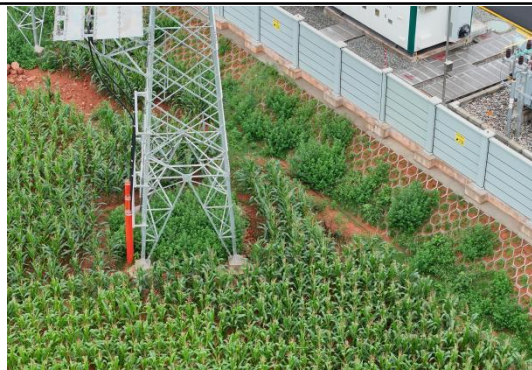
N71#新建铁塔
