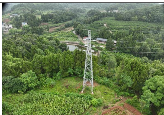
N64#新建铁塔
