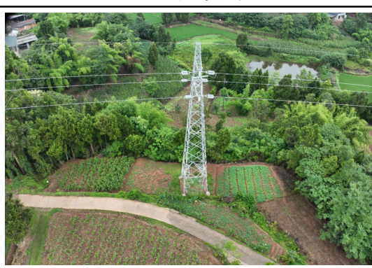
N66#新建铁塔
