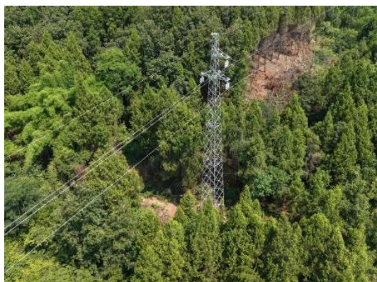
N33#新建铁塔
