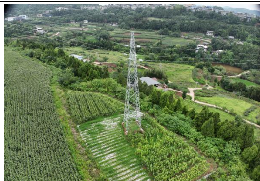
N68#新建铁塔
