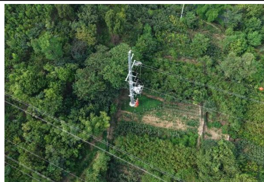
N14#新建铁塔
