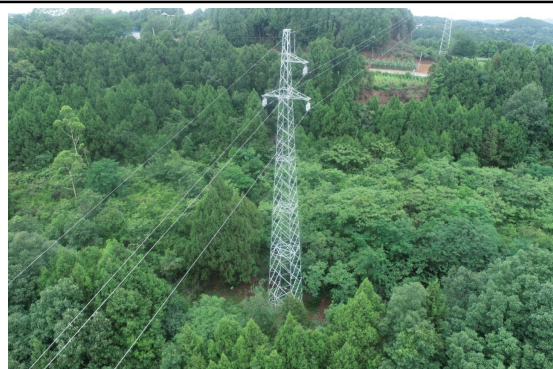
N6#新建铁塔
