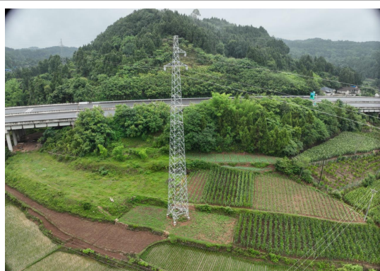
N22#新建铁塔
