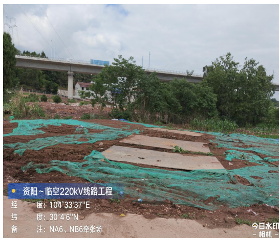
NA6、NB6 牵张场临时铺垫
