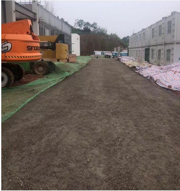
变电站主体工程区临时遮盖
