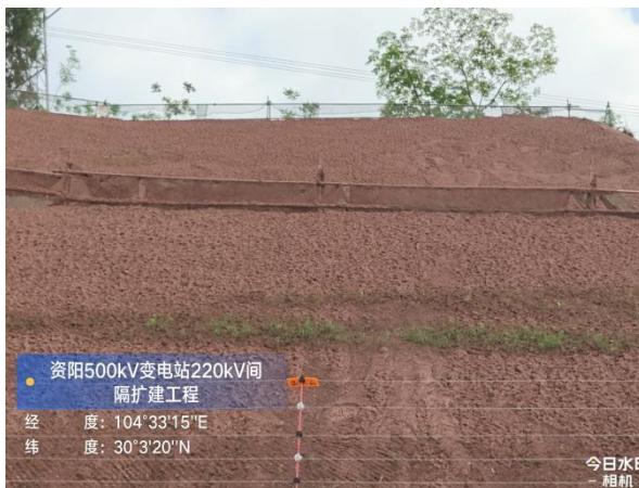
间隔扩建区生态护坡
