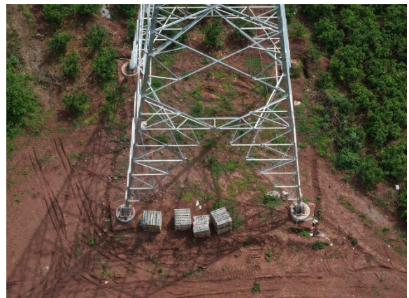
NA4 覆土、土地整治、撒播草籽
