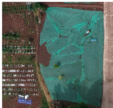
NA6、NB6 牵张场临时铺垫
