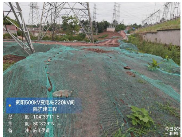
站外施工便道区临时遮盖
