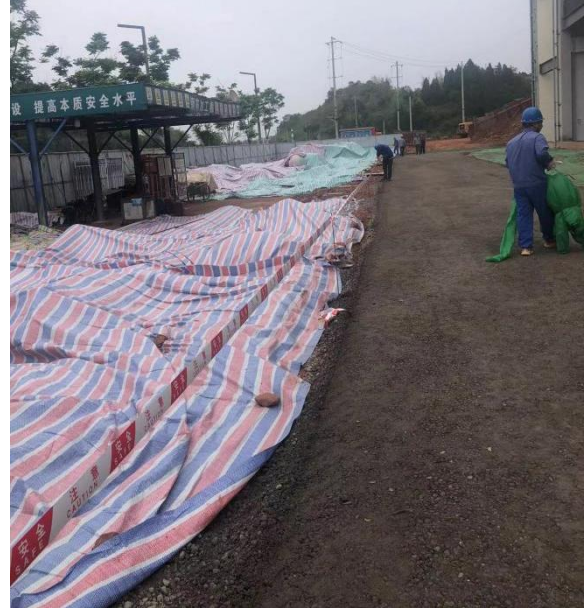
变电站主体工程区临时遮盖
