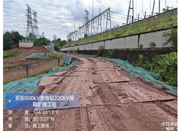
站外施工便道区临时铺垫
