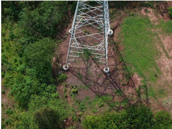
NA2 覆土、土地整治、撒播草籽
