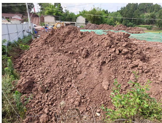
电缆施工区表土剥离
