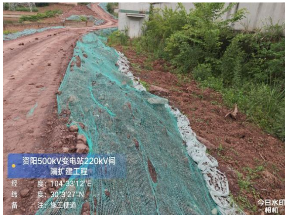
站外施工便道区临时遮盖、土袋拦挡
