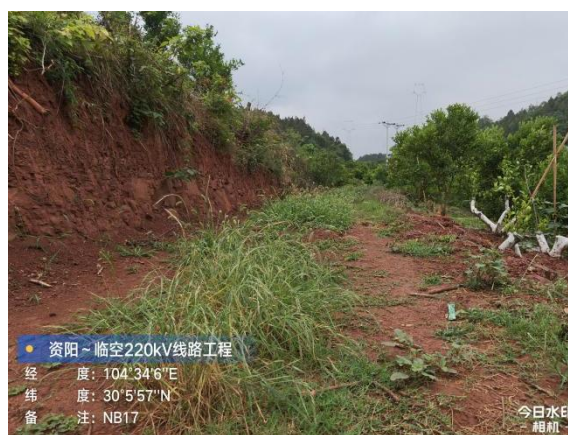
NB17 汽运道路覆土、土地整治、撒播草籽
