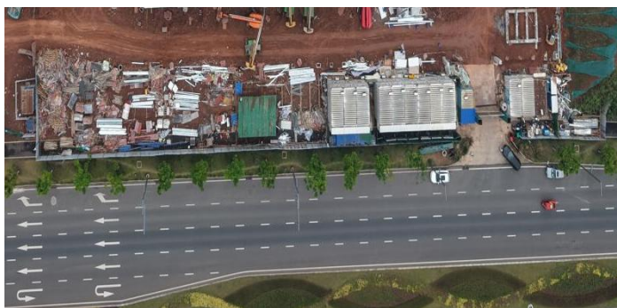
施工生产生活区现状
