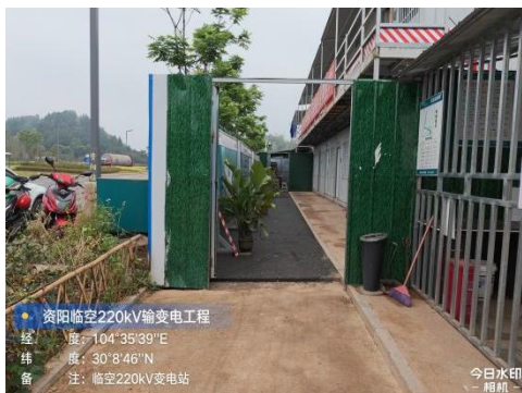
施工生产生活区现状
