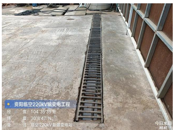
变电站主体工程区临时排水沟
