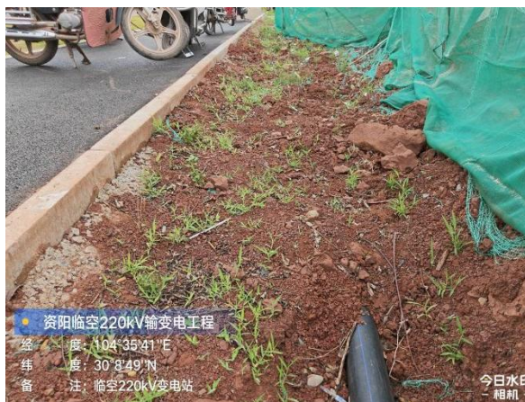
站外供水管线土地整治、绿化
