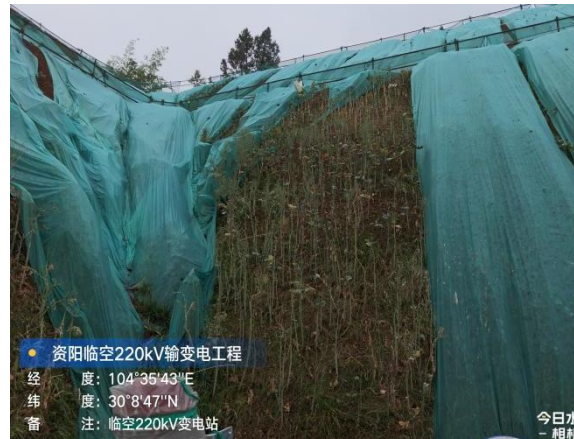
站外边坡防护区生态护坡、临时遮盖
