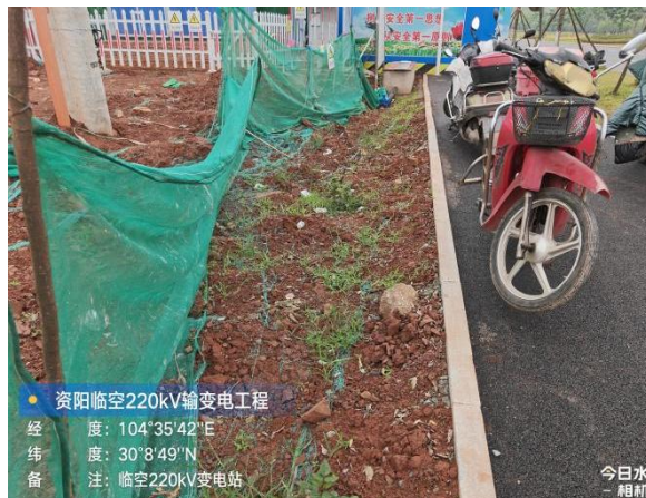
站外供水管线土地整治、绿化
