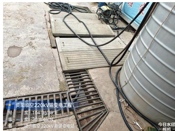
变电站主体工程区临时沉沙池
