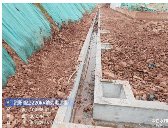
变电站主体工程区站外排水沟
