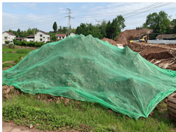
电缆施工区临时遮盖
