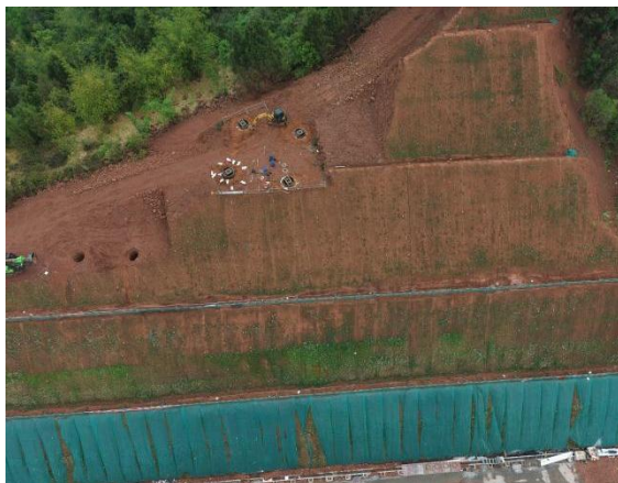
站外边坡防护区生态护坡、临时遮盖
