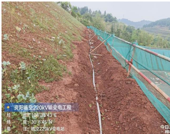
站外边坡防护区马道临时排水沟
