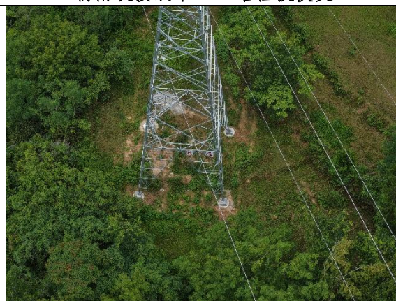
杨南改接线路 N38 塔土地整治、植被恢复
