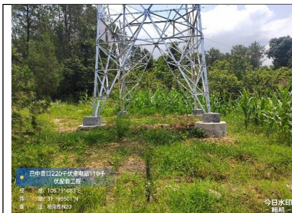
杨南改接线路 N20 塔土地整治、植被恢复
