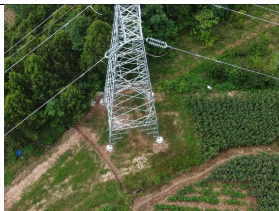
杨南改接线路 N32 塔土地整治、植被恢复
