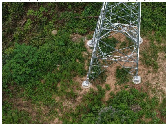
杨南改接线路 N43 塔土地整治、植被恢复
