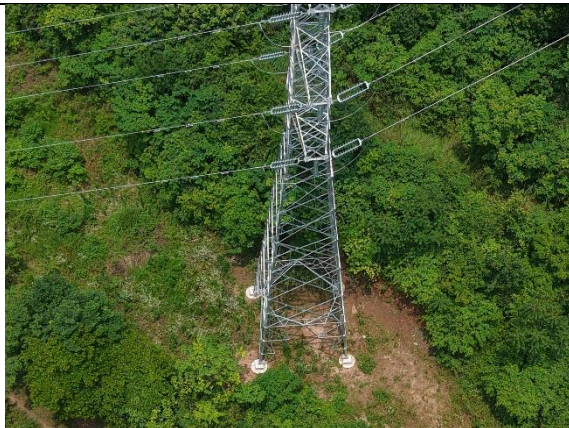
文龙二线 \pi 接线路 N18 塔植被恢复
