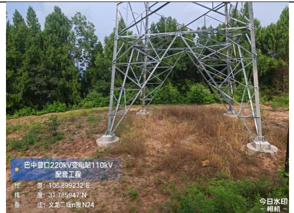
文龙二线 \pi 接线路 N24(实际 N22)塔植被恢复
