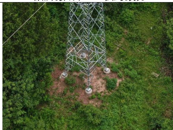
杨南改接线路 N37 塔土地整治、植被恢复
