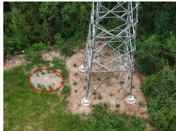
文龙二线 \pi 接线路 N5 塔砂石余料未清理，植被恢复不到位
