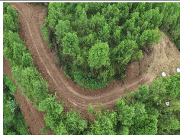
29#塔位机械化施工道路
