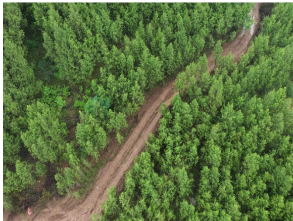
37#塔位机械化施工道路
