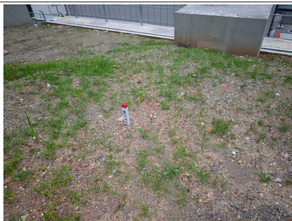
老木河站外电缆施工区域植被恢复
