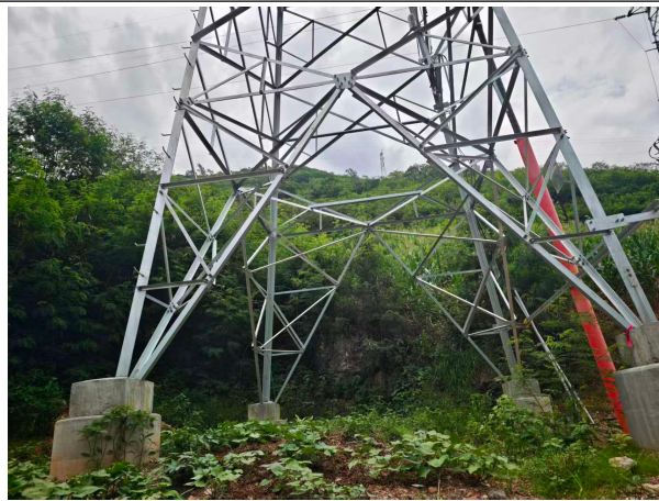
松老线改接 NS5 塔土地整治、植被恢复
