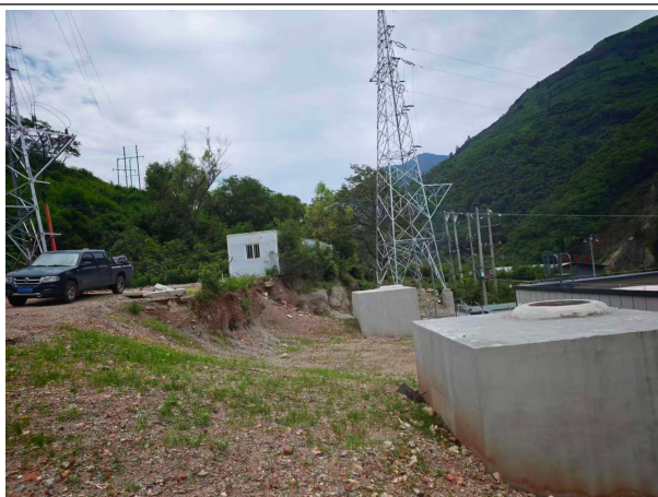
老木河站外电缆施工区域植被恢复
