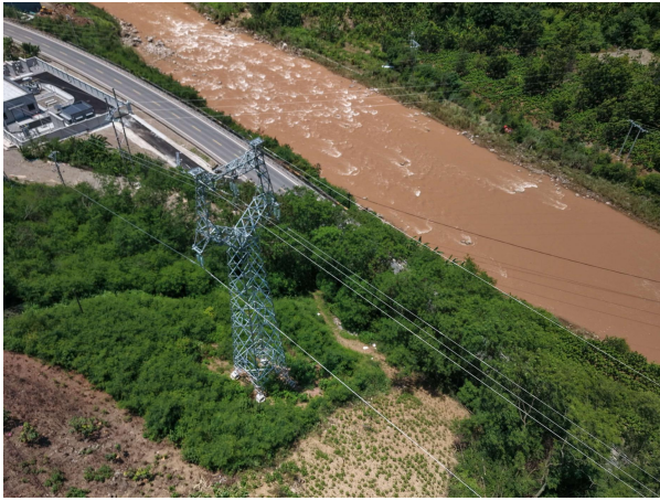
松老线改接 NS4 塔植被恢复
