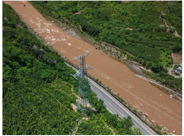
松老线改接 NS3 塔植被恢复
