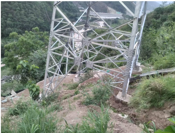
松老线改接 NS2 塔土地整治、植被恢复
