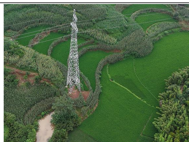
N3 塔基及其施工临时占地恢复情况
