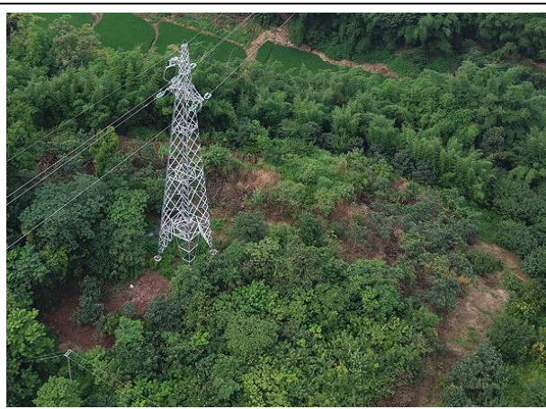
N14 塔基及其施工临时占地恢复情况
