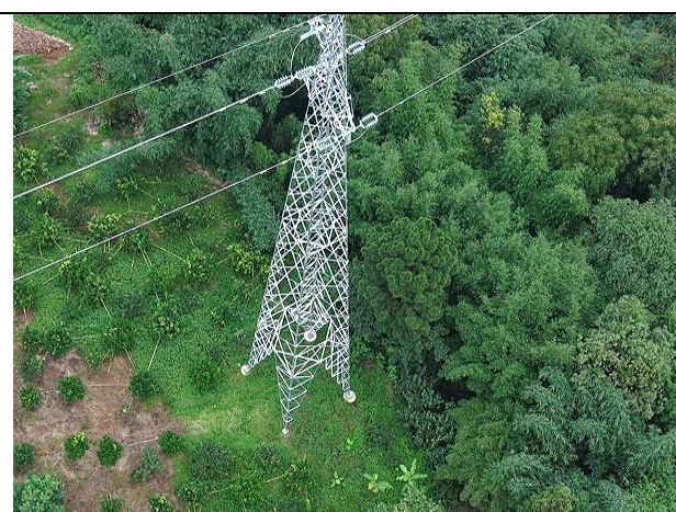
N15 塔基及其施工临时占地恢复情况
