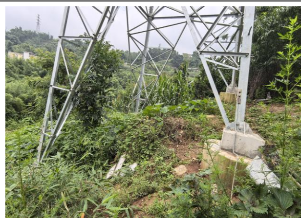
N1 塔基及其施工临时占地恢复情况
