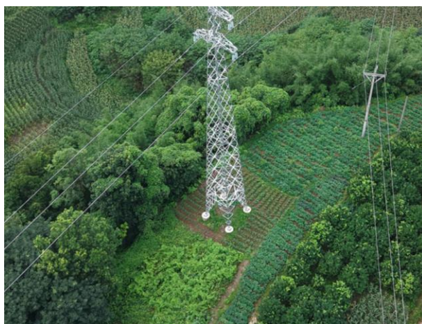
N18 塔基及其施工临时占地恢复情况
