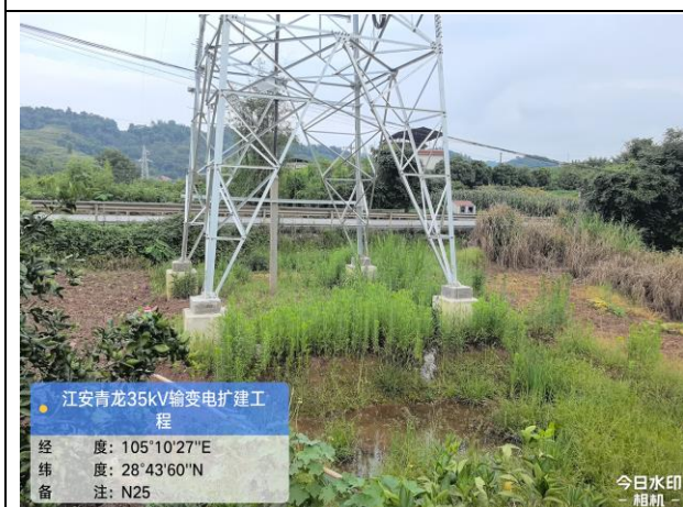
N25 塔基及其施工临时占地恢复情况
