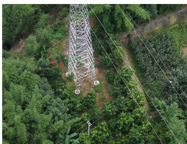
N6 塔基及其施工临时占地恢复情况
