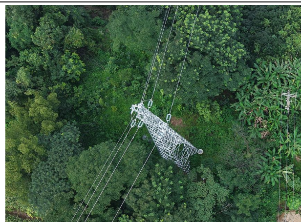
N13 塔基及其施工临时占地恢复情况
