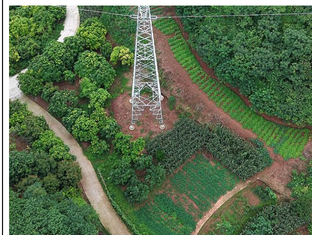
N23 塔基及其施工临时占地恢复情况
