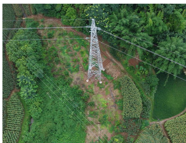
N24 塔基及其施工临时占地恢复情况
