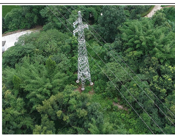
N16 塔基及其施工临时占地恢复情况
