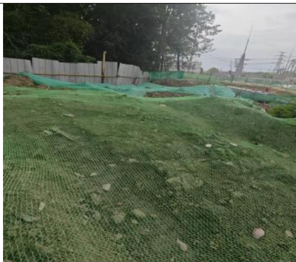
电缆区表土剥离
