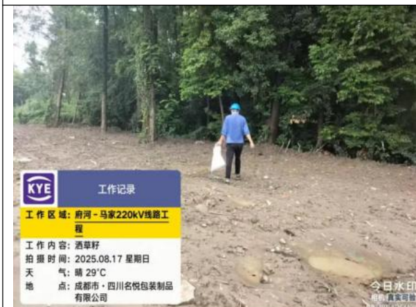
电缆区播撒草籽
