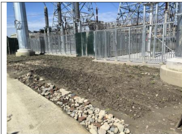
塔基及其施工区播撒草籽
