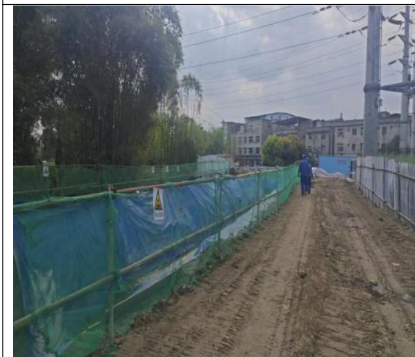
电缆区防雨布遮盖
