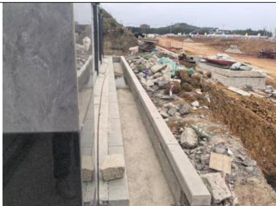
变电站区排水沟
