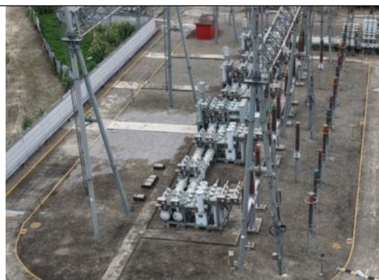
间隔扩建区碎石铺设
