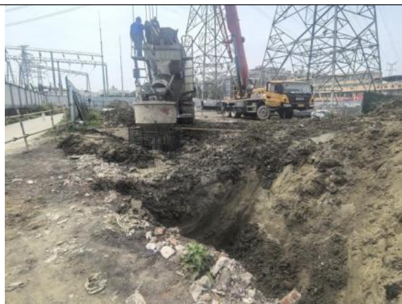
塔基及其施工区泥浆沉淀池
