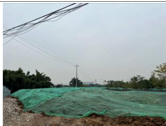
变电站区密目网遮盖
