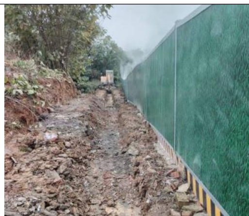
变电站区临时排水沟、临时沉淀池
