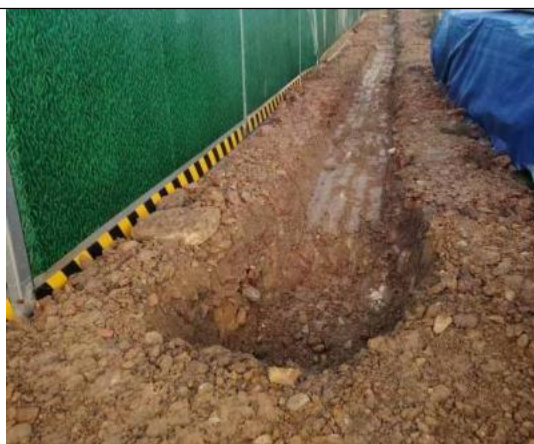
变电站区临时排水沟、临时沉淀池
