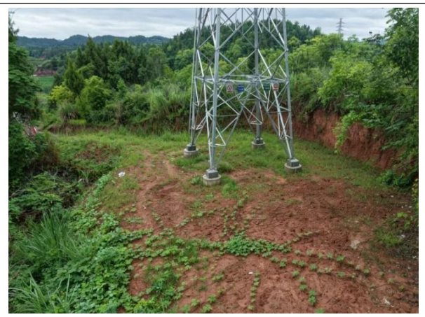
N10 塔基植被恢复情况
