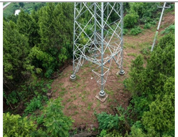
N6 塔基植被恢复情况
