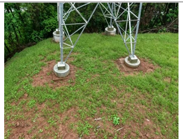
N8 塔基植被恢复情况
