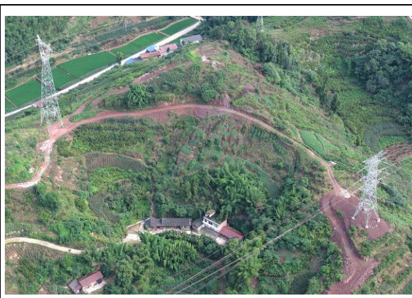
BN1 汽运道路未进行迹地恢复
