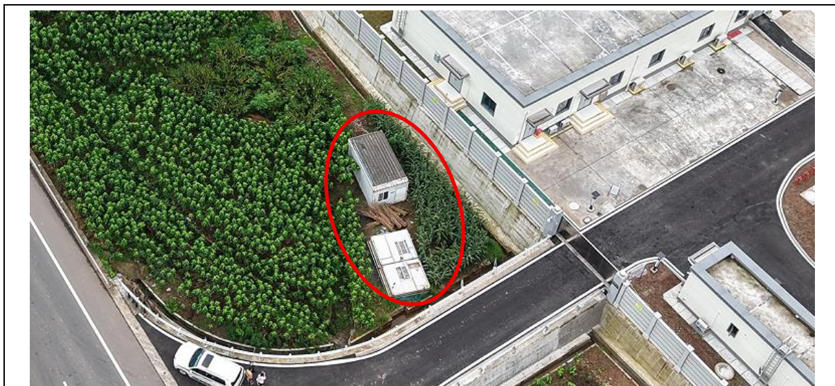
进站道路西侧建筑垃圾未清理
