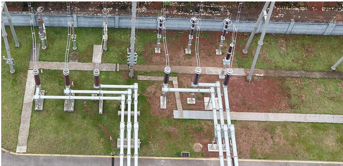
间隔扩建撒播草籽
