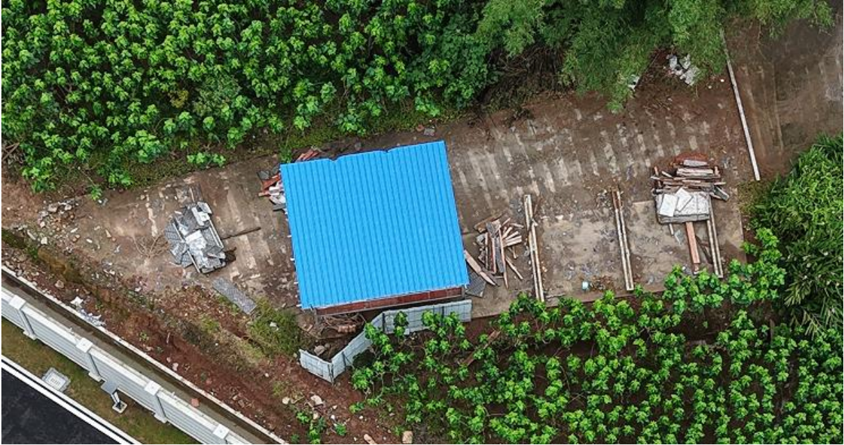
钢筋及木工加工场现状
