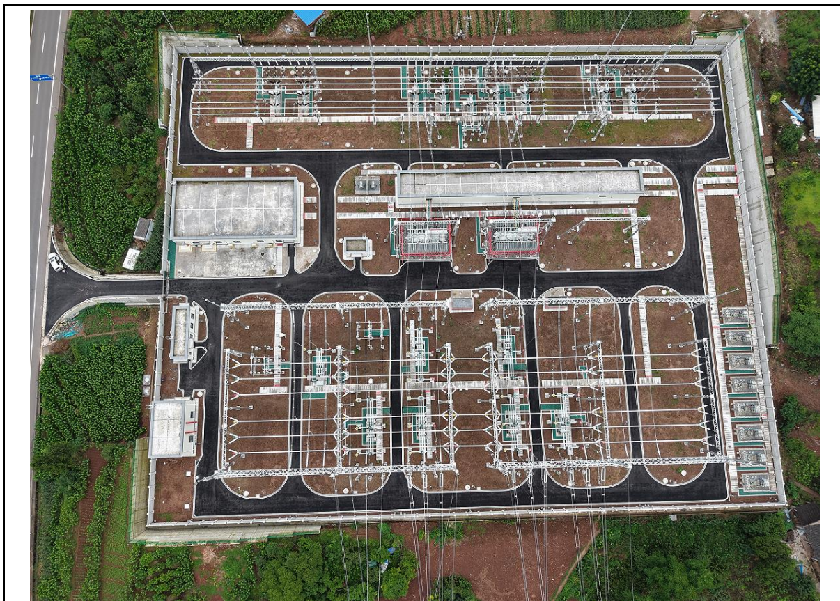
高县 220kV 变电站内绿化植被存活率低，植被恢复不到位
