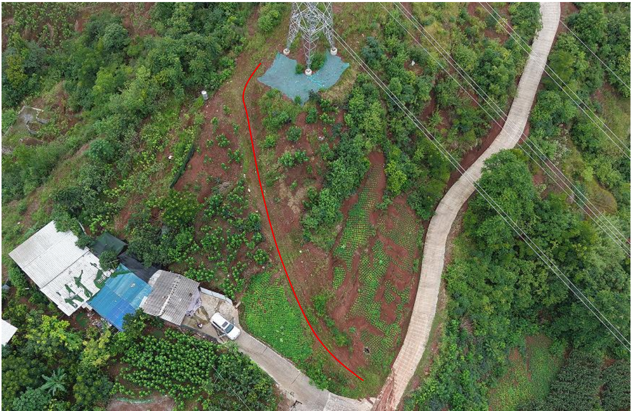
汽运道路植被恢复（撒播灌草籽）
