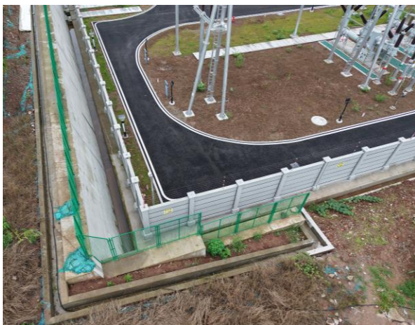
站外截、排水沟（北侧）
