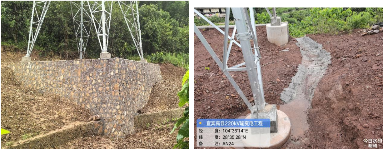
塔基及其施工临时占地浆砌石挡土墙、排水沟
