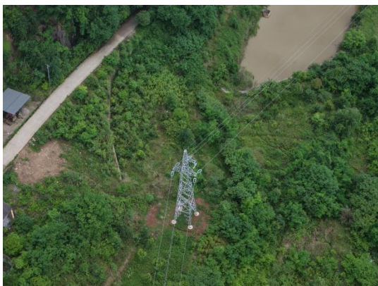
N18 塔基及施工场地
