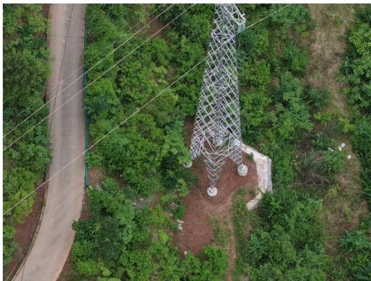
N16 塔基及施工场地
