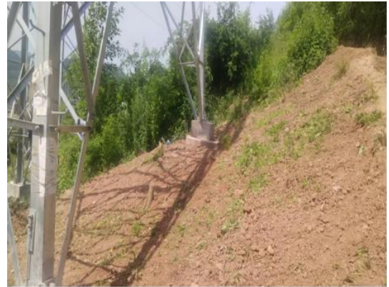
N9 塔基及施工场地
