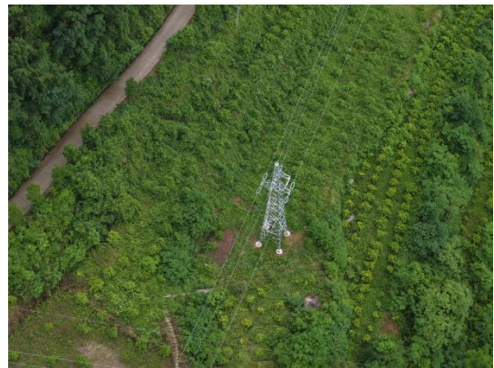
N17 塔基及施工场地
