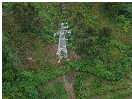
A12 塔基及施工场地
