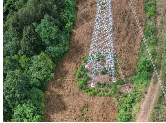
N15 塔基及施工场地
