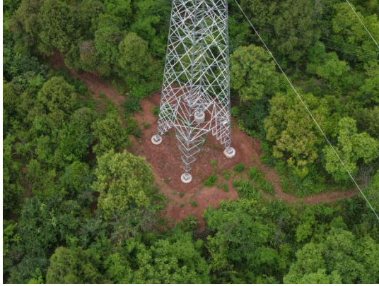
N22 塔基及施工场地
