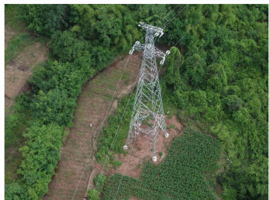
N21 塔基及施工场地
