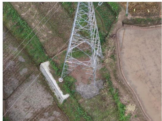
N13 塔基及施工场地
