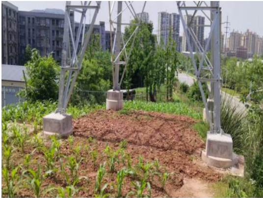
N8 塔基及施工场地
