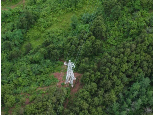
A13 塔基及施工场地
