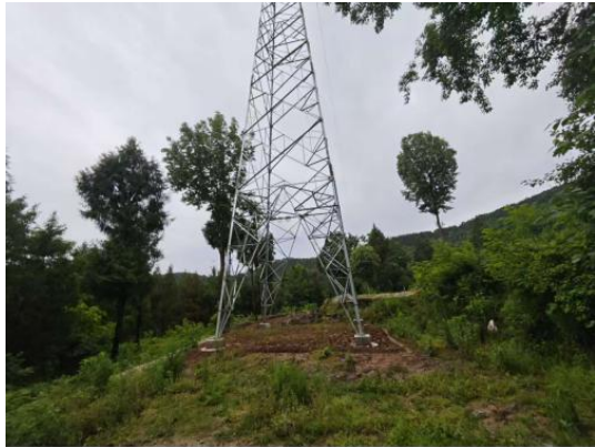
N24 塔基及施工场地
