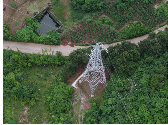
A14 塔基及施工场地
