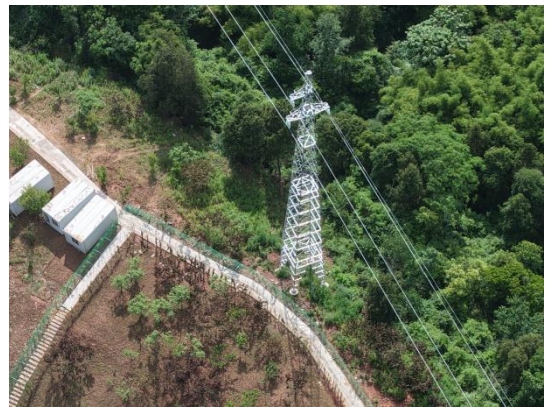
N11 塔基及施工场地
