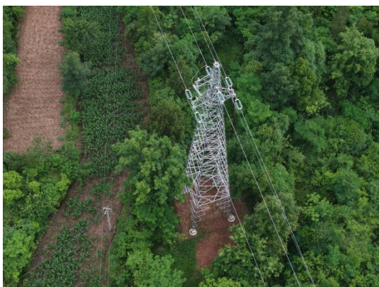
N20 塔基及施工场地
