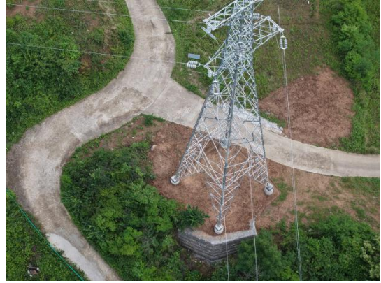
N23 塔基及施工场地
