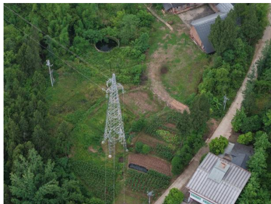
A8 塔基及施工场地
