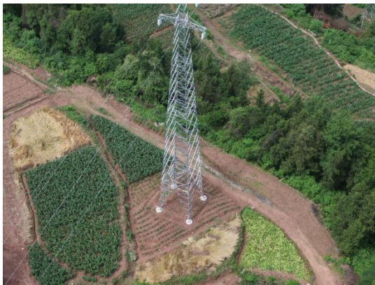
N26 塔基及施工场地
