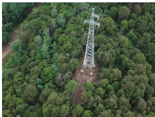
A10 塔基及施工场地
