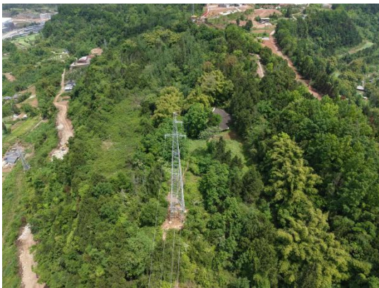
N10 塔基及施工场地
