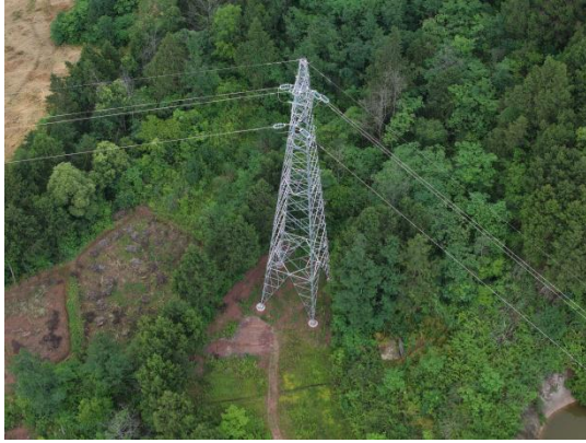
N14 塔基及施工场地
