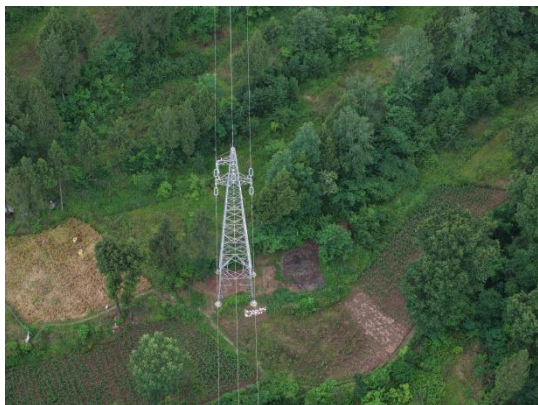
A7 塔基及施工场地
