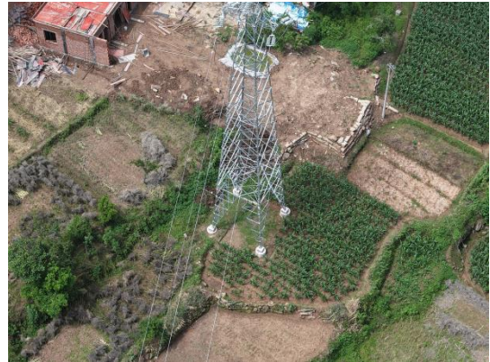
N25 塔基及施工场地
