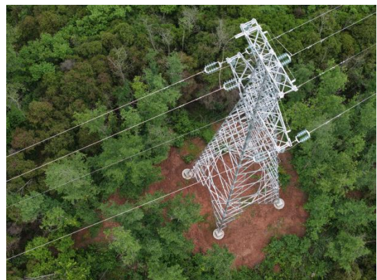
N19 塔基及施工场地
