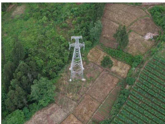
A9 塔基及施工场地
