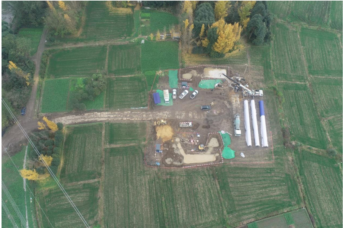
邛崃-丹景 N244 施工道路
