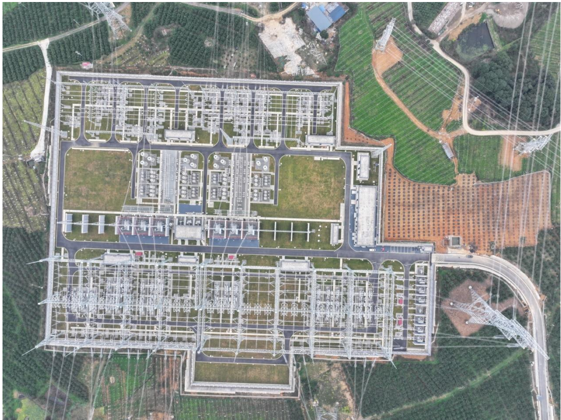
变电站建成后航拍图
