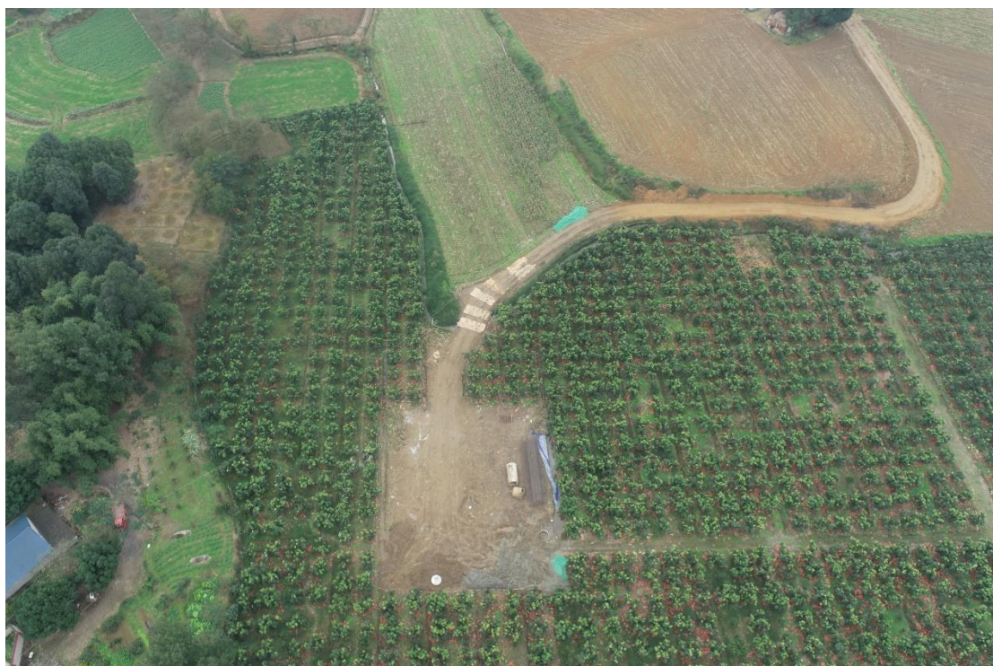
邛崃-丹景 N16 施工道路
