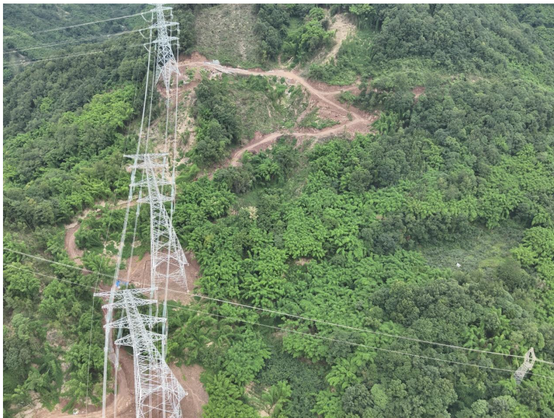
雅蜀 \pi 接 NR1、NR2、NR3 施工道路
