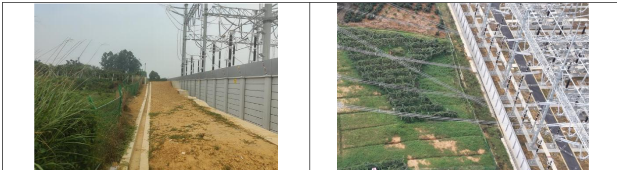
变电站站区围墙外整改前后对比照片
