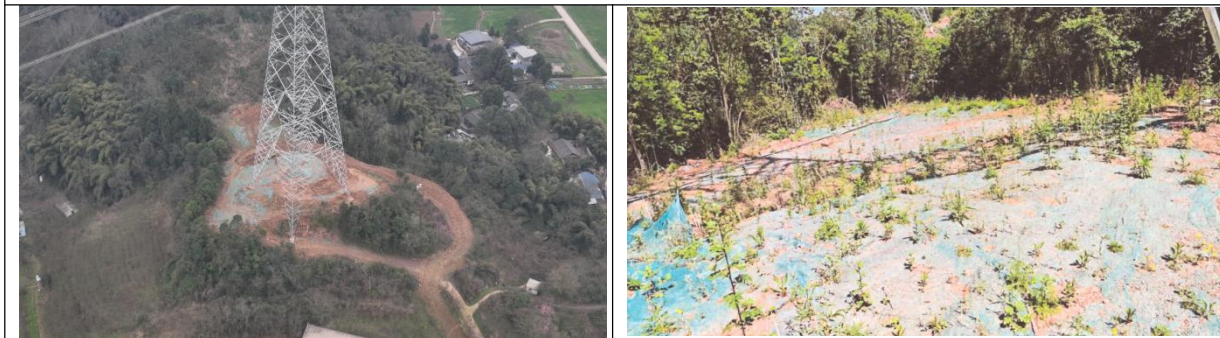
邛崃~丹景 500kV 线路工程 N80 整改前后对比照片
