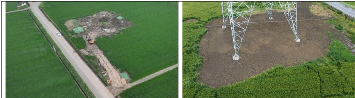
邛崃~丹景 500kV 线路工程 N35 塔基整改前后对比照片
