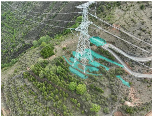
N9 施工便道
