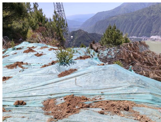
N20 施工便道
