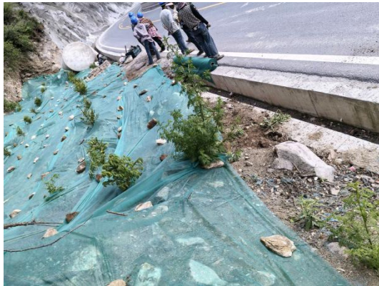
N81 索道上料场（栽植乔木和撒播草籽）
