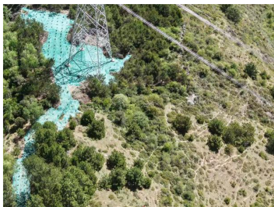
N19 施工便道
