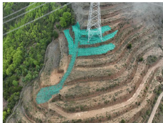
N8 施工便道
