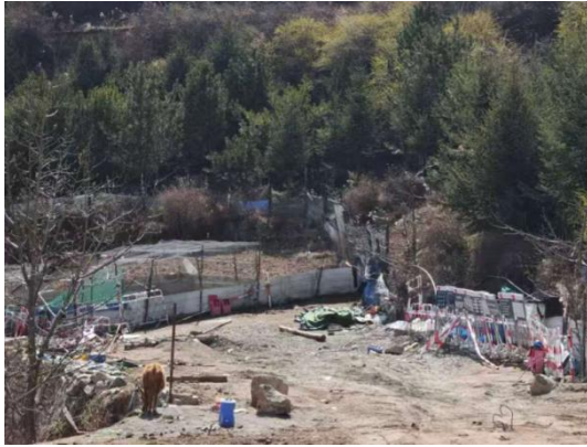
N67-N71 索道上料场（拆除中）
