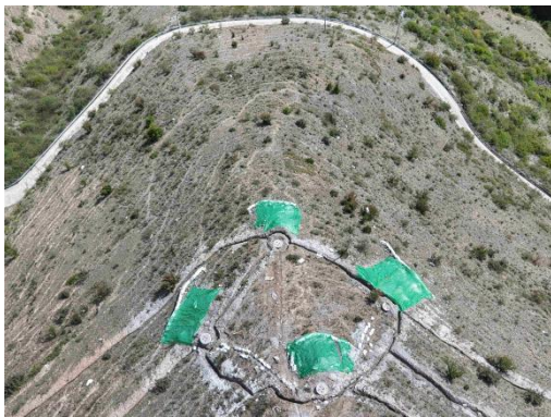
N7 塔基临时堆土实施临时拦挡及苫盖
