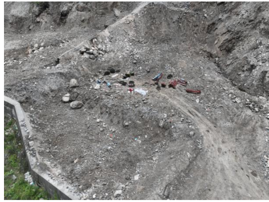
N98-N101 索道上料场（拆除中）
