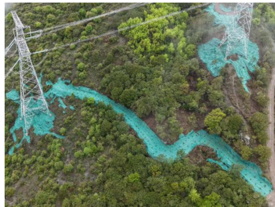
N14 施工便道
