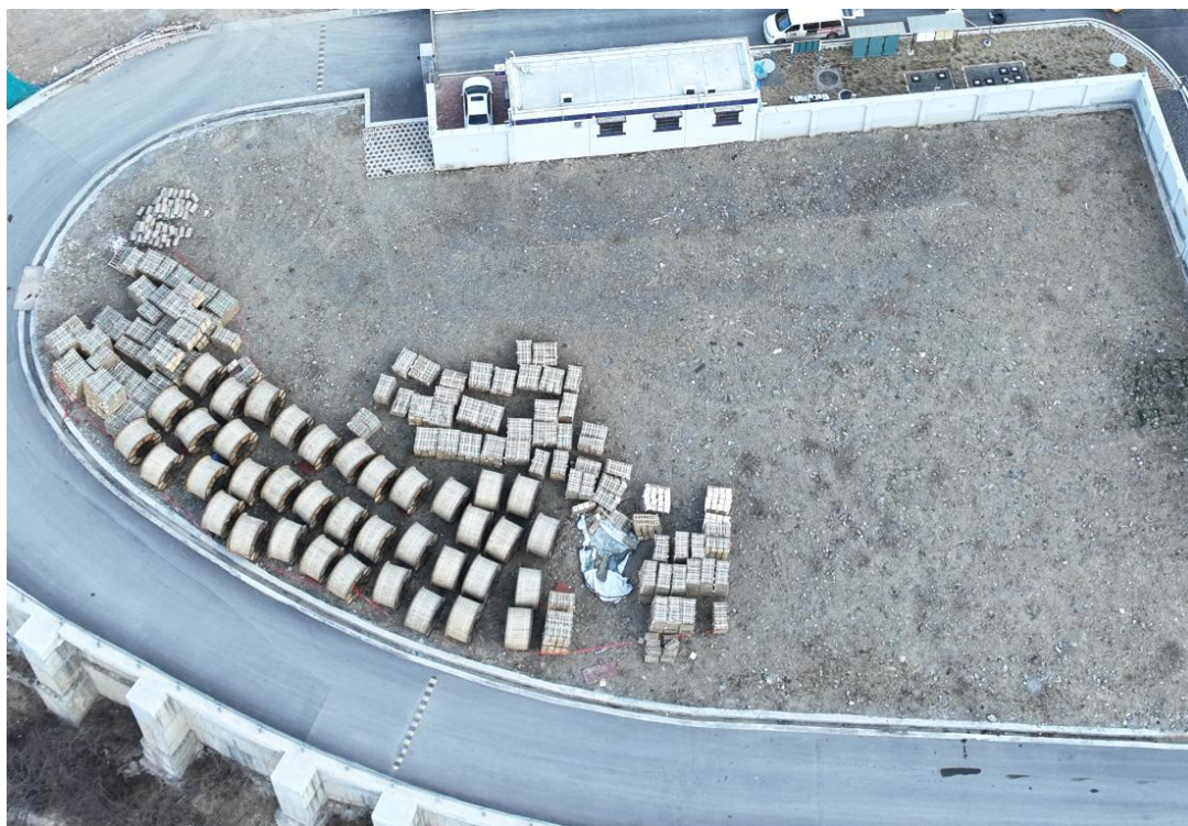
马尔康 500kV 变电站间隔扩建工程余土平摊于终端塔
