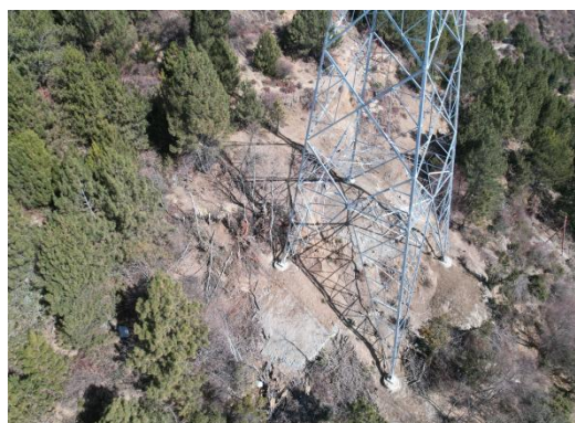
塔基余土就地平摊于塔基区内，部分塔基采用挡土墙进行挡护
