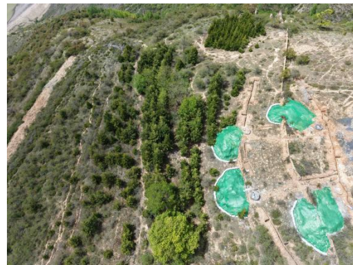
N9 塔基临时堆土实施临时拦挡及苫盖
