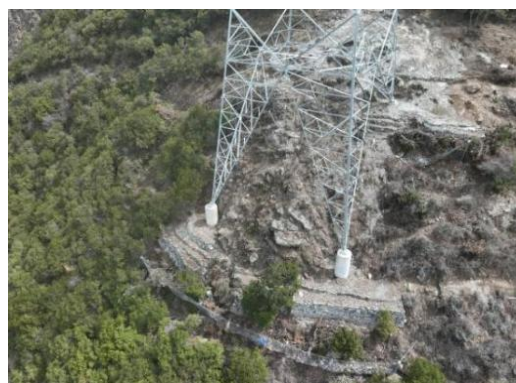
塔基余土就地平摊于塔基区内，部分塔基采用挡土墙进行挡护
