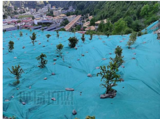
N112 索道上料场（栽植乔木和撒播草籽）
