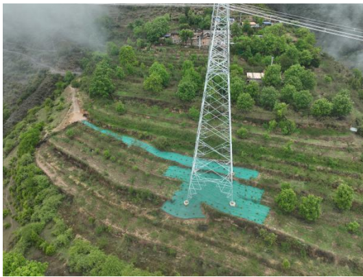
N6 施工便道
