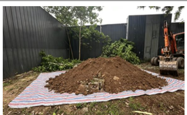
防雨布铺垫施工过程照片
