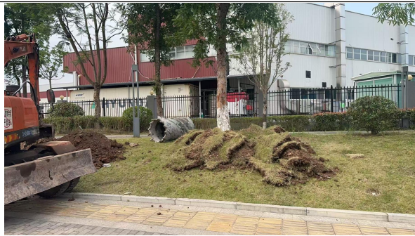
草皮剥离施工过程照片
