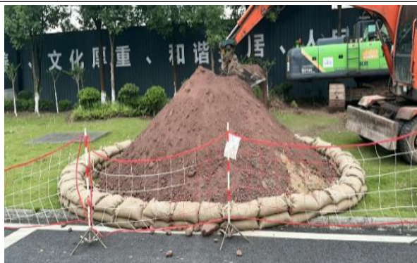
土袋拦挡施工过程照片
