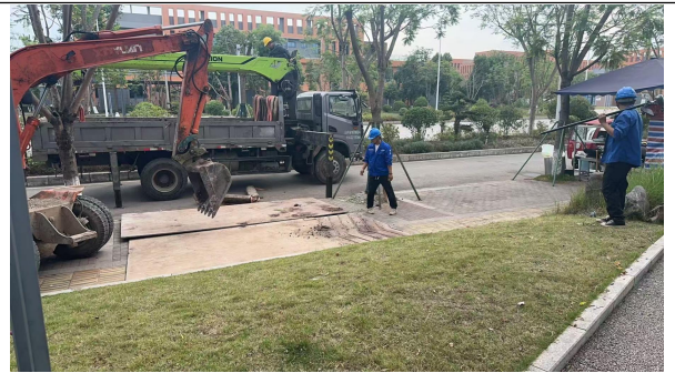
钢板铺垫施工过程照片
