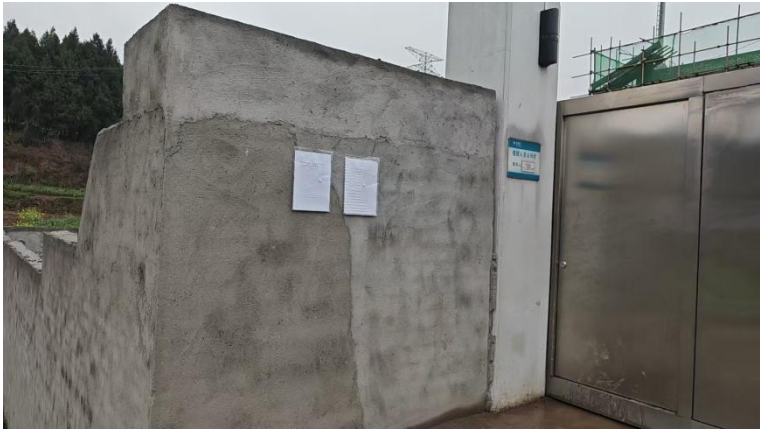
项目现场公示情况
