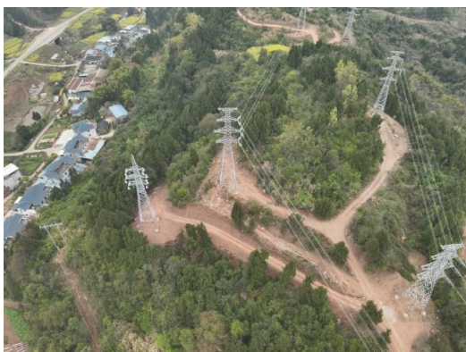
青龙坡 N1-9 施工道路
