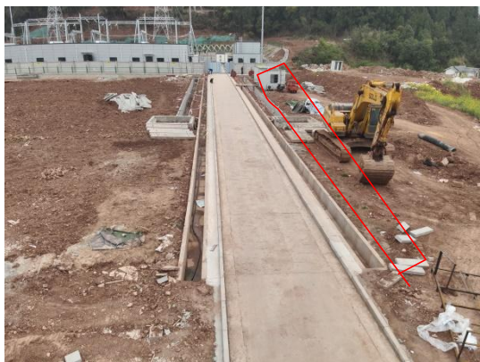
图 4.2-1 变电站进站道路边坡绿化效果欠佳，裸露地表缺乏有效的临时遮盖
