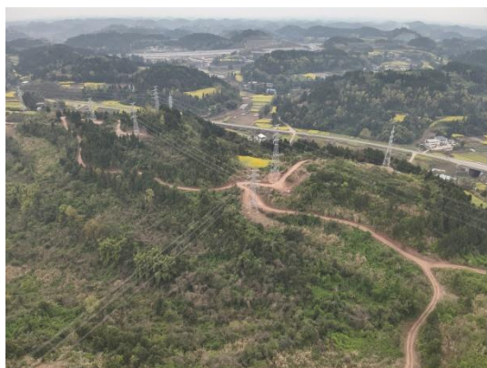
石门 N29-30 施工道路
