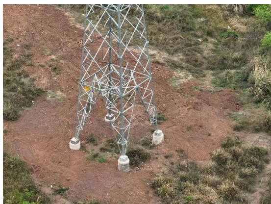
青龙坡 N15 塔基施工场地现状
