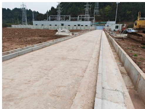
进站道路排水沟
