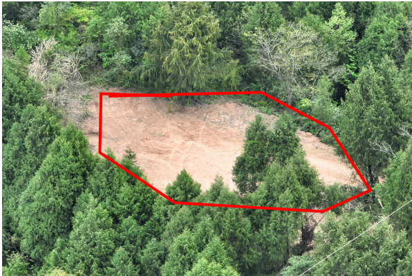
图 3.2-2 石门-太吉 N47 号塔处牵张场
