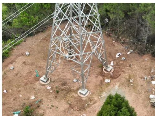
石门 N6 塔基施工场地现状
