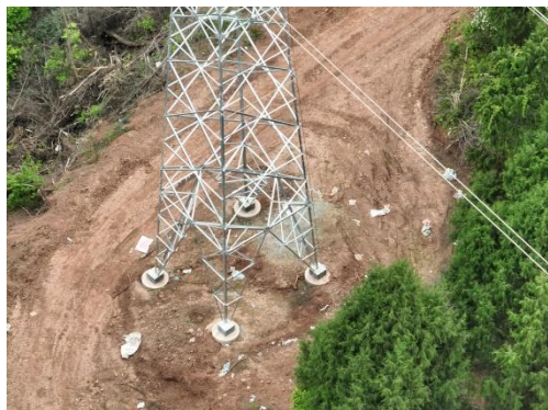
石门 N21 塔基施工场地现状
