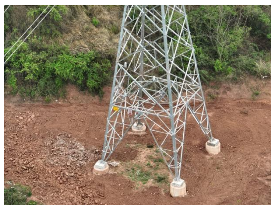
青龙坡 N16 塔基施工场地现状
