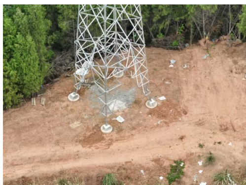
石门 N45 基施工场地现状
