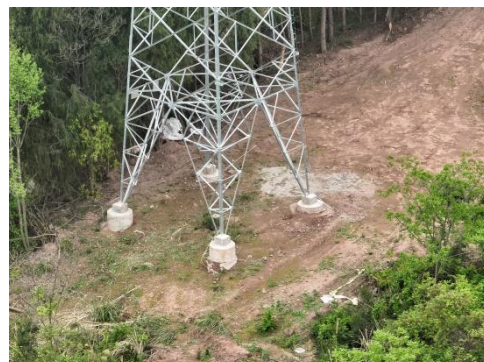
石门 N23 塔基施工场地平整
