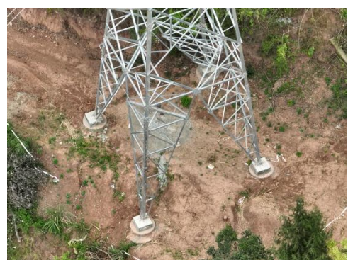
青龙坡 N2 塔现状
