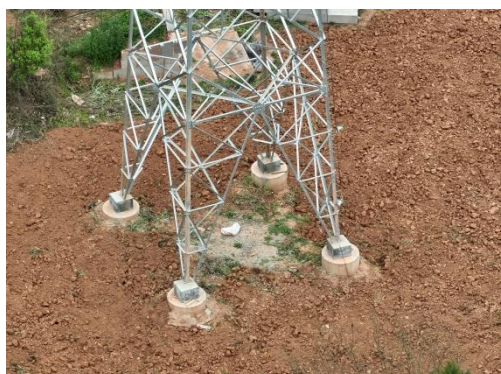
石门 N15 塔基施工场地现状
