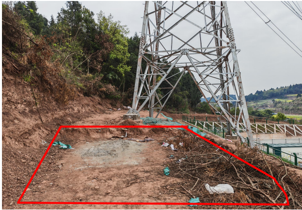
图 3.2-3 青龙坡-太吉 N1 号塔处牵张场
