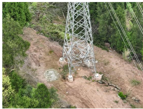
青龙坡 N11 塔基施工场地现状
