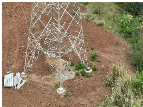
石门 N17 塔基施工场地现状
