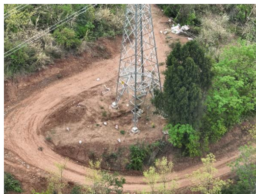
青龙坡 N13 塔基施工场地现状
