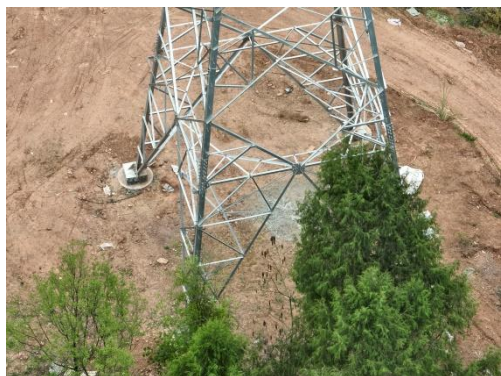
石门 N8 塔基施工场地现状
