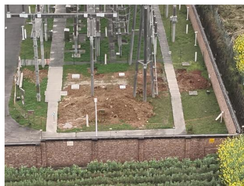
石门变间隔扩建
