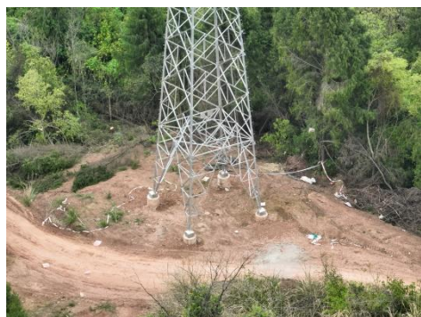
青龙坡 N6 塔基施工场地现状
