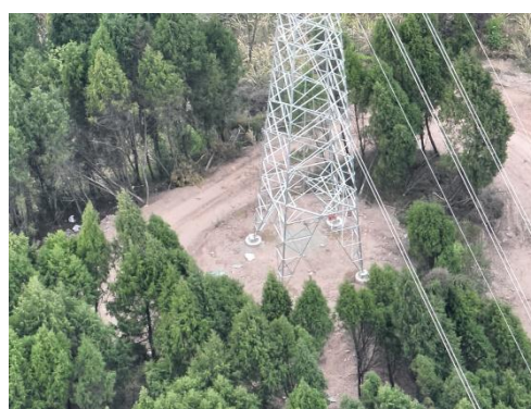
石门 N35 塔基施工场地现状
