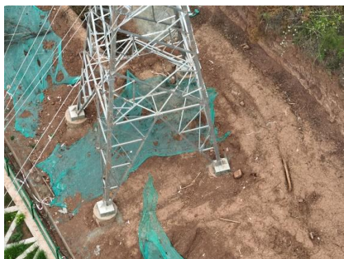
石门 N1 塔基施工场地现状
