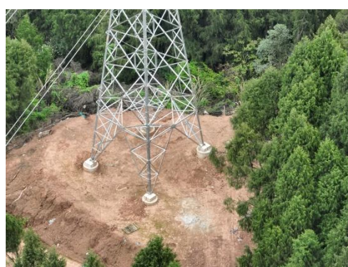
石门 N46 塔基施工场地现状
