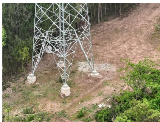
青龙坡 N25 塔基施工场地现状
