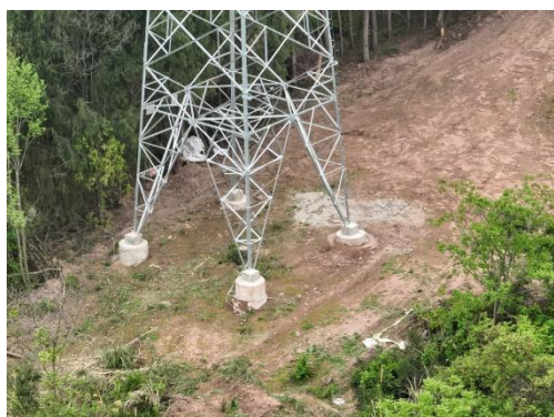
石门 N23 塔基施工场地现状
