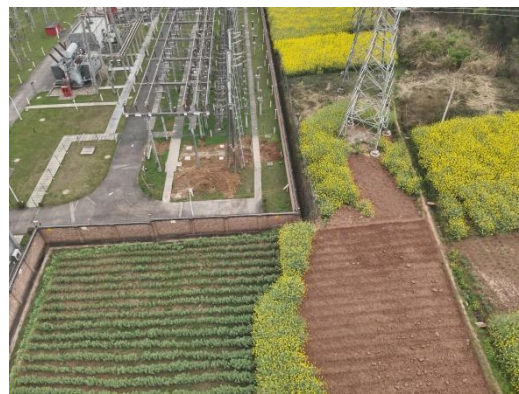
石门 N58 号塔牵张场
