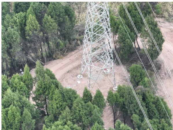
图 4.2-4 石门-太吉 N35 号架线完毕,施工场地未恢复植被
