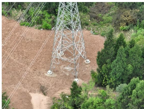
石门 N47 基施工场地现状
