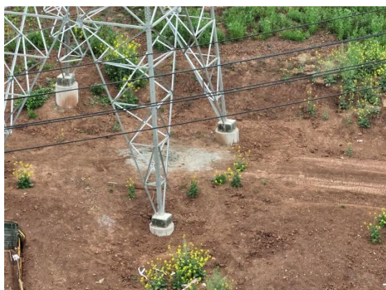
青龙坡 N39 塔基施工场地现状
