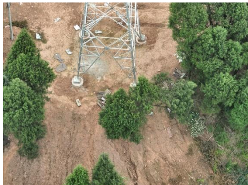
石门 N57 基施工场地现状
