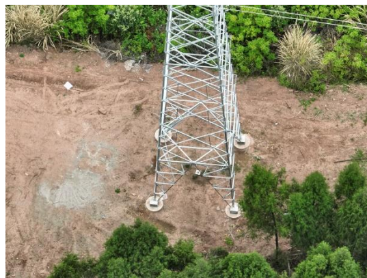
青龙坡 N27 塔基施工场地现状
