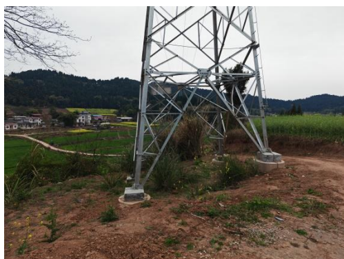
石门 N37+1 塔基施工场地现状
