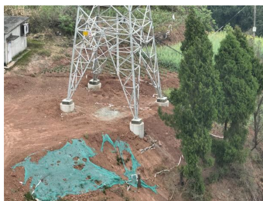
青龙坡 N38 塔基施工场地现状
