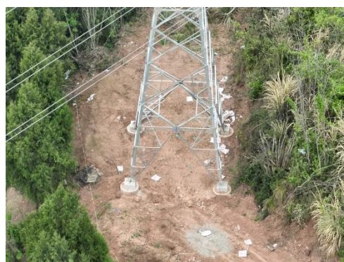
石门 N5 塔基施工场地现状
