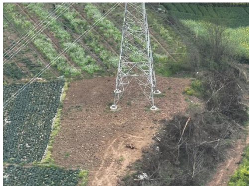
石门 N55 基施工场地现状
