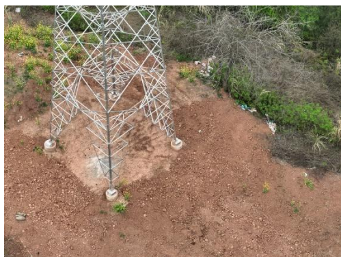
石门 N43 基施工场地现状
