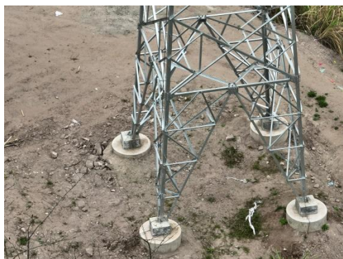
石门 N41 基施工场地现状
