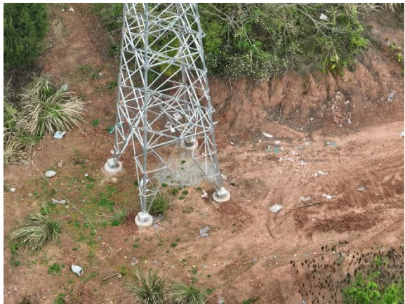
石门 N11 塔基施工场地土地整治
