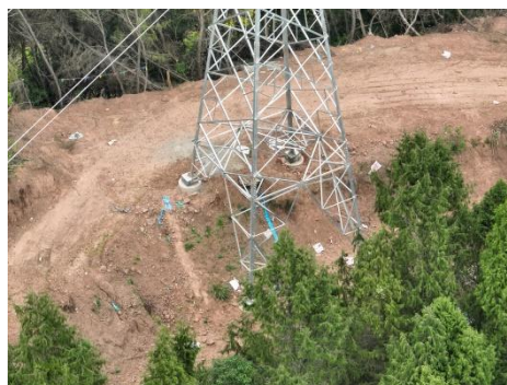
石门 N18 塔基施工场地现状
