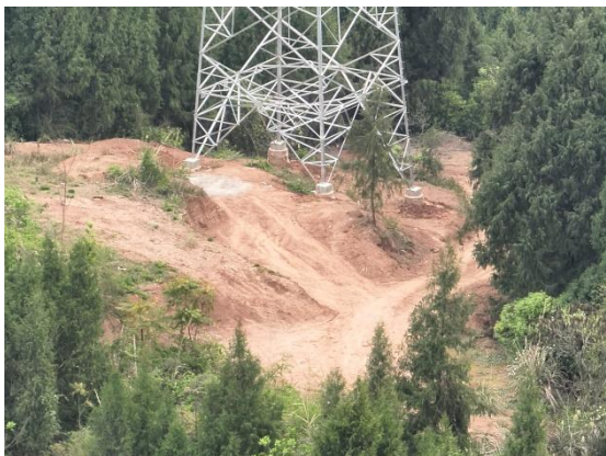
青龙坡 N19 塔基施工场地现状
