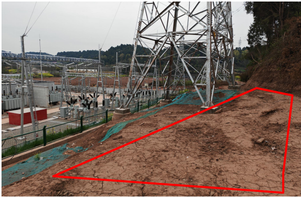
图 3.2-1 石门-太吉 N1 号塔处牵张场
