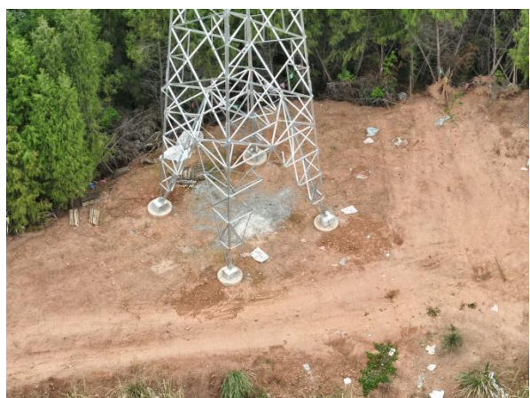
图 4.2-6 石门 N45 号架线完毕,施工场地未恢复植被
