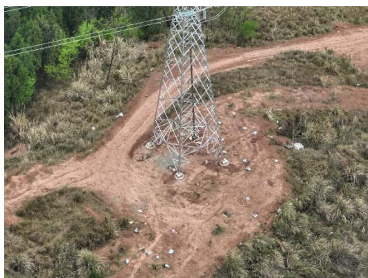
石门 N37 塔基施工场地平整
