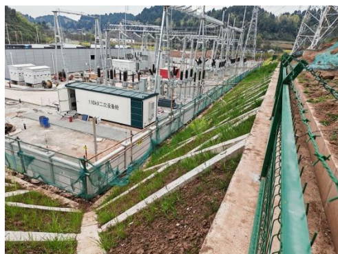
变电站北侧截水沟及边坡
