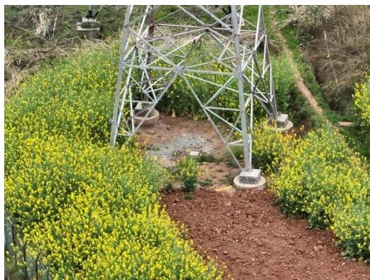
石门 N58 塔基施工场地平整
