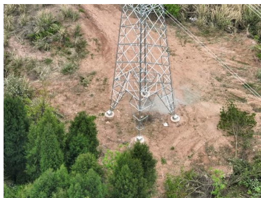
图 4.1-3 青龙坡-太吉 N26 组塔完毕，施工场地未恢 图4.1-4本季度青龙坡-太吉N26号塔现状
