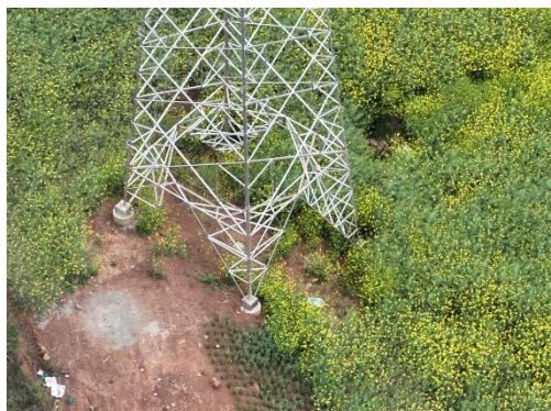
石门 N53 基施工场地现状
