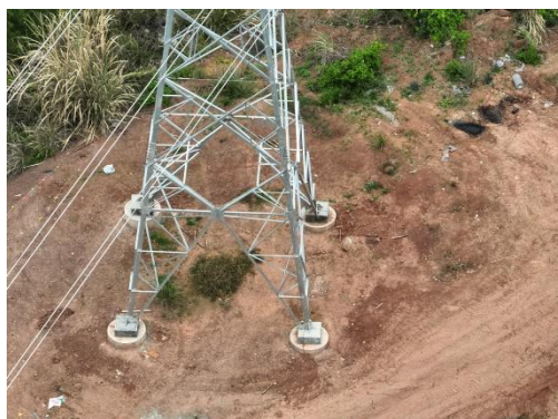
石门 N4 塔基施工场地现状
