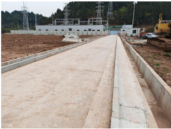
进站道路排水沟
