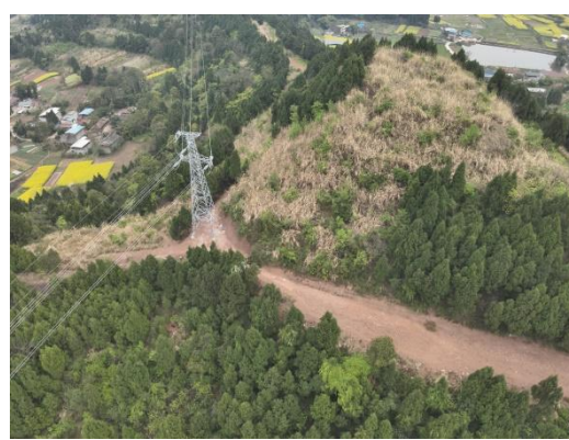
石门 N39 号塔牵张场
