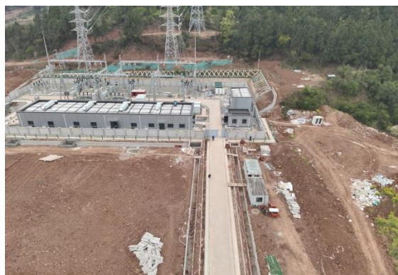
图 4.2-1 变电站进站道路边坡绿化效果欠佳，裸露地表缺乏有效的临时遮盖
