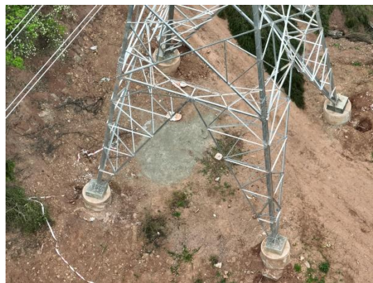
青龙坡 N3 塔基施工场地现状
