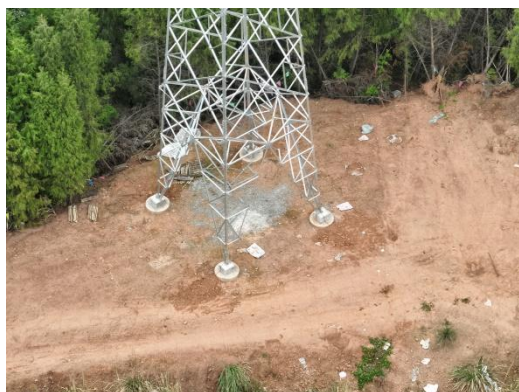
石门 N45 塔基施工场地平整
