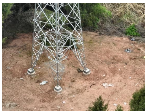
石门 N52 塔基施工场地现状
