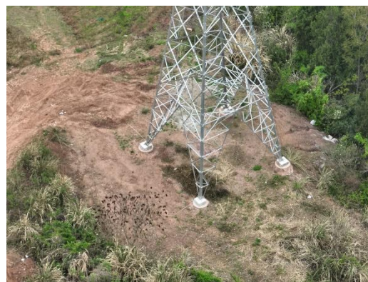
青龙坡 N9 塔基施工场地现状
