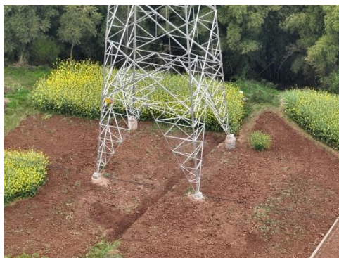
青龙坡 N14 塔现状
