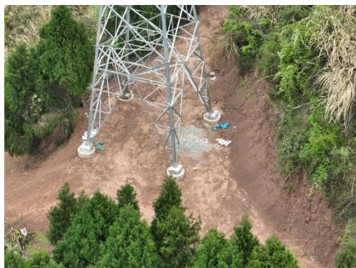
石门 N39 塔基施工场地现状
