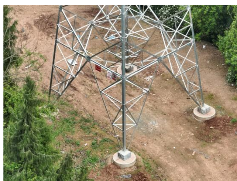
石门 N13 塔基施工场地现状
