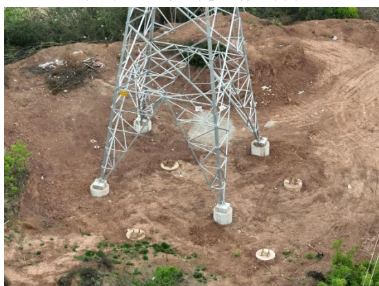
青龙坡 N37 塔基施工场地现状
