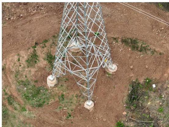
青龙坡 N17 塔基施工场地现状
