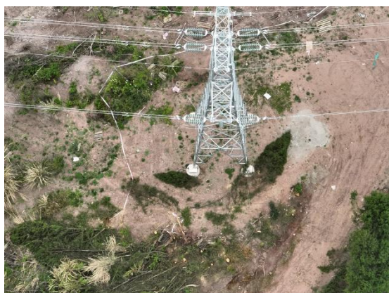
青龙坡 N28 塔基施工场地现状
