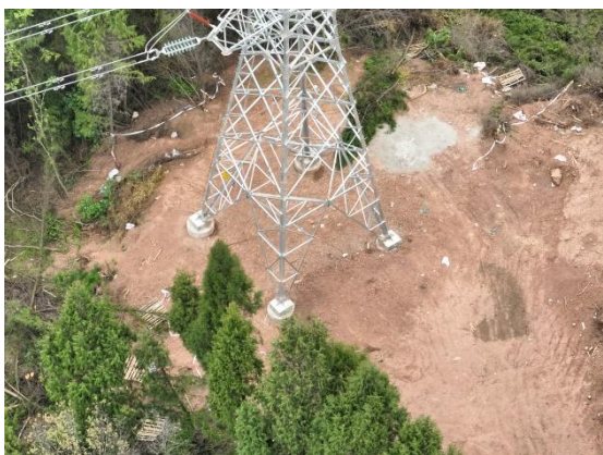
青龙坡 N24 塔基施工场地现状
