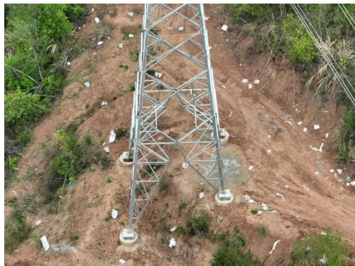
青龙坡 N10 塔基施工场地现状
