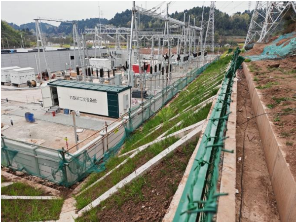
站区护坡及截排水沟
