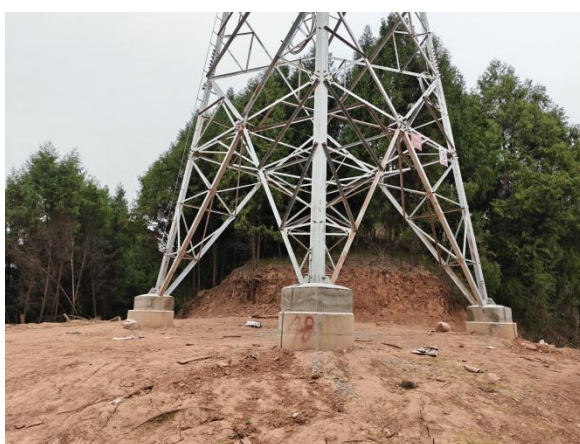
图 4.2-7 石门 N48 号架线完毕,施工场地未恢复植被
