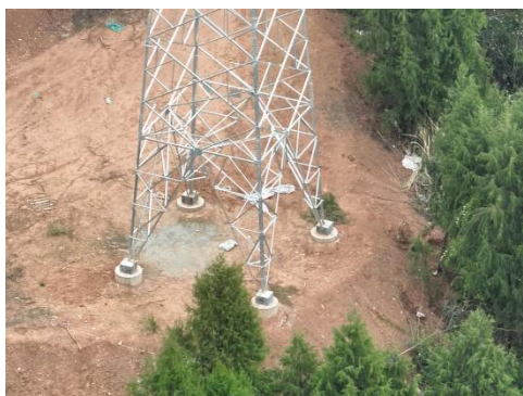
石门 N26 塔基施工场地现状
