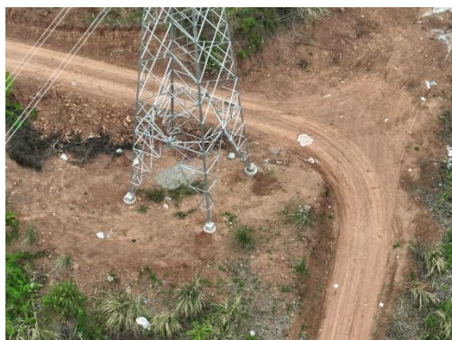
石门 N10 塔基施工场地现状
