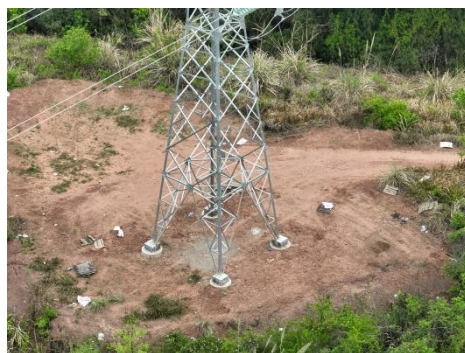
石门 N20 塔基施工场地现状
