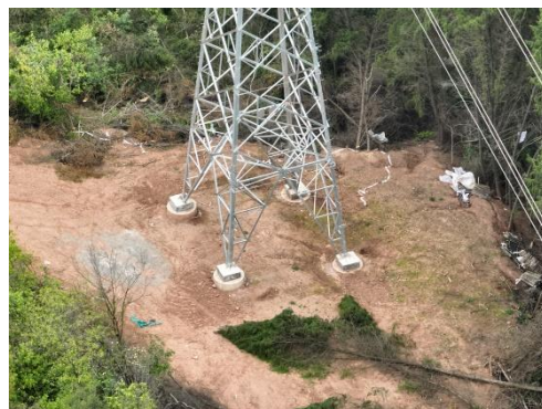
青龙坡 N7 塔基施工场地现状
