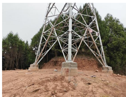
石门 N48 塔基施工场地现状
