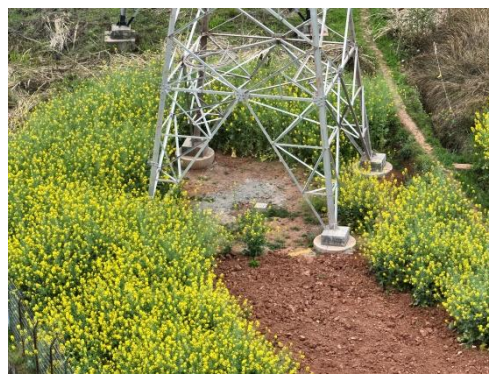
石门 N58 塔基施工场地现状
