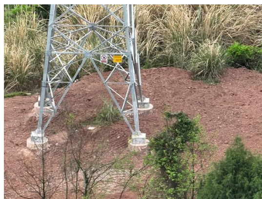
青龙坡 N18 塔基施工场地现状
