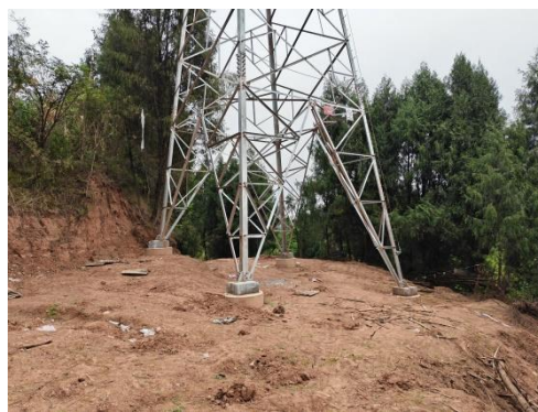
石门 N50 塔基施工场地现状
