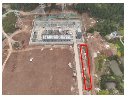
进站道路边坡（被其他项目扰动）
