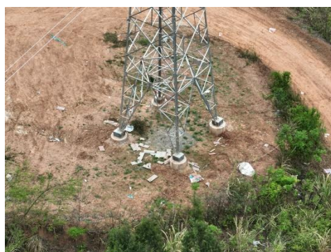
石门 N7 塔基施工场地现状
