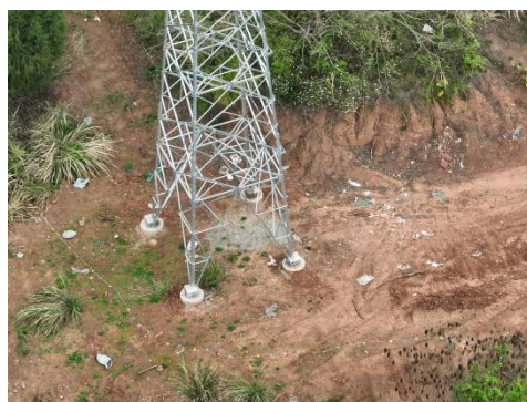
石门 N11 塔基施工场地现状
