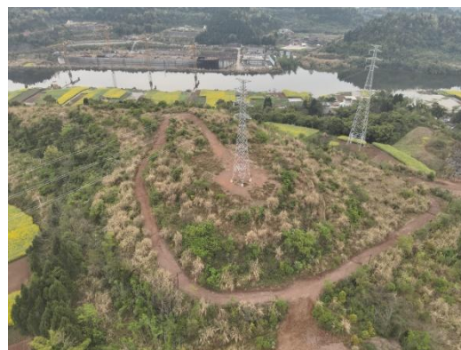
青龙坡 N14-16 耕地施工道路
