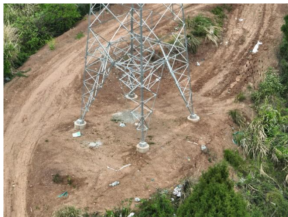
图 4.2-5 石门-太吉 N40 号架线完毕,施工场地未恢复植被
