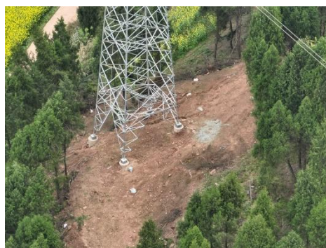
石门 N22 塔基施工场地现状
