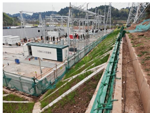
站区边坡及截排水沟
