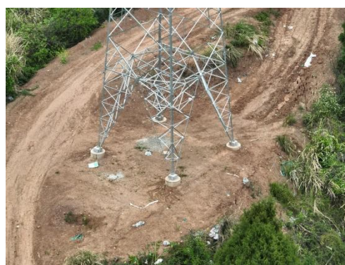
石门 N40 塔基施工场地现状
