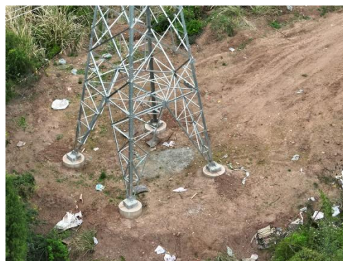
石门 N3 塔基施工场地平整
