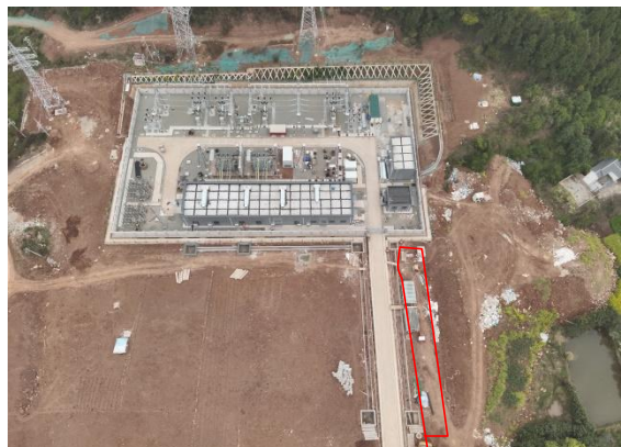
图4.1-2 本季度进站道路边坡现状
