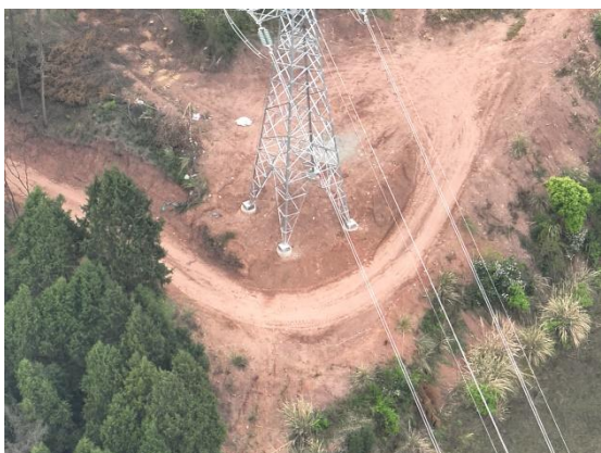
青龙坡 N22 塔基施工场地现状
