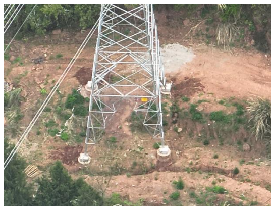
青龙坡 N21 塔基施工场地现状
