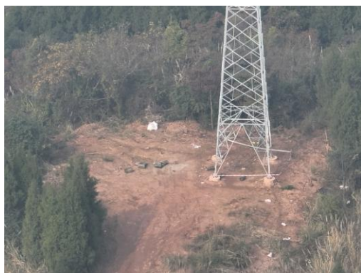
图 4.1-3 青龙坡-太吉 N26 组塔完毕，施工场地未恢 图4.1-4本季度青龙坡-太吉N26号塔现状
