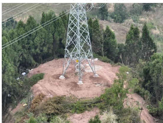
青龙坡 N35 塔基施工场地现状
