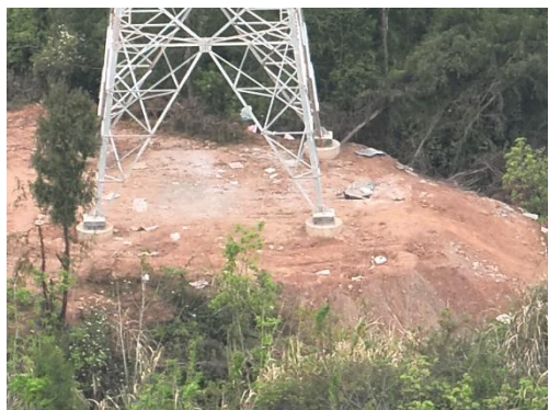
石门 N12 塔基施工场地现状
