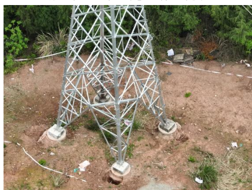
青龙坡 N4 塔基施工场地现状
