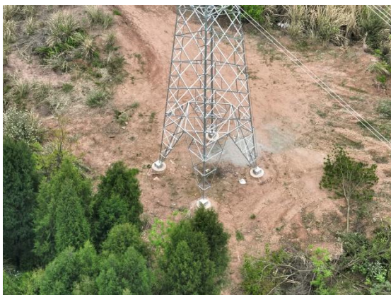
青龙坡 N26 塔基施工场地现状
