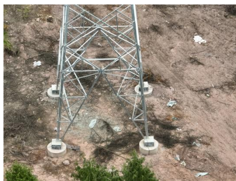
石门 N27 塔基施工场地现状
