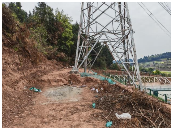
青龙坡 N1 塔基施工场地现状
