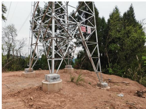
石门 N49 基施工场地现状
