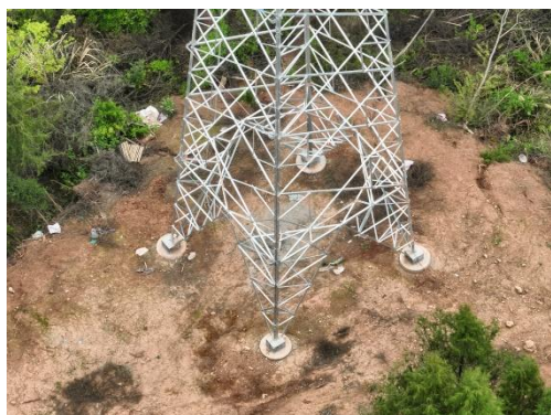
石门 N28 塔基施工场地现状
