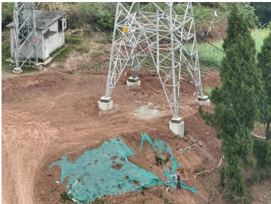
青龙坡 N38 塔施工道路表土遮盖
