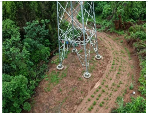
N4 塔基植被恢复情况
