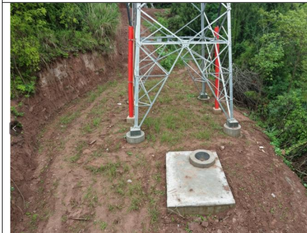
N10 塔基植被恢复情况
