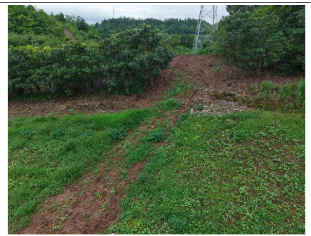
N7 塔基机械化施工道路恢复情况
