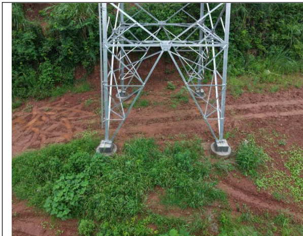
N3 塔基植被恢复情况
