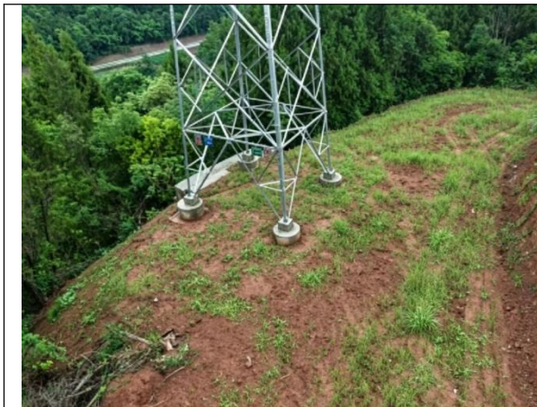
N9 塔基植被恢复情况
