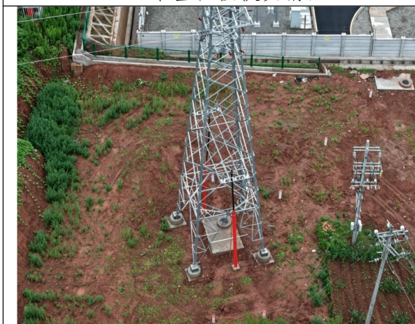
电缆沟植被恢复情况（红线为电缆沟）
