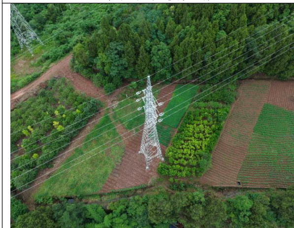
N7 塔基复耕情况
