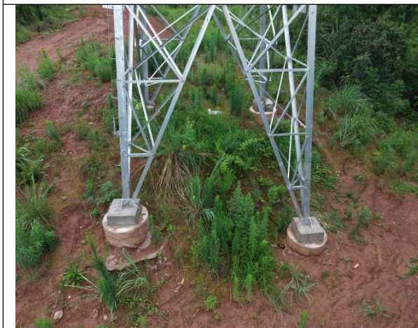
N5 塔基植被恢复情况
