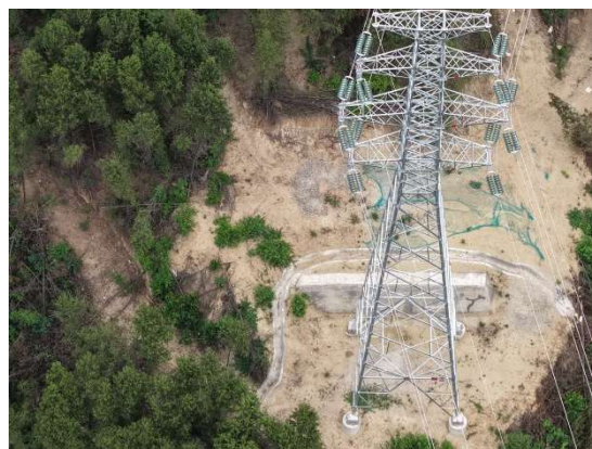
N14 号塔现状
