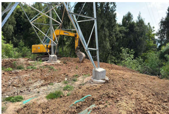
N36 号塔现状
