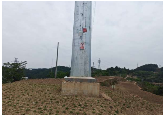
N2 号塔现状（耕地）
