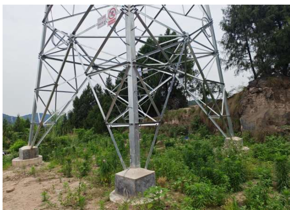
N9 号塔现状
