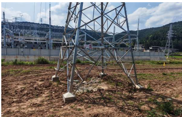
N48 号塔现状
