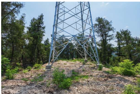
N39 号塔现状
