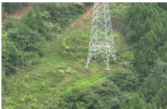
N43 号塔现状
