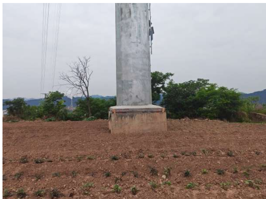
N1 号塔现状（耕地）
