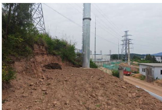
N3 号塔现状（耕地）
