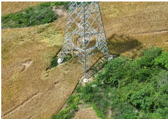
N31 号塔现状
