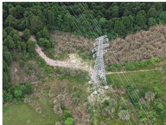
N12 号塔现状
