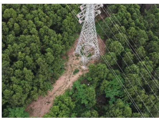
N10 号塔现状
