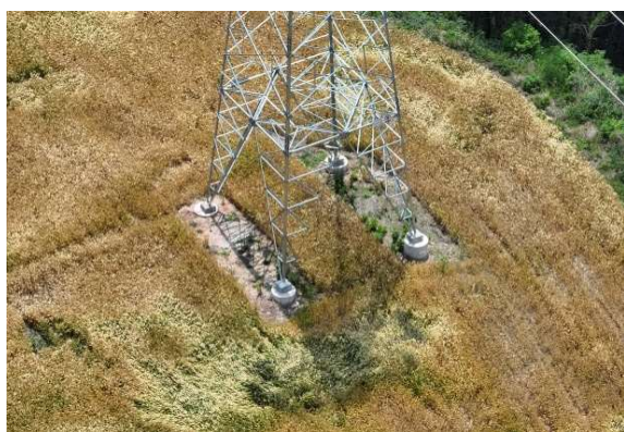
N29 号塔现状
