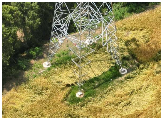
N32 号塔现状
