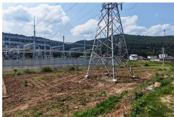
N49 号塔现状
