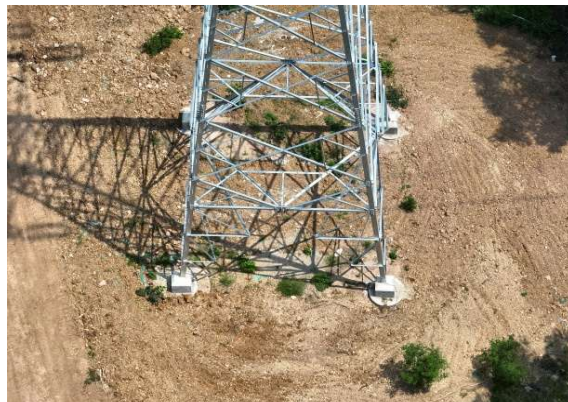
N40 号塔现状
