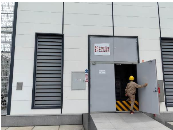
2 号主变室安装隔声门及消音百叶窗
