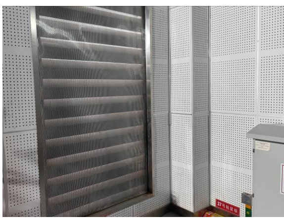
2#主变室内部防火穿孔吸音板
