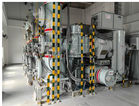
凉风顶 110kV 变电站 GIS 设备
