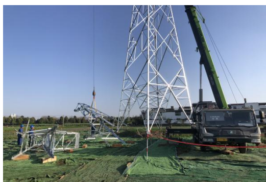
NA48 塔基临时苫盖
