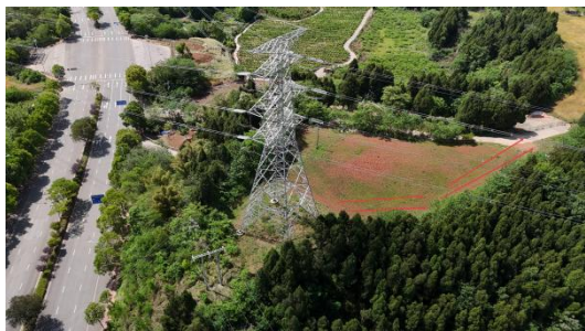
7、德阳南—寿丰双回、德阳南—云绣双回220kV线路N32塔位施工道路现状
