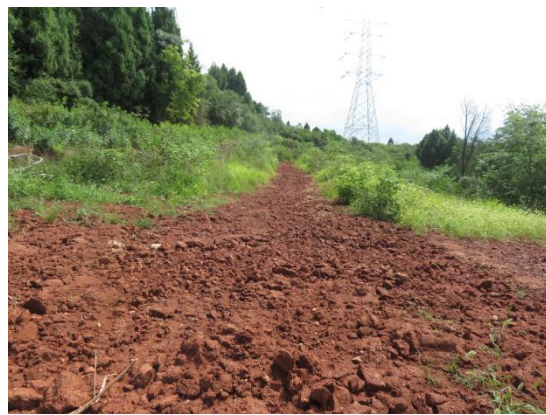
NB14施工道路（2024.9）
