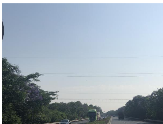
古城—双福220kV线路NB47-NB48封网跨越 旌江干道
