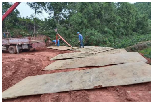
N11 道路铺设钢板
