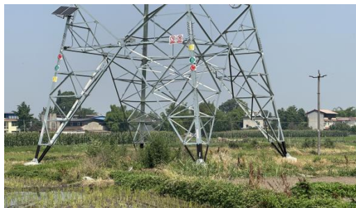
NB50塔位表土、土石方回覆（2025.6）
