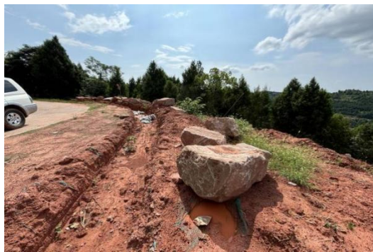
N4 塔位临时排水沟
