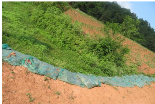
NA5 塔基施工道路土袋拦挡
