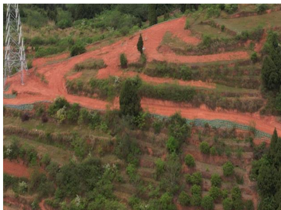
NA14施工道路 (2024.4)
