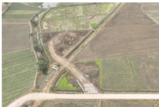
绵华一线#48G 施工道路铺设钢板
