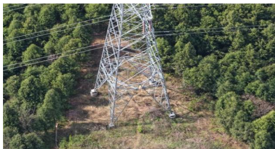
7、云绣—南华II回、绵州—南华II回 \pi 入德阳南220kV线路BN2塔位现状
