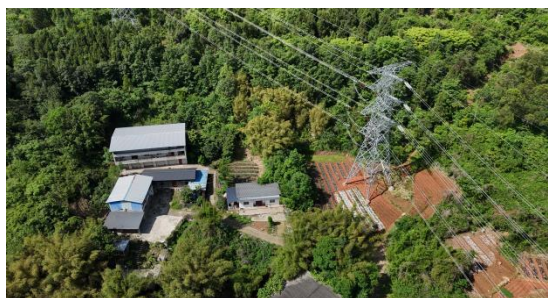
9、德阳南—寿丰双回、德阳南—云绣双回220kV线路N41塔位现状
