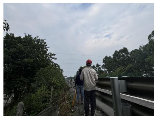
古城—双福220kV线路NA64-NA65封网跨越 G5高速
