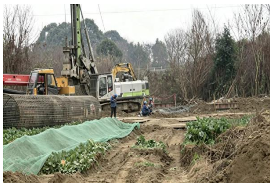
NA65 塔基施工道路铺设钢板
