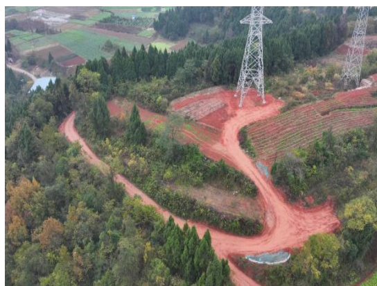
M16(N37)施工道路（2024.12）
