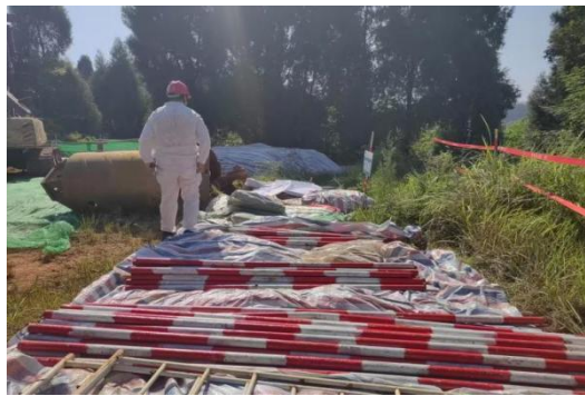
M8(N29)塔基临时铺垫
