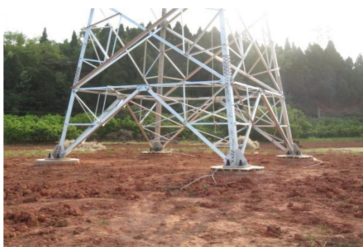
NB23 塔基土地整治
