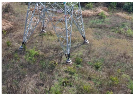
NA3塔基区表土回覆（2026.3）
