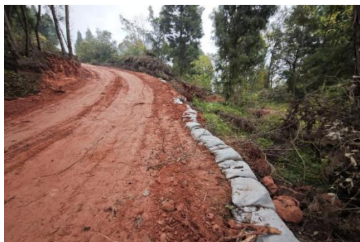
M17(N38)施工道路土袋拦挡
