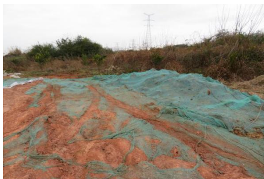
NA3 塔基表土剥离
