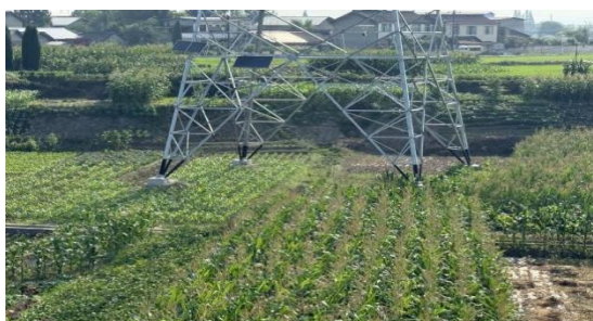
3、古城—双福I、II回 \pi 入德阳南220kV线路 NA63现状
