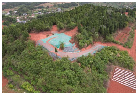
NB14 塔基临时苫盖施工道路土袋拦挡
