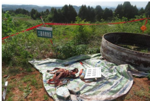
AN2 塔基临时铺垫
