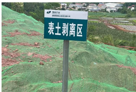
Z68 塔基表土剥离
