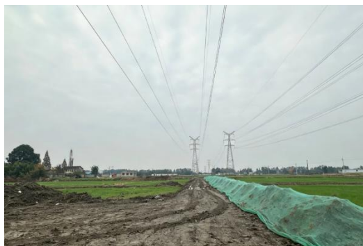
NB62 施工道路表土剥离
