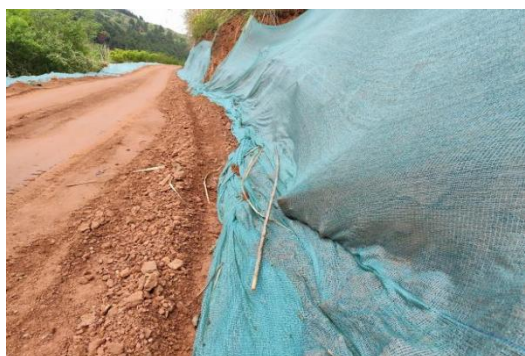
NB26 塔基道路临时排水沟
