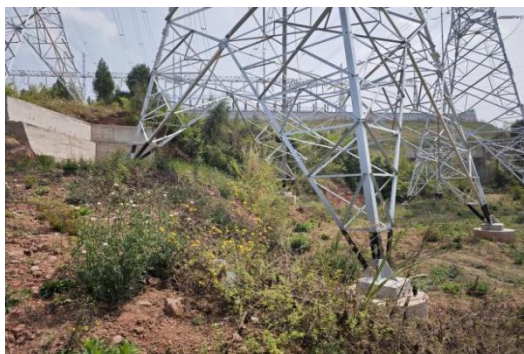
NB1 塔基挡土墙
