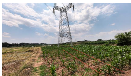
4、绵州—南华I、II回220kV线路绵华二线#41G塔位塔位施工道路现状
