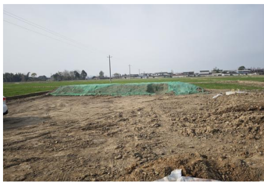
NB50 塔基表土剥离
