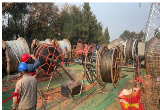
N2 塔基附近张力场临时铺垫
