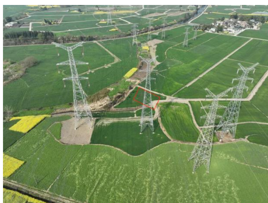
1、古城—双福I、II回 \pi 入德阳南220kV线路NB79塔位附近牵张场现状
