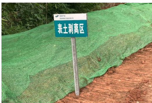
Z36 施工道路表土剥离
