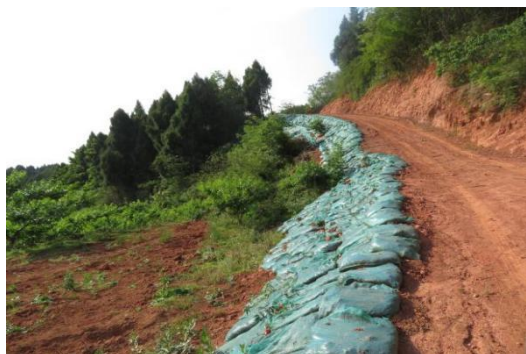
NB12 塔基施工道路土袋拦挡
