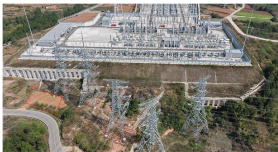
3、云绣—南华II回、绵州—南华II回 \pi 入德阳南220kV线路AN5附近塔位牵张场
