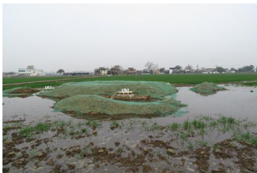
NA54 塔基表土剥离
