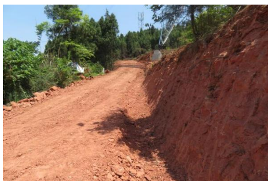
J3 (N6) 塔位施工道路临时排水沟
