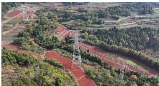
5、绵州—南华I、II回220kV线路新建N6塔位 现状
