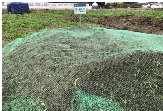
NA48 塔基表土剥离
