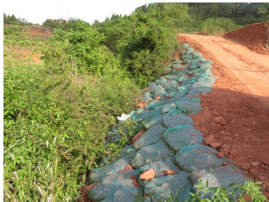
NA19施工道路 (2024.5)
