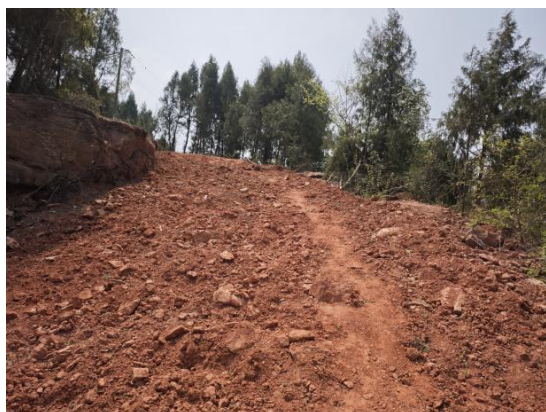
N9施工道路（2025.4）
