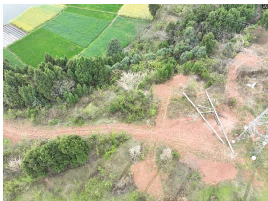
绵华二线#62G (Z62) 施工道路 (2025.12)
