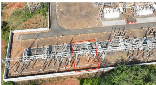
1、寿丰220kV变电站间隔扩建现状
