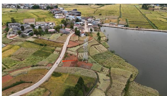
3、绵州—南华I、II回220kV线路绵华一线#74G塔位塔位施工道路现状
