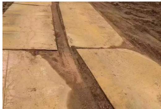
AN2 道路铺设钢板
