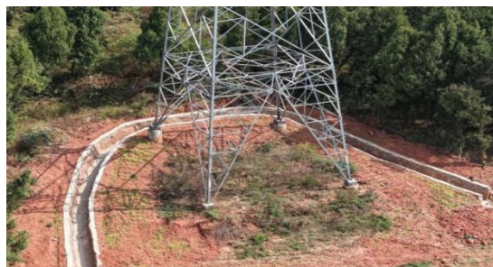
6、云绣—南华II回、绵州—南华II回 \pi 入德阳 南220kV线路AN1塔位现状
