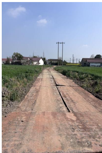
NB34 塔基施工道路铺设钢板
