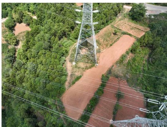
AN4施工道路 (2024.9)
