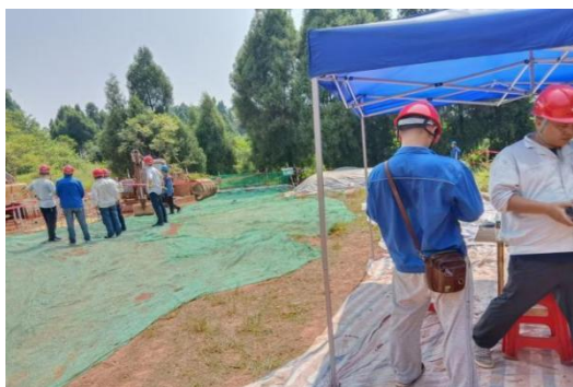
H5 塔基表土剥离
