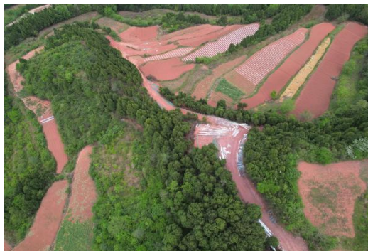
NA9、NB10 塔基施工道路土袋拦挡
