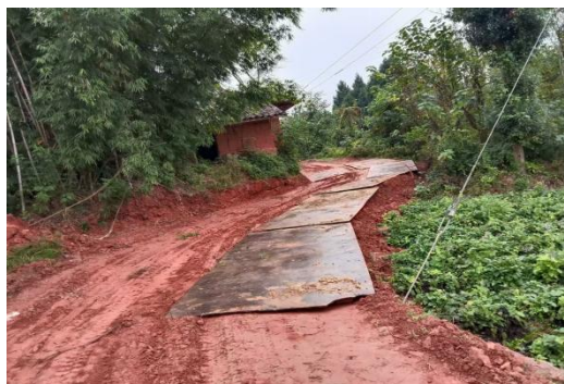
N5 道路铺设钢板
