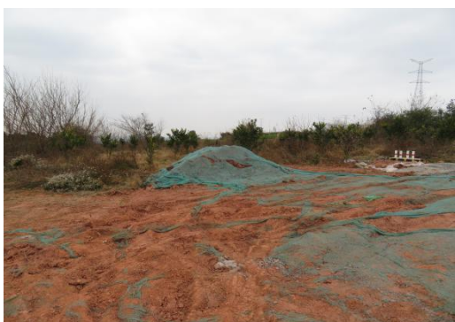
NA3塔基区表土剥离（2023.12）
