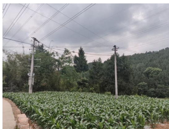
德阳南—寿丰220kV线路N18-N19跨越架（施工后）
