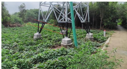
1、电缆施工区现状 (古城—双福I、II回 \pi 入德阳南220kV线路工程电缆段)
