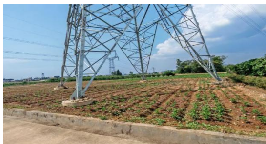
2、古城—双福I、II回 \pi 入德阳南220kV线路 NB33塔位现状
