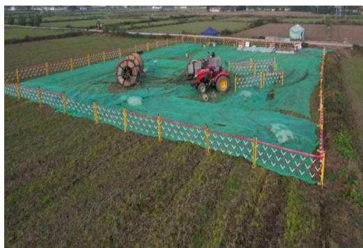
NB79 附近牵张场临时铺垫
