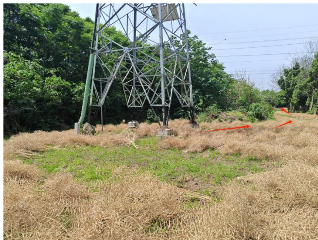
古城—双福I、II回 \pi 入德阳南220kV线路工程电缆通道现状
