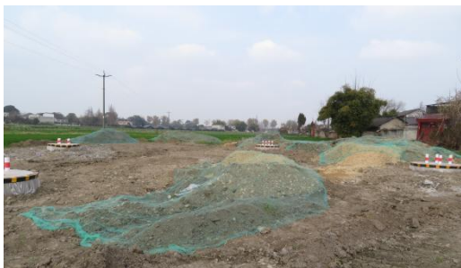
NB50塔位区表土剥离、土石方苫盖（2024.1）
