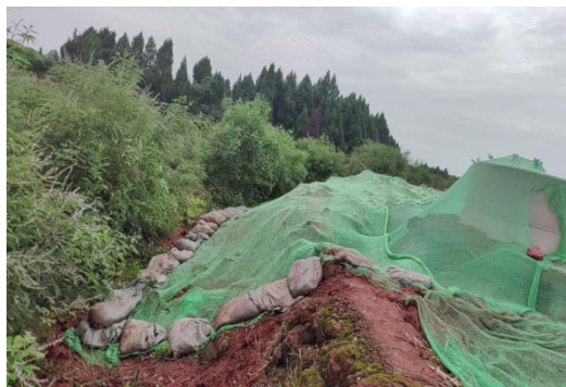
N14 土袋拦挡、临时遮盖
