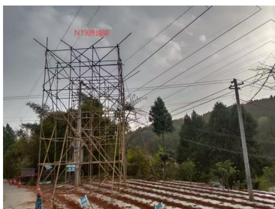
德阳南—寿丰220kV线路N18-N19跨越架（施工中）
