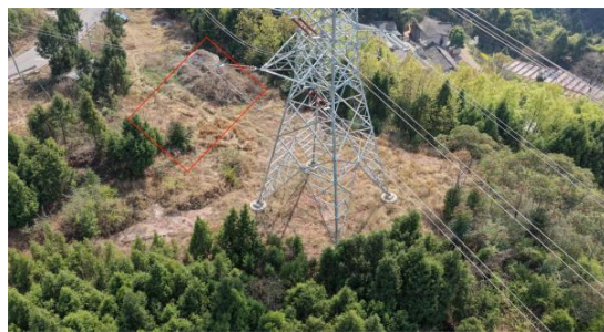
4、德阳南—寿丰双回、德阳南—云绣双回220kV线路N2塔位附近牵张场现状
