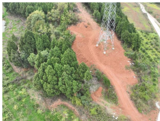
绵华一线#95G (Z95) 施工道路 (2025.12)
