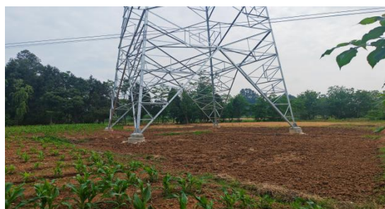
4、绵州—南华I、II回220kV线路绵华一二线 157#-1塔位现状
