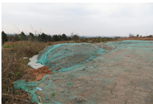
NA4 塔基表土剥离
