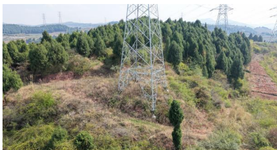
1、古城—双福I、II回 \pi 入德阳南220kV线路 NB14塔位现状
