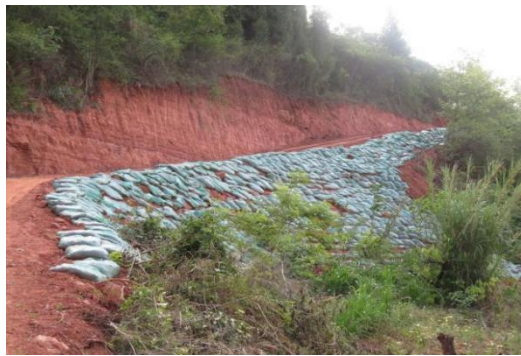
NA18 塔基施工道路土袋拦挡
