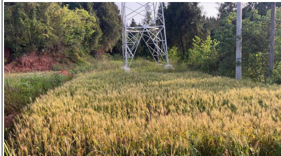
桂花-福德 35kV 线路工程 N50
