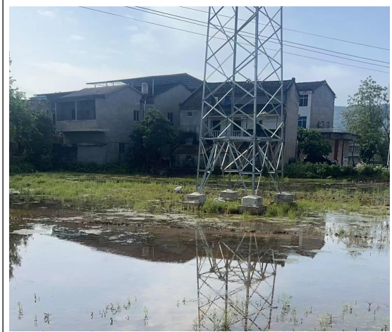
星火-福德 35kV 线路工程 N6
