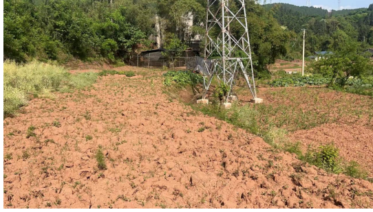
桂花-福德 35kV 线路工程 N25-塔基及道路
