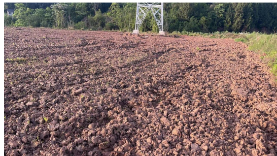
桂花-福德 35kV 线路工程 N20-塔基及道路
