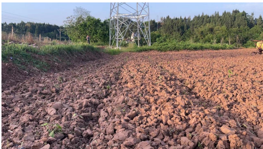
桂花-福德 35kV 线路工程 N17-塔基及道路
