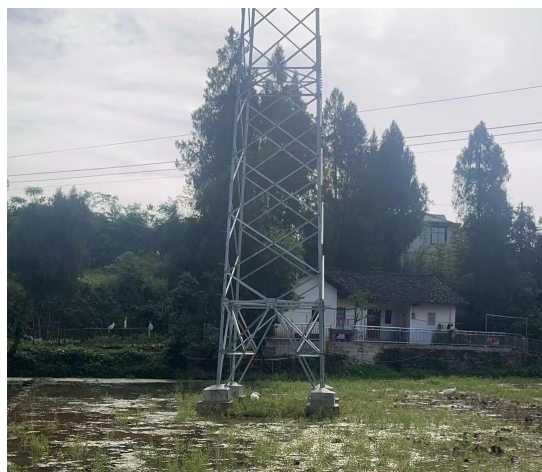
星火-福德 35kV 线路工程 N5
