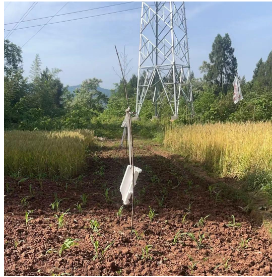
星火-福德 35kV 线路工程 N8
