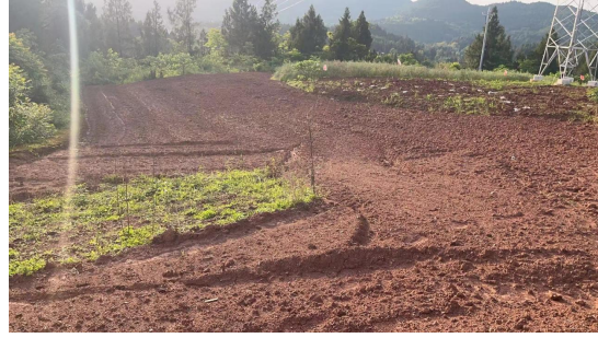
桂花-福德 35kV 线路工程 N35-塔基及道路
