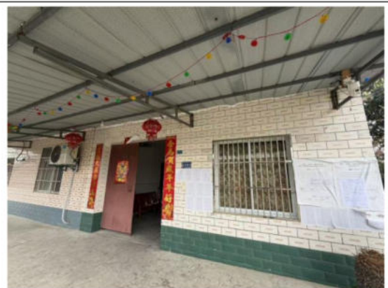
旌阳区柏隆镇隆兴桥村19组邱常亿公
