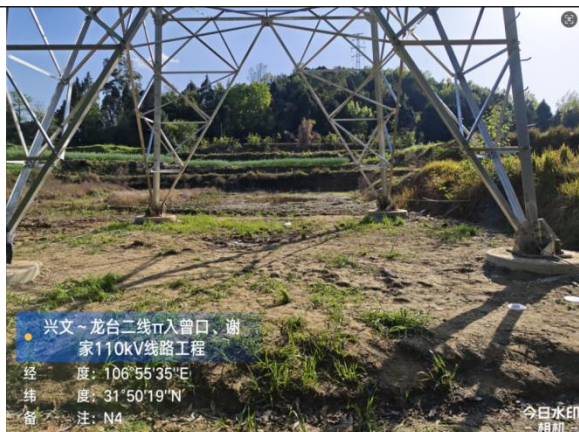
文龙二线 \pi 接线路 N4 塔土地整治、种草、临时排水沟
