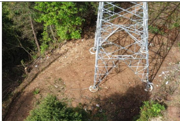
杨南改接线路 N30 塔覆土、土地整治、临时排
