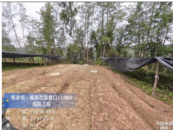
杨南改接线路 N16 塔覆土、土地整治
