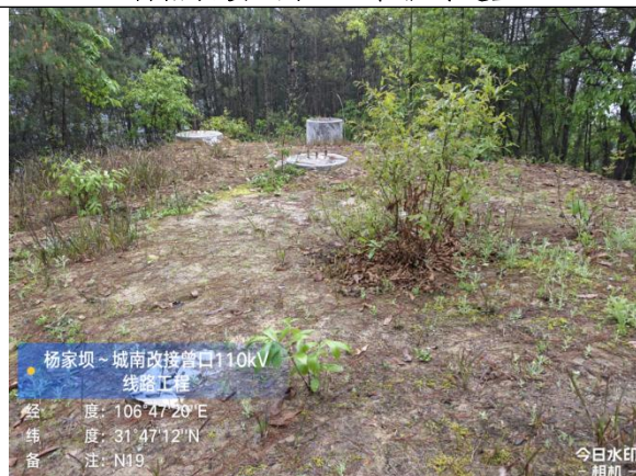
杨南改接线路 N19 塔基施工临时占地栽植灌木
