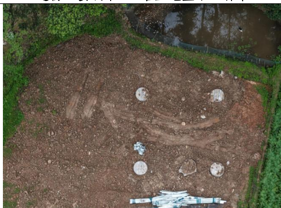
通杨 \pi 接线路 N28 塔覆土、土地整治
