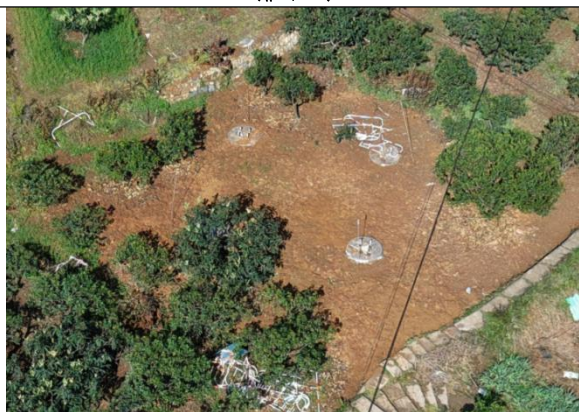
通杨 \pi 接线路 N1 塔覆土、土地整治
