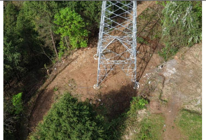
杨南改接线路 N30 塔未及时采取土地整治、植被恢复
