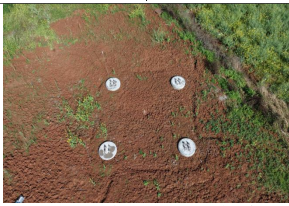
通杨 \pi 接线路 N5 塔覆土、土地整治
