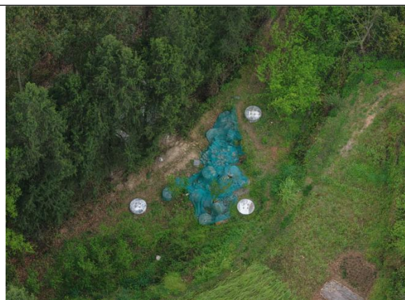
杨南改接线路 N4 塔临时遮盖
