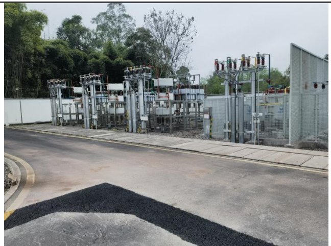
原有 10kV 无功补偿装置
