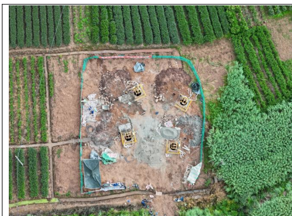
N47 塔基处土质排水沟 (2025.4)
