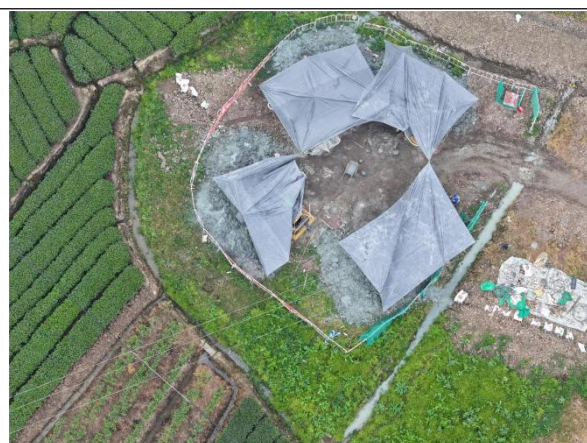
N19 塔基处土质排水沟 (2025.4)
