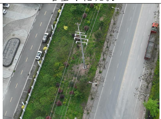
塔基绿化现状
