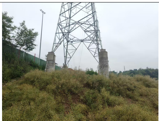
塔基绿化现状
