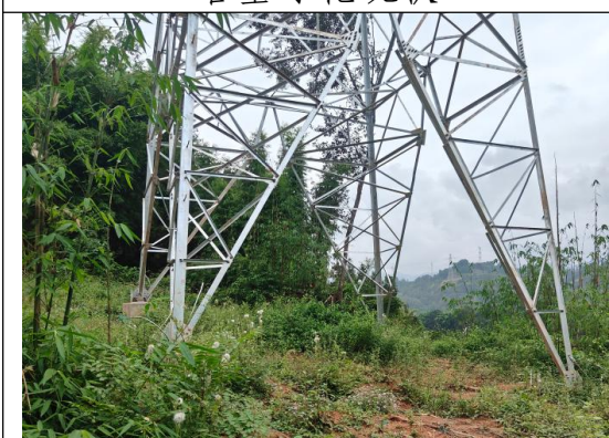
塔基绿化现状
