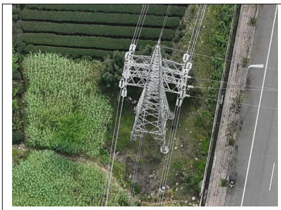
塔基绿化现状
