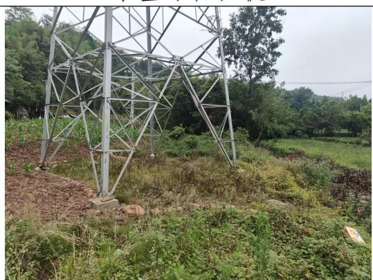
塔基绿化现状
