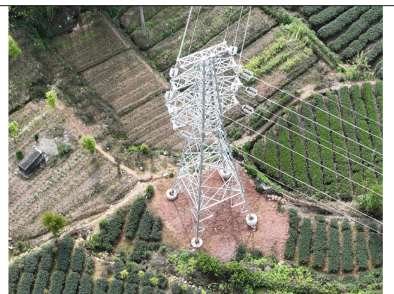
塔基复耕现状
