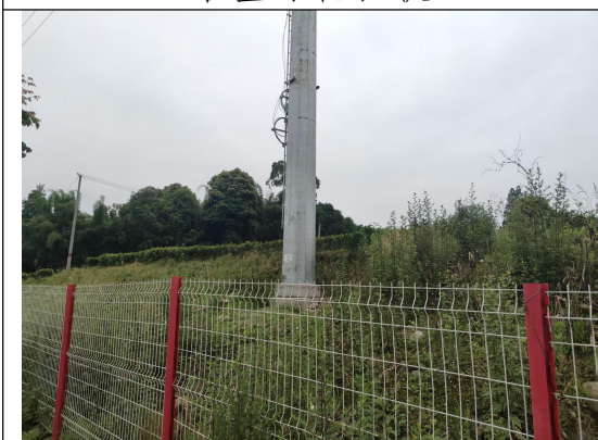
塔基绿化现状
