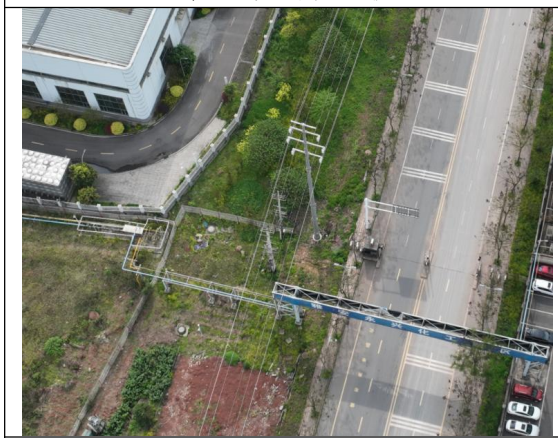
塔基绿化现状
