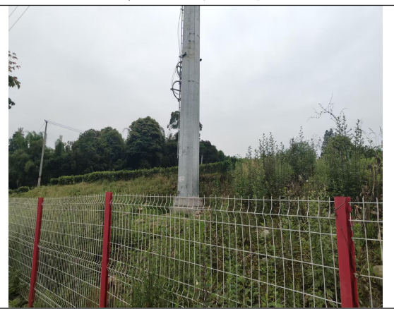
塔基绿化现状
