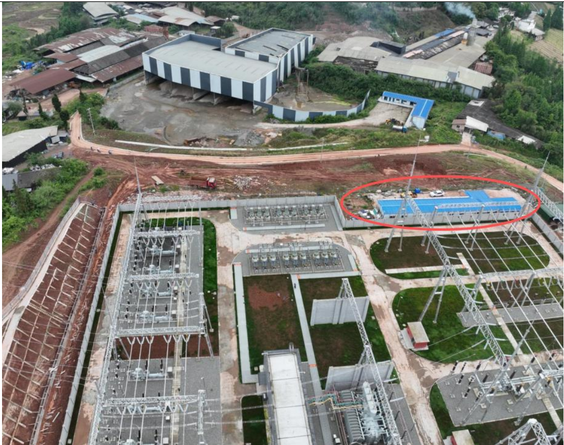
施工场地现状
