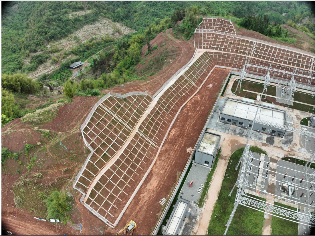
变电站边坡施工现状
