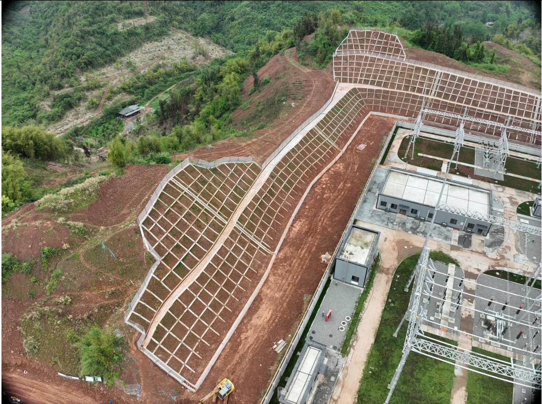
变电站边坡施工现状
