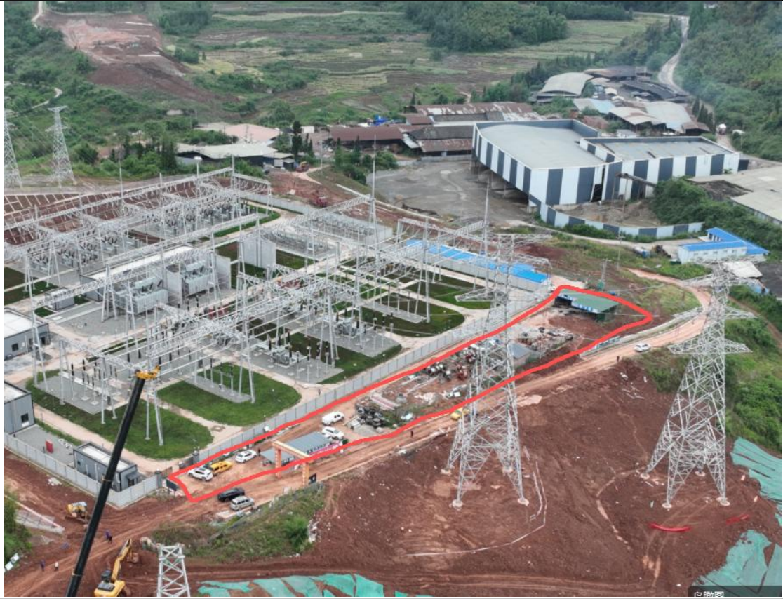
施工场地现状
