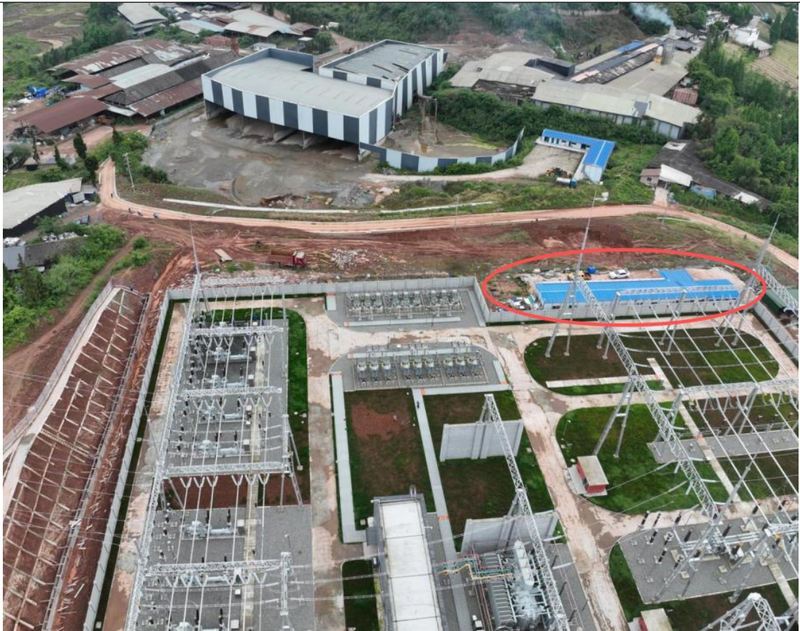
施工场地现状
