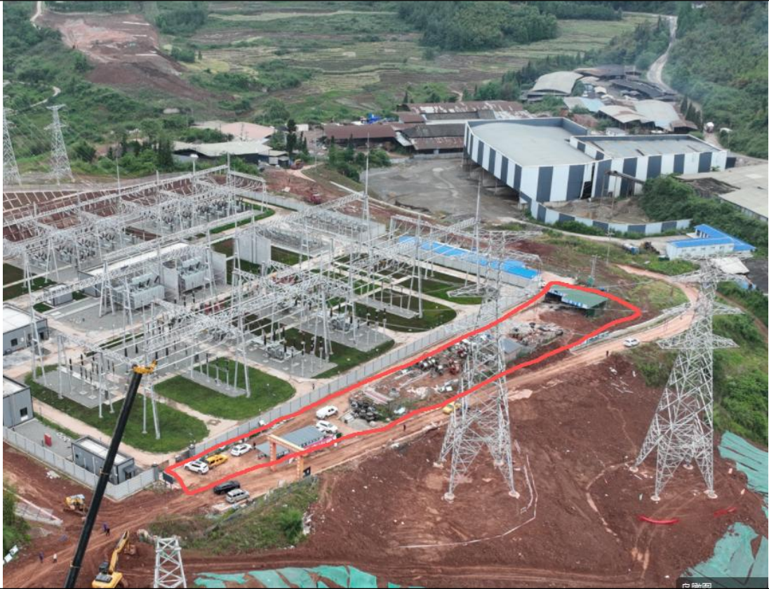
施工场地现状
