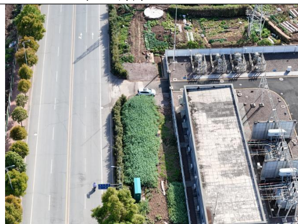
电缆沟播撒草籽、植被恢复 (2026.3)
