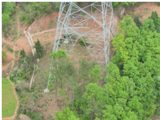
4、N147塔位现状（2026.3）
