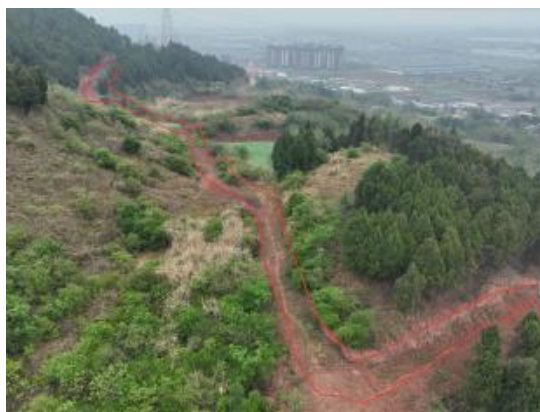
4、N121施工道路现状（2026.3）
