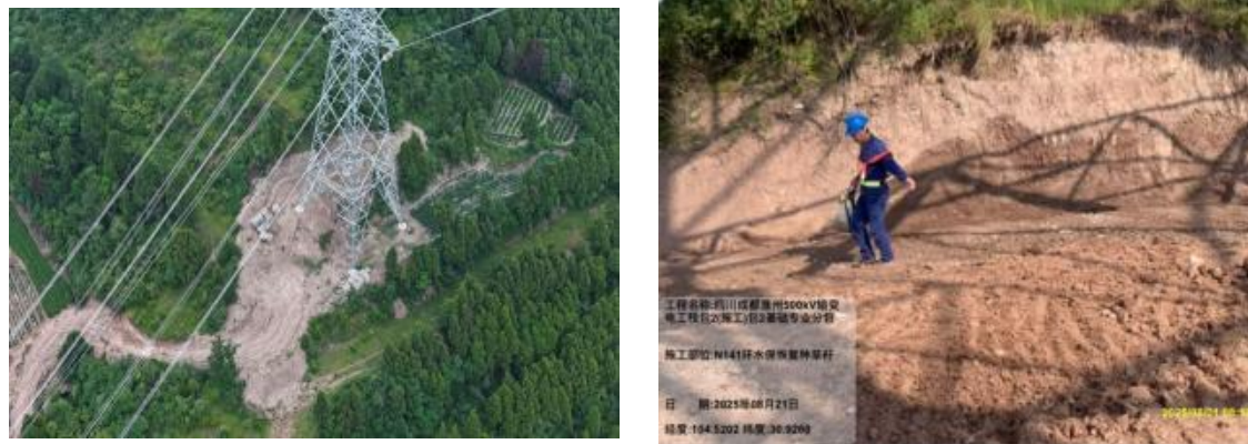
N141塔基施工道路改前后对比照片
