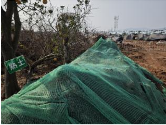
N111塔位表土剥离（时间：2025.1）
