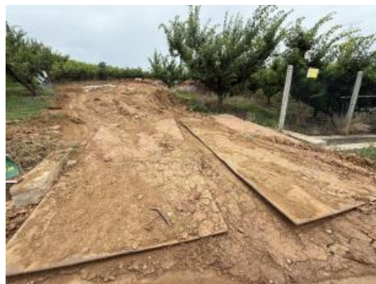
N116塔位施工道路钢板铺设
