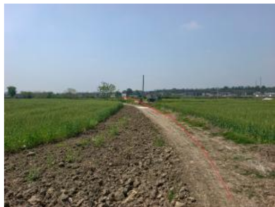
N301施工道路
