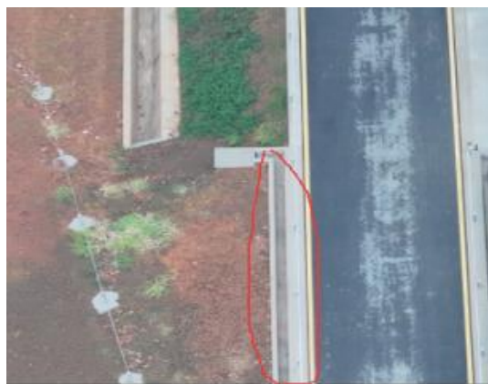
进站道路排水沟
