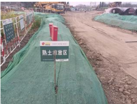
N385塔位表土剥离（时间：2025.4）
