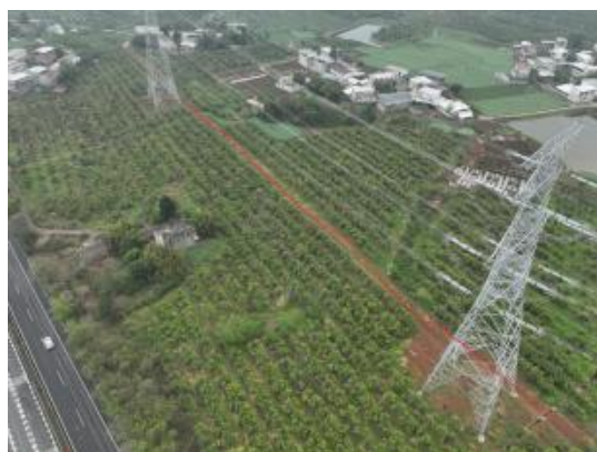
N112-113 施工便道恢复
