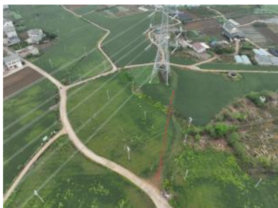
1、N114-1A施工道路现状（2025.12）
