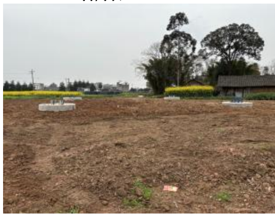
土地整治 N118 塔基
