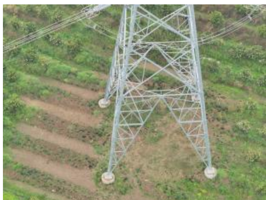
6、N111塔位现状（2026.1）
