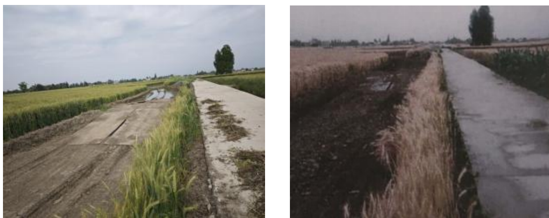
N353施工道路整改前后对比照片
