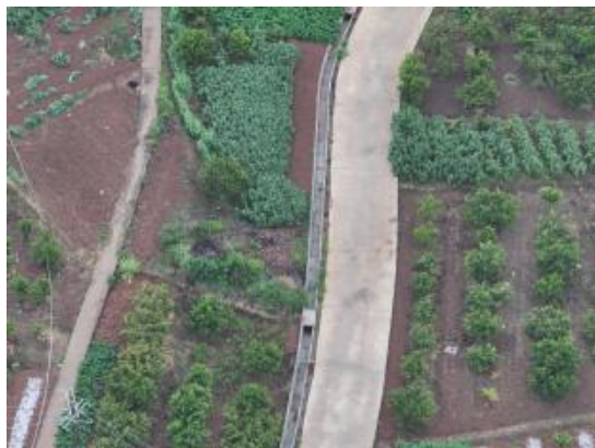
8、还建沟渠现状（2026.3）
