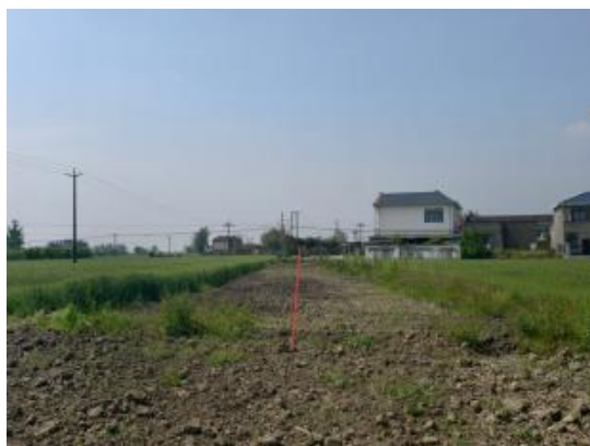
N310 施工便道恢复
