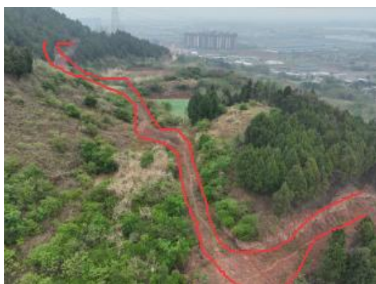
N121 施工便道恢复
