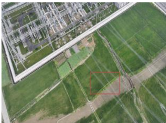
3、N392塔位附近牵张场现状（2026.3）
