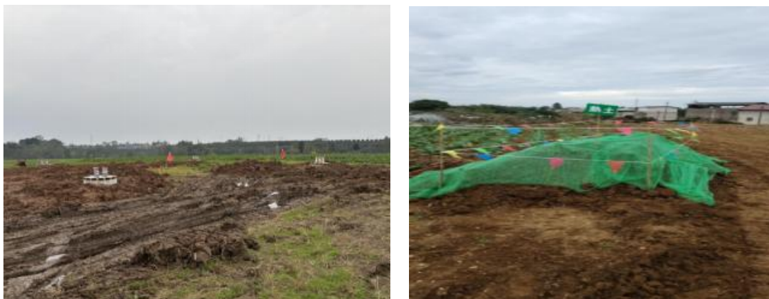
N102塔基整改前后对比照片
