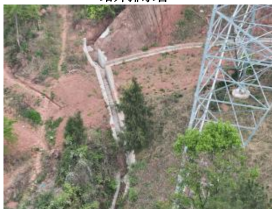
浆砌石排水沟 (淮州-德阳南 N147)
