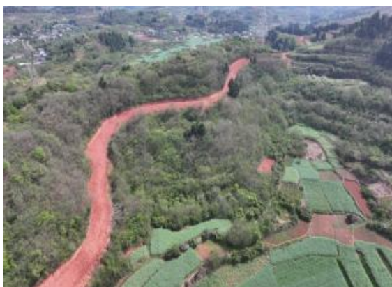
5、N205施工道路现状（2026.3）
