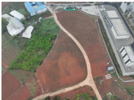
6、施工营地现状 (2026.3)
