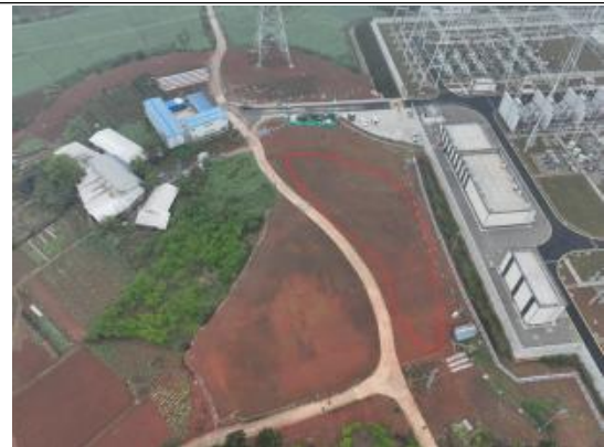
施工项目部（现状恢复）
