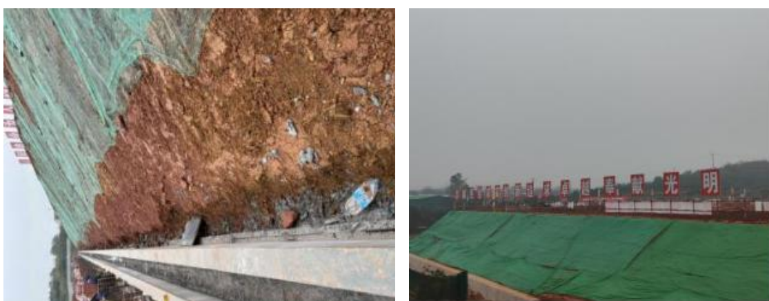
变电站围墙边坡整改前后对比照片
