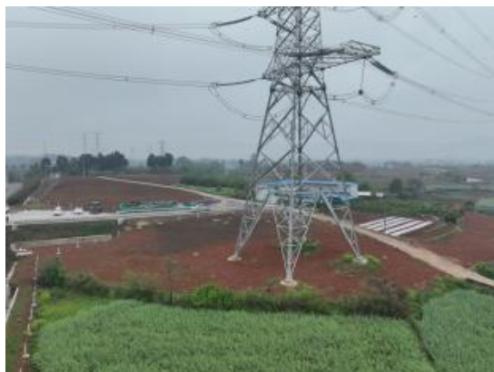
2、N101塔位现状（2026.3）
