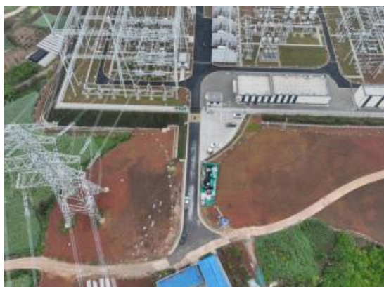
3、进站道路现状 (2026.3)
