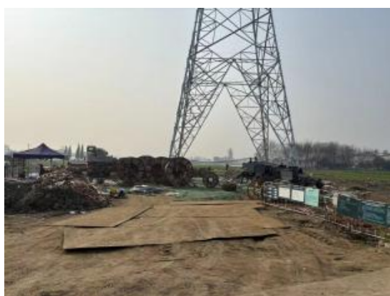
N337塔位施工道路钢板铺设
