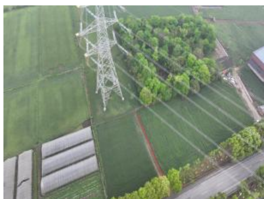
N341 施工便道恢复
