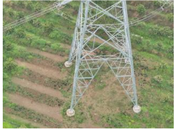
N111塔位表土回覆（时间：2025.10）
