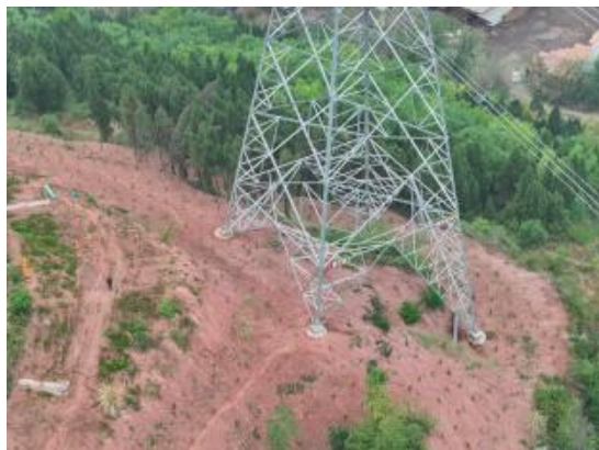
3、N126塔位现状（2026.1）
