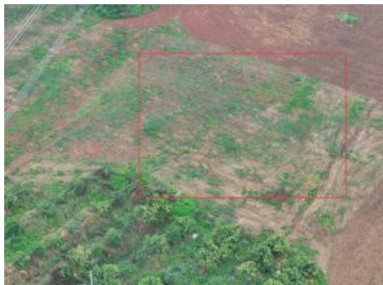
1、N113-114塔位牵张场现状（2026.3）
