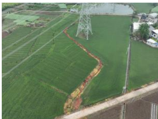
N110 施工便道恢复
