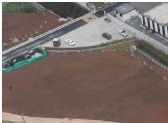
1#表土堆场（现状恢复）
