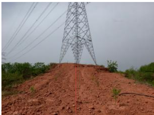
N203施工道路
