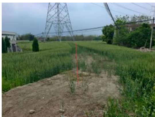
N316 施工便道恢复
