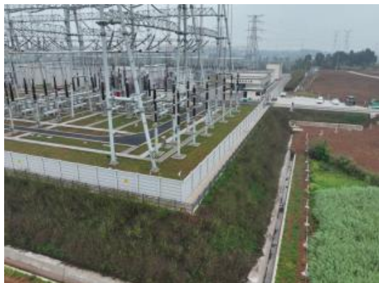
1、挖方边坡现状 (2026.3)
