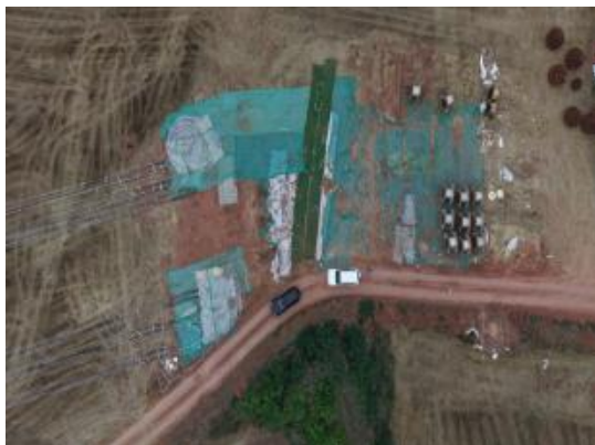
N113-114 牵张场（施工中）
