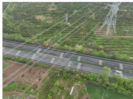
4、N110-110塔位附近跨越现状（2026.3）
