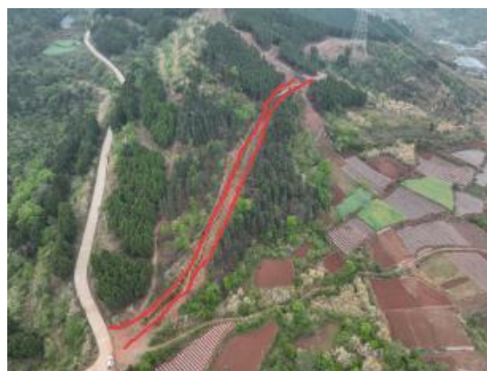
N124 施工便道恢复
