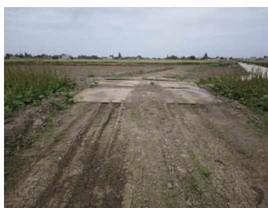
N353塔位施工道路钢板铺设
