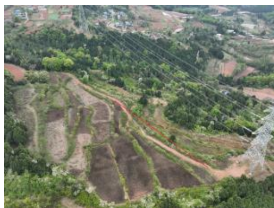
N154 施工便道恢复
