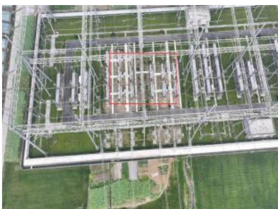
10、什邡变电站间隔扩建现状（2025.10）
