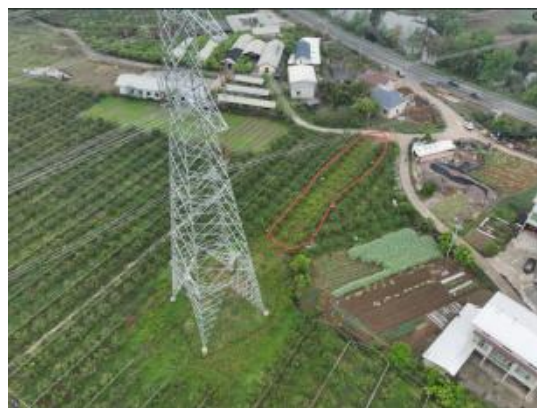
N106 施工便道恢复
