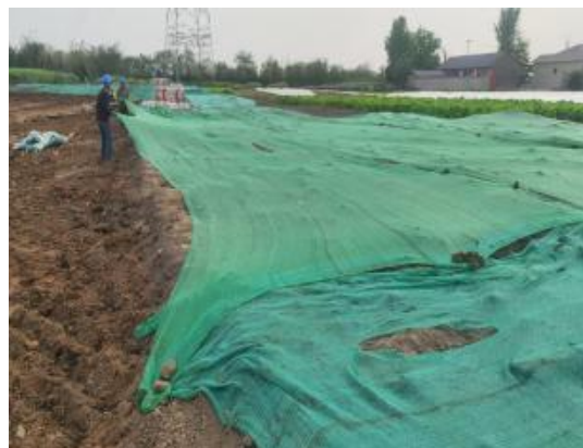
N385塔位临时遮盖
