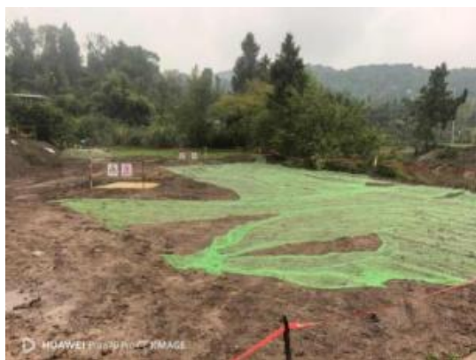
N006塔位临时遮盖
