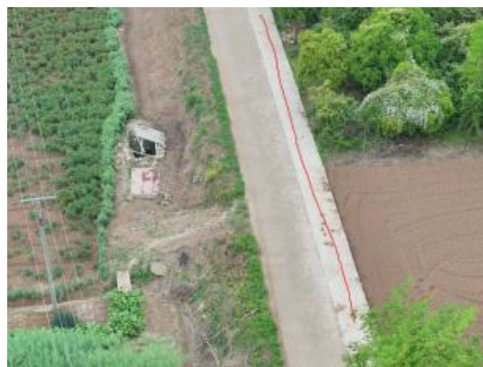
N0138施工道路拓宽
