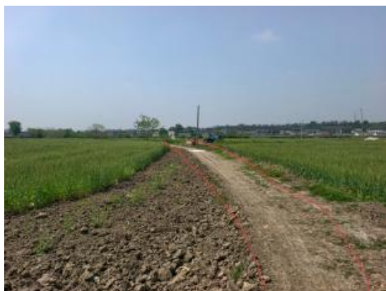
3、N301施工道路现状（2026.3）
