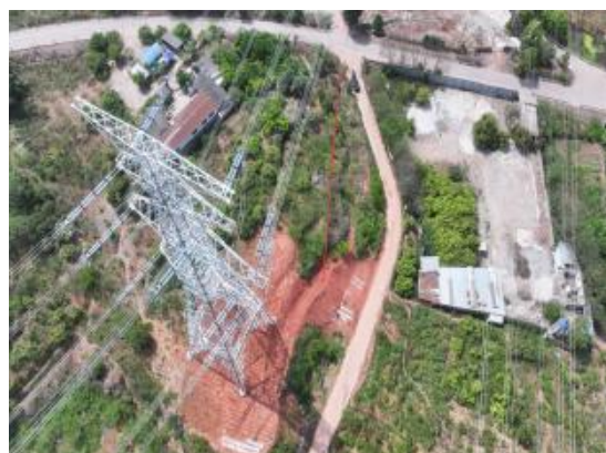
2、N208施工道路现状（2025.12）
