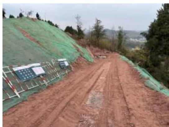
N124道路边坡临时遮盖
