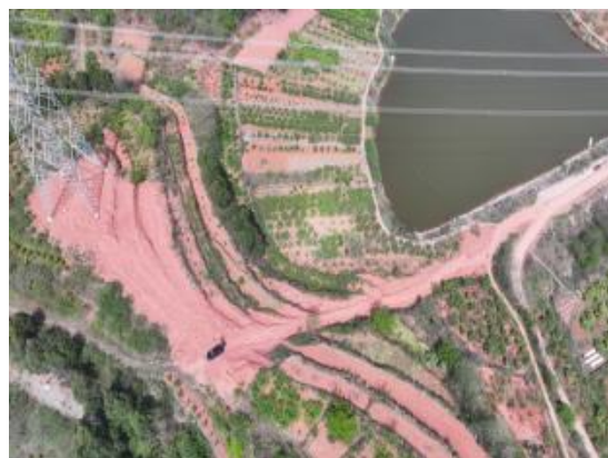
6、N203施工道路现状（2026.3）
