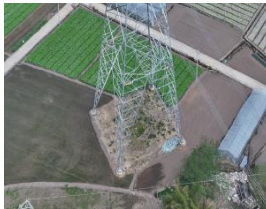
N385塔位表土回覆（时间：2025.12）
