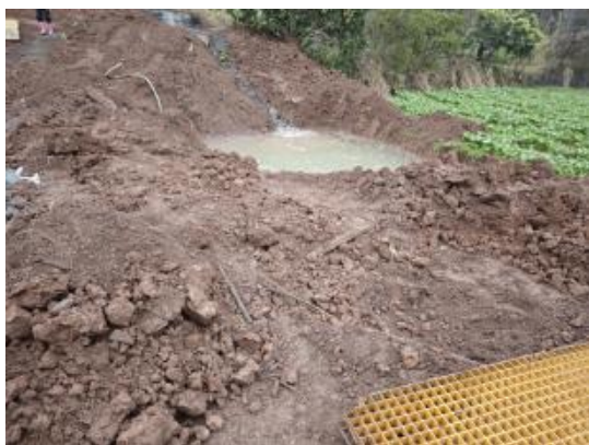
N006塔位泥浆沉淀池
