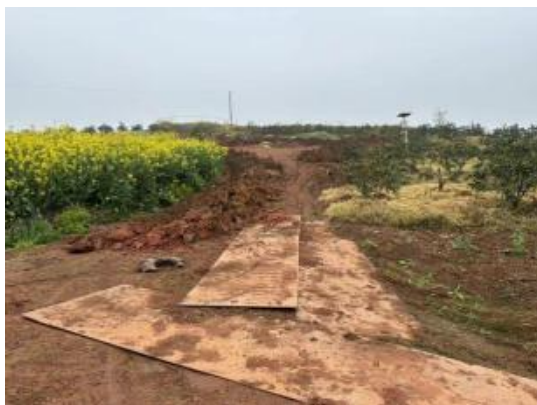
N115塔位施工道路钢板铺设
