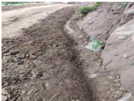
N041施工道路临时排水沟
