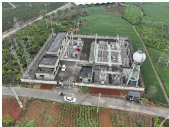
7、施工电源电杆现状（2025.12）
