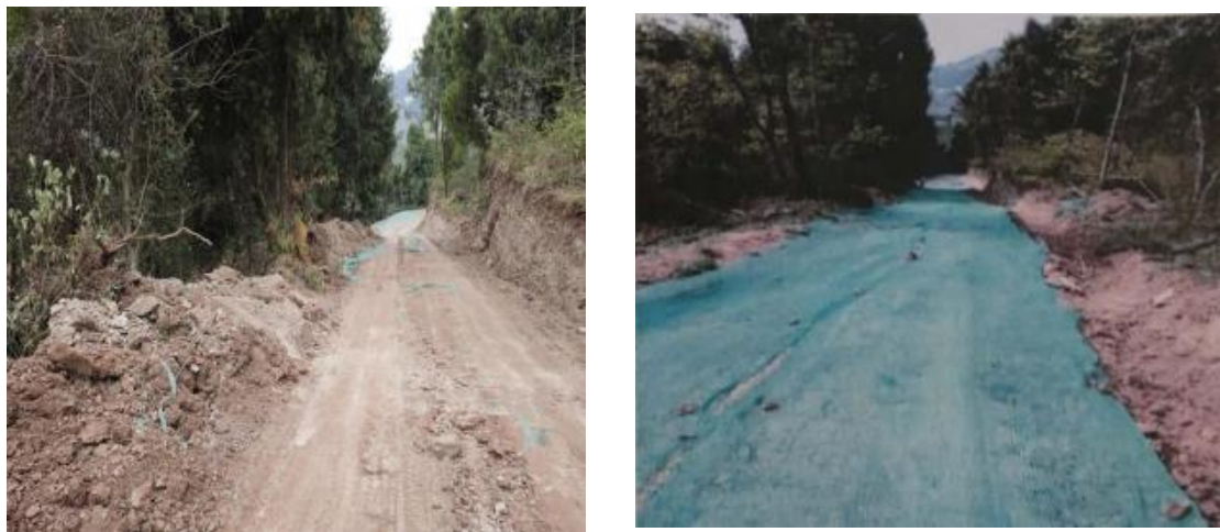
N141施工道路整改前后对比照片
