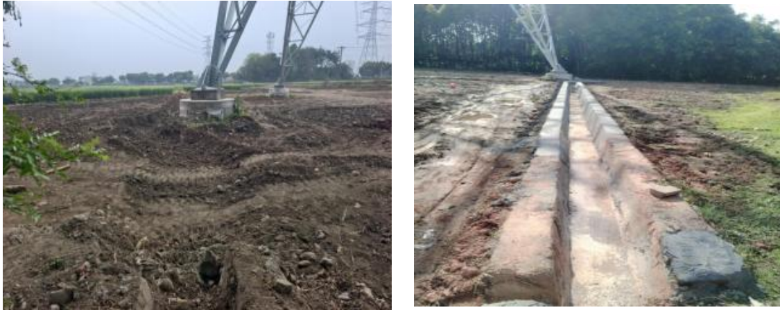
N316塔基施工道路整改前后对比照片
