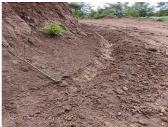
N027施工道路临时排水沟
