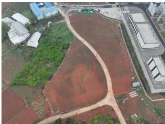
施工生产生活区土地整治
