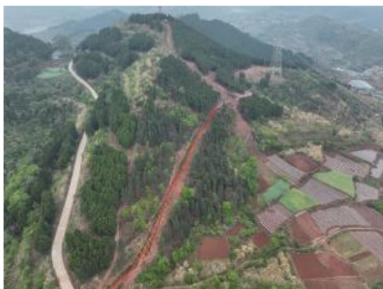
N124施工道路
