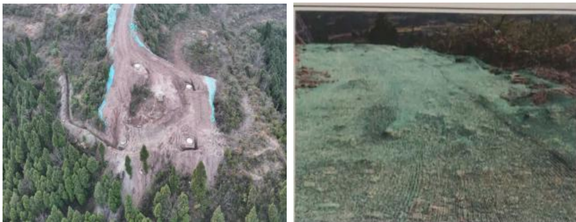
N142施工道路整改前后对比照片
