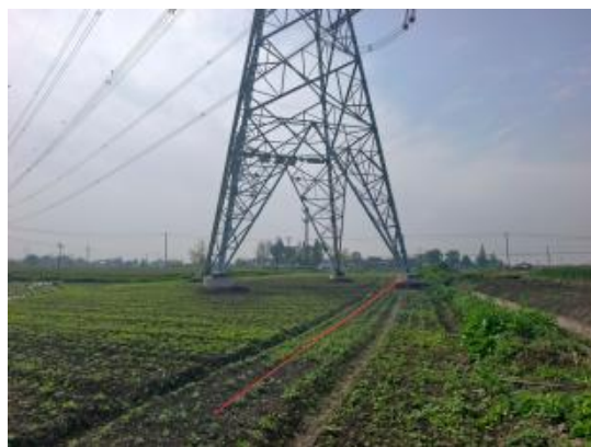
N313 施工便道恢复
