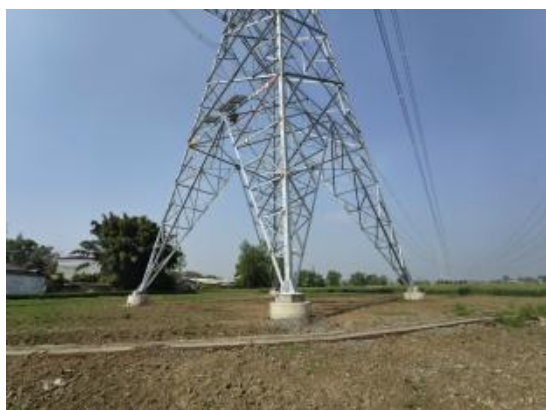
5、N311塔位现状（2026.3）
