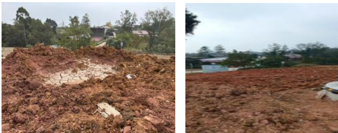
N109塔基整改前后对比照片
