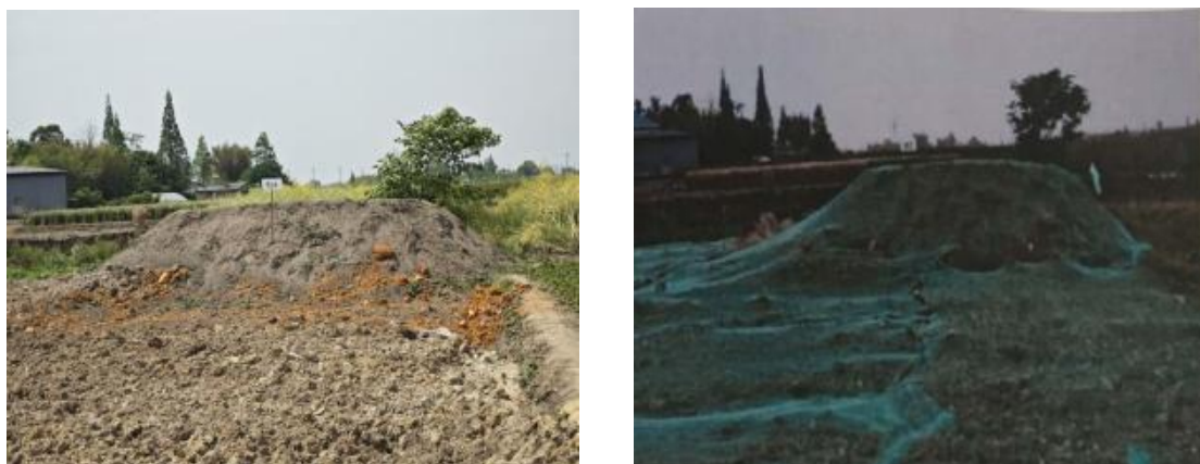
N362C塔基整改前后对比照片
