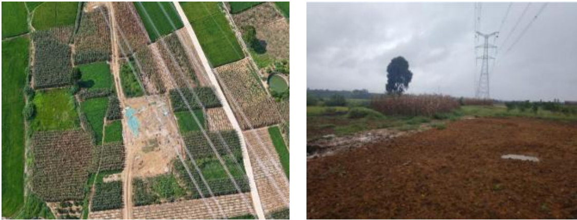
N107-108牵张场整改前后对比照片
