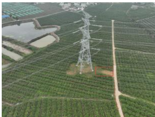
N105 施工便道恢复
