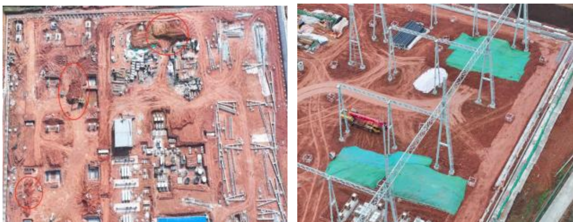
变电站临时堆土整改前后对比照片
