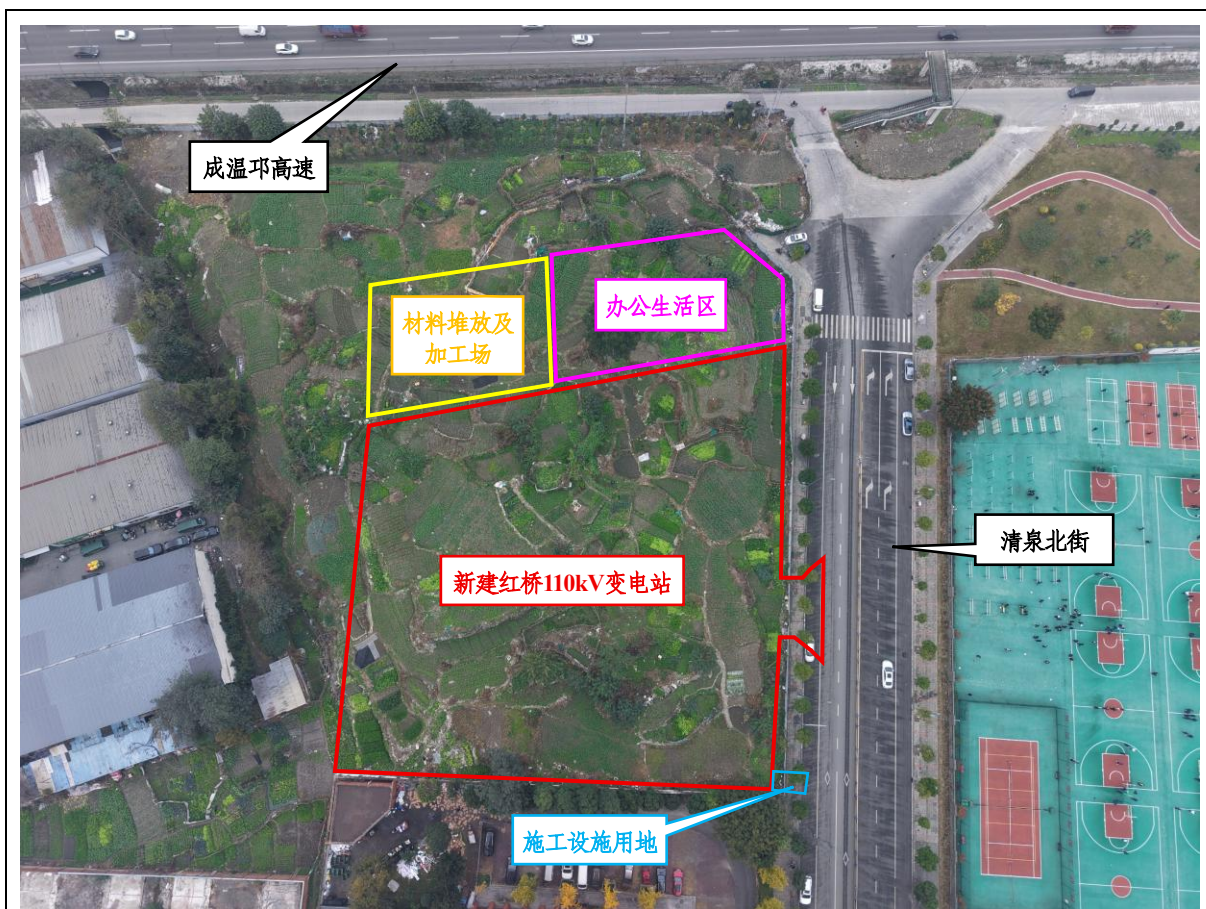
红桥 110kV 变电站现状
