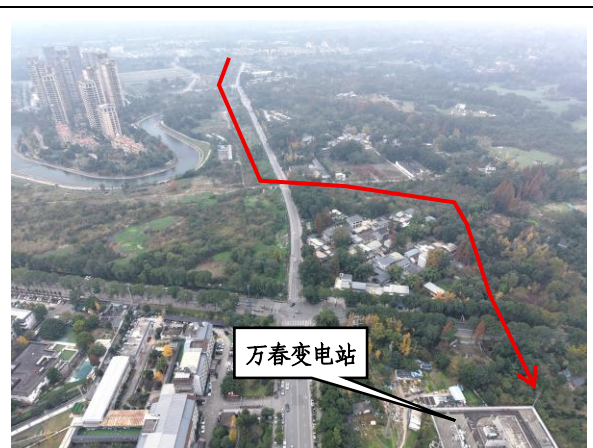
渡桥~万春、渡桥~红桥 110kV 线路改接沿线地形地貌（万春变电站附近）
