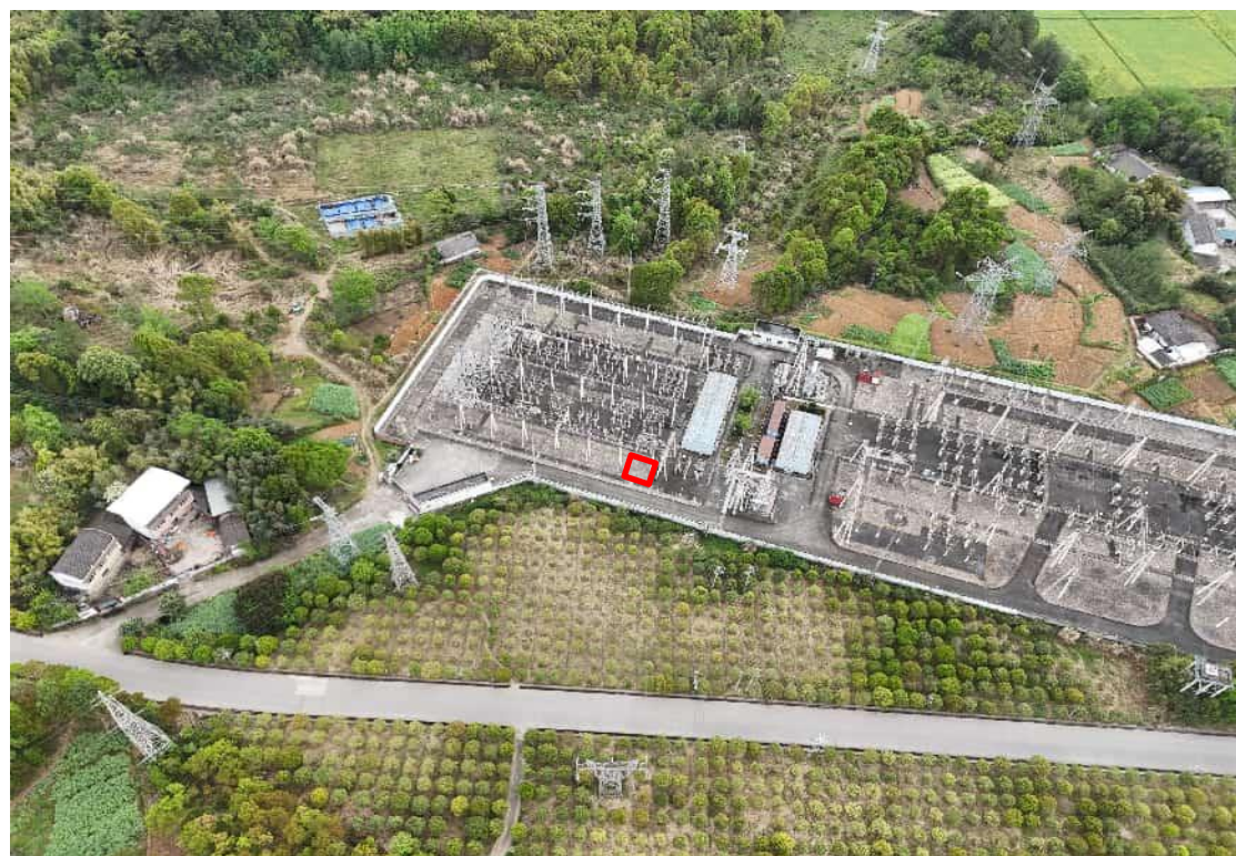
大康 220kV 变电站 110kV 间隔完善工程航拍图
