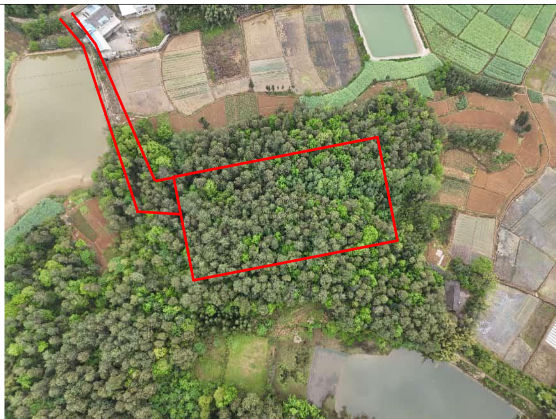
界池 110kV 变电站拟建站址航拍图
