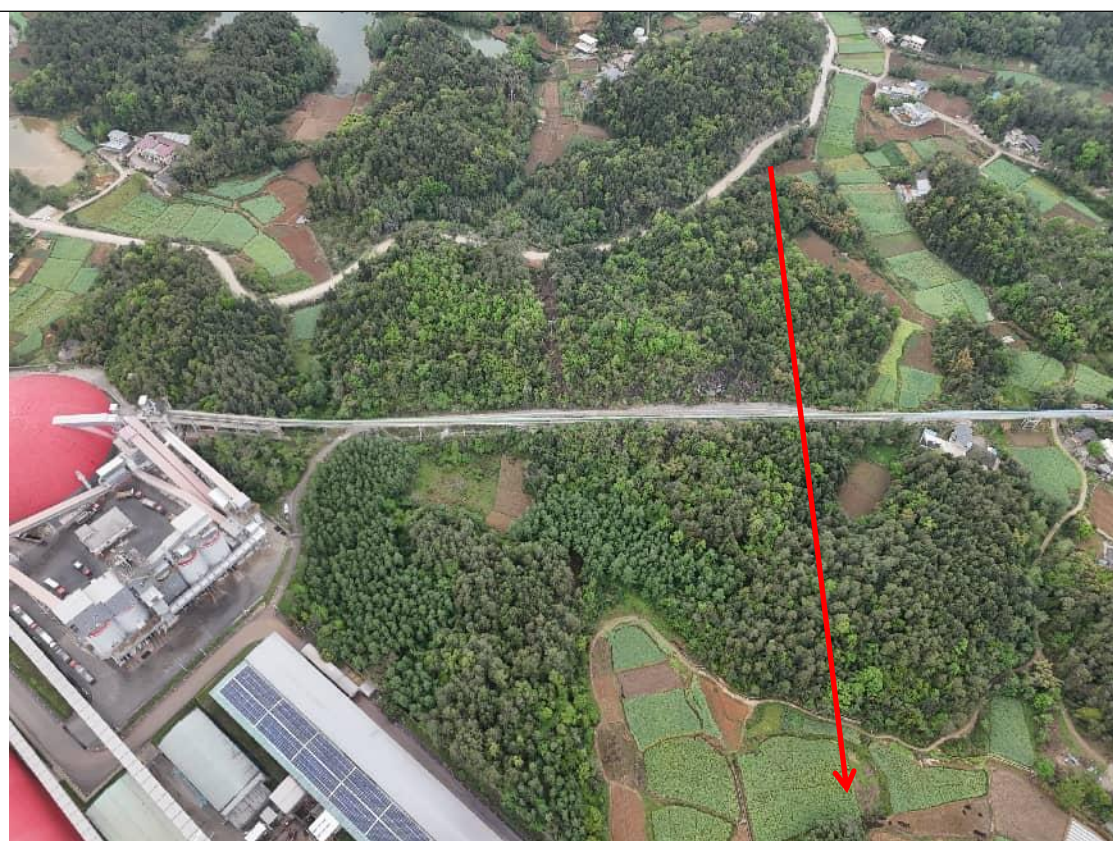
新建段跨越输油管道
