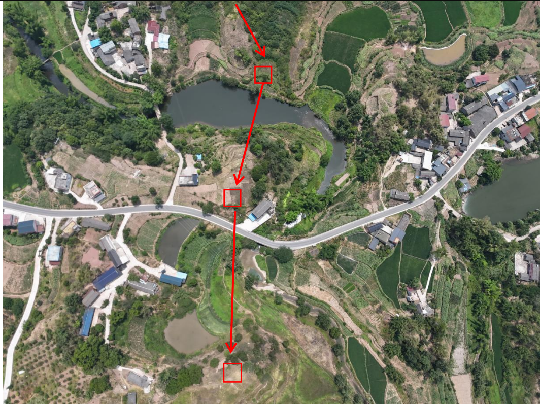
万安—飞龙35kV线路工程沿线地貌4
