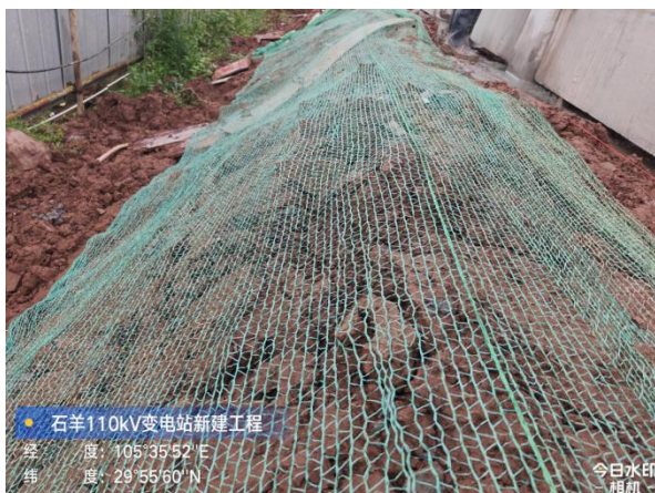
变电站临时遮盖
