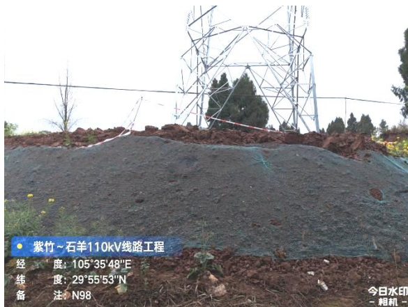
N98 临时遮盖
