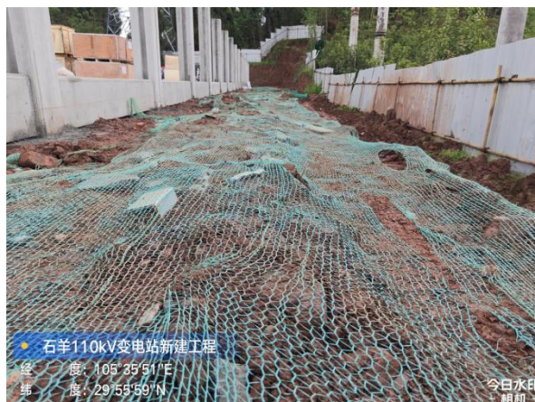
变电站临时遮盖
