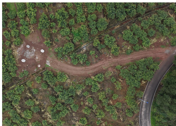
紫竹~石羊N4汽运道路未采取临时铺垫
