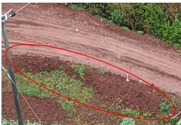
N60 汽运道路表土剥离
