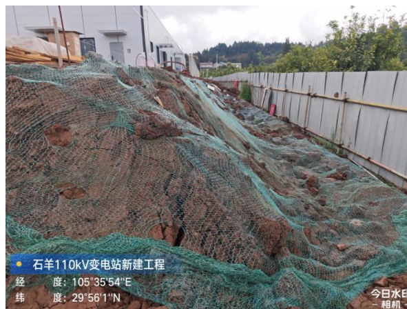
变电站临时遮盖
