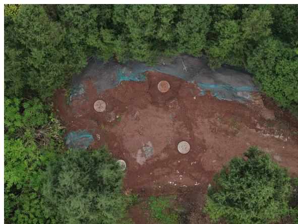
N10 临时遮盖
