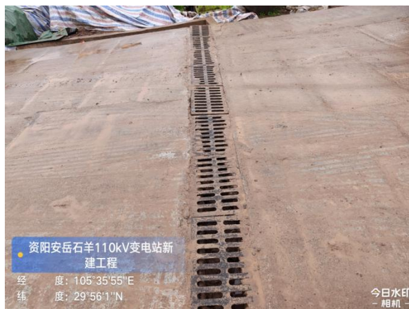
变电站临时排水沟
