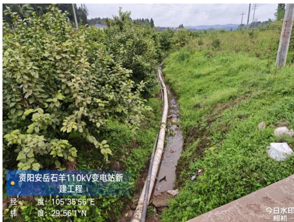
施工生产生活区临时排水管
