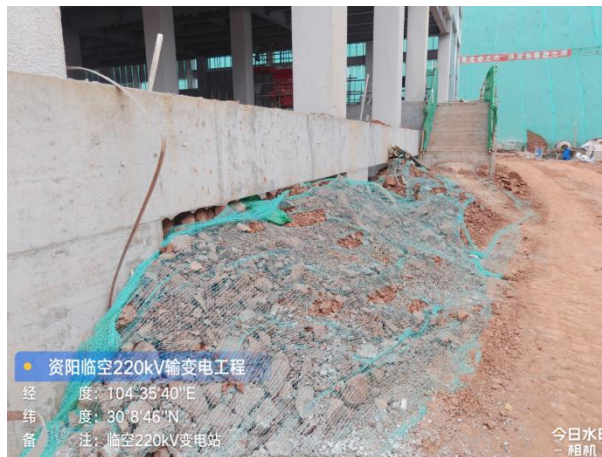
变电站临时遮盖
