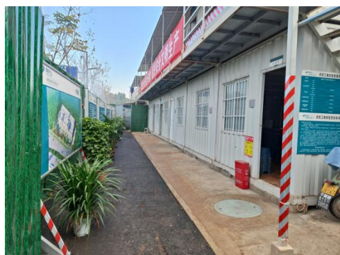
施工生产生活区现状
