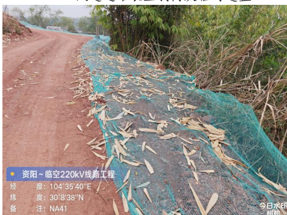
NA41 汽运道路临时遮盖
