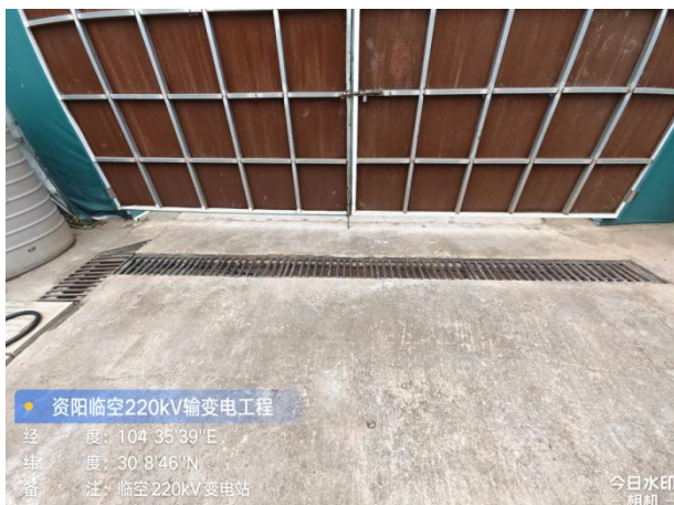
变电站临时排水沟
