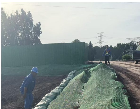
施工便道临时遮盖、土袋拦挡
