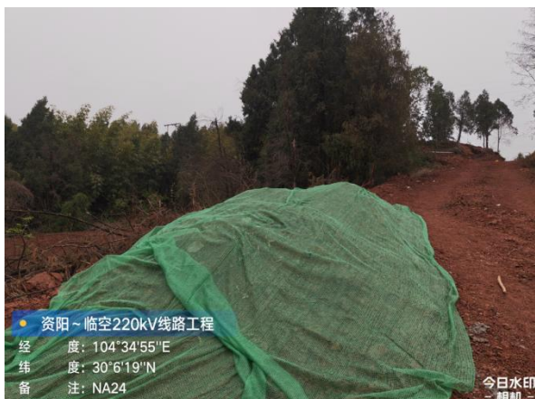
NA24 汽运道路表土剥离及临时遮盖
