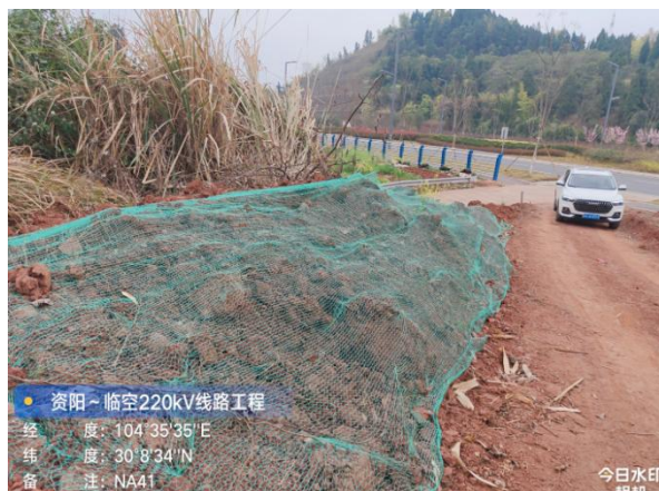
NA41 汽运道路表土剥离及临时遮盖
