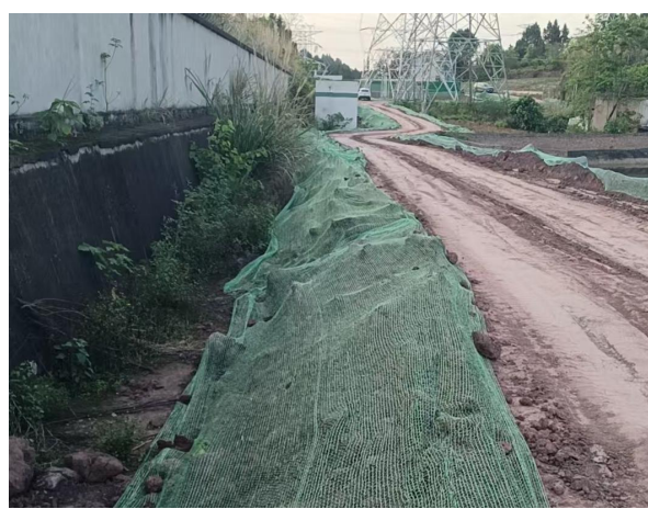
施工便道临时遮盖
