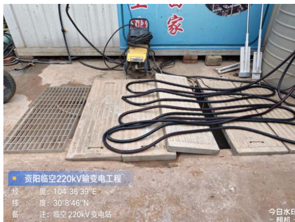
变电站临时沉沙池
