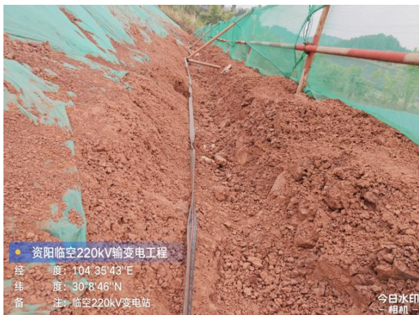
边坡马道临时排水沟
