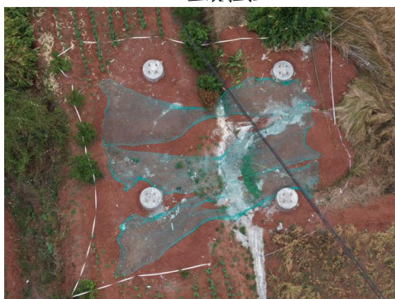
NB34 临时遮盖
