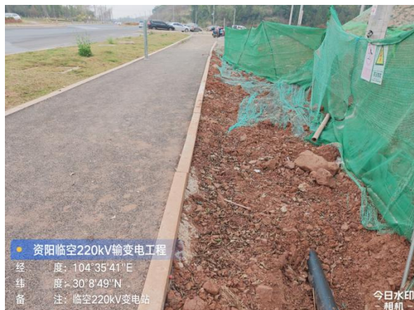
站外供水管线
