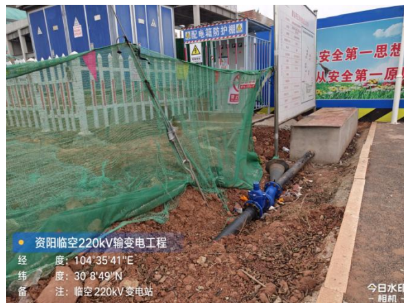
站外供水管线
