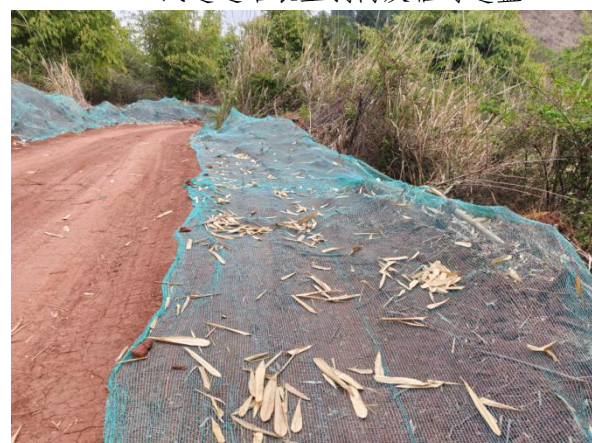
NB42 汽运道路临时遮盖
