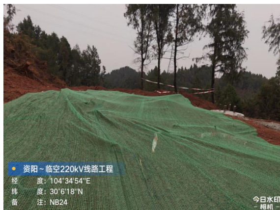
NB24 临时遮盖
