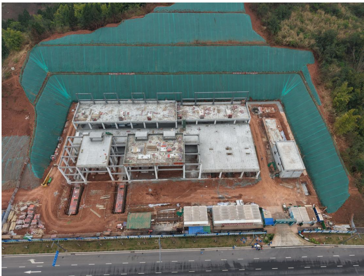
临空 200kV 变电站建设现状
