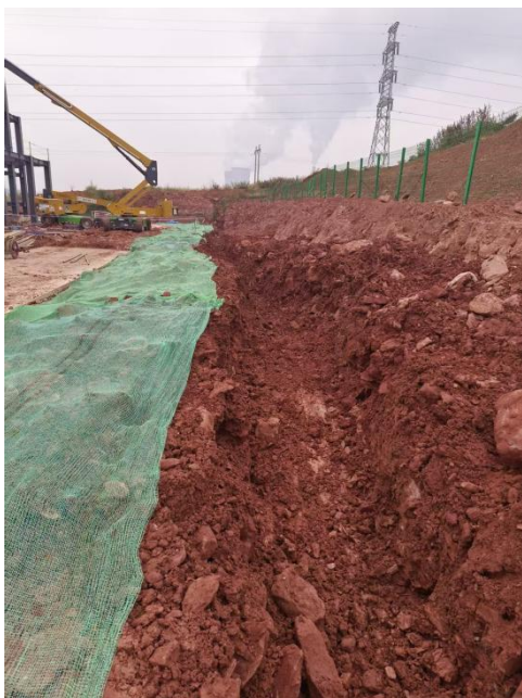
图8-5变电站内临时排水沟
