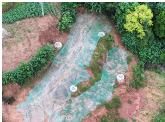
图8-3塔基区及施工道路密目网苫盖
