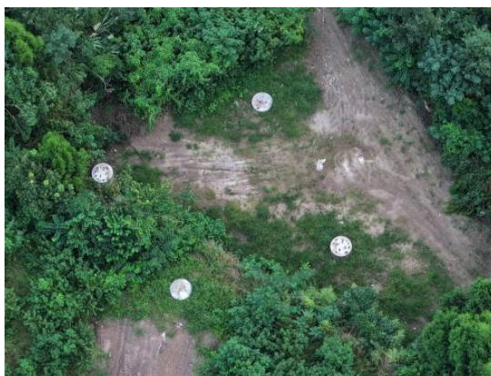
图8-2塔基区基础施工后进行场地整治
