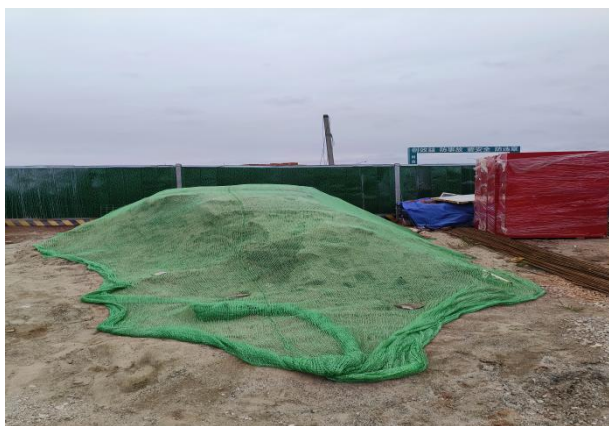
图8-6变电站临时苫盖
