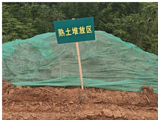
图8-4塔基区表土苫盖
