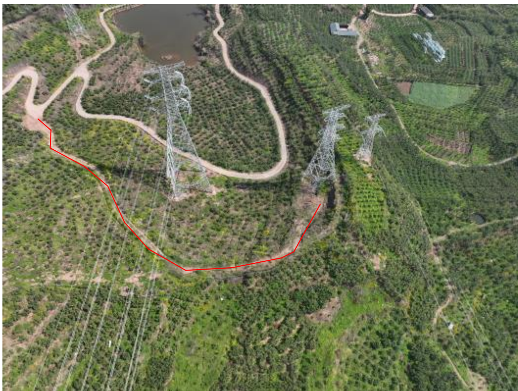
兴梦-鹤山 59 号施工道路未恢复
