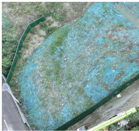
图8-4 变电站区临时堆土密目网苫盖
