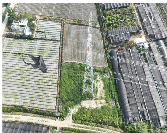
图8-5 架线塔基区已恢复植被
