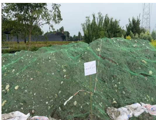
图8-2塔基区表土剥离及保护措施
