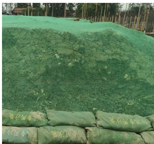
图8-3 变电站区表土剥离后密目网苫盖
